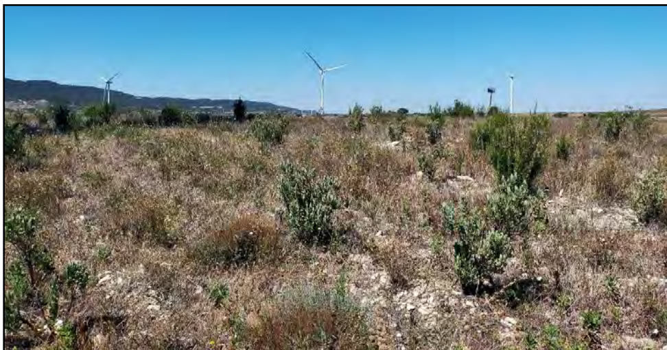
Fotografía 2. Evolución adecuada de la revegetación en el parque eólico La Peña (02/08/2023).
