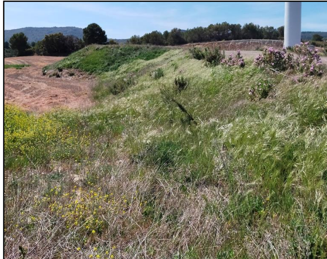
Fotografía 5. Desarrollo de la cubierta vegetal en la turbina LP10
