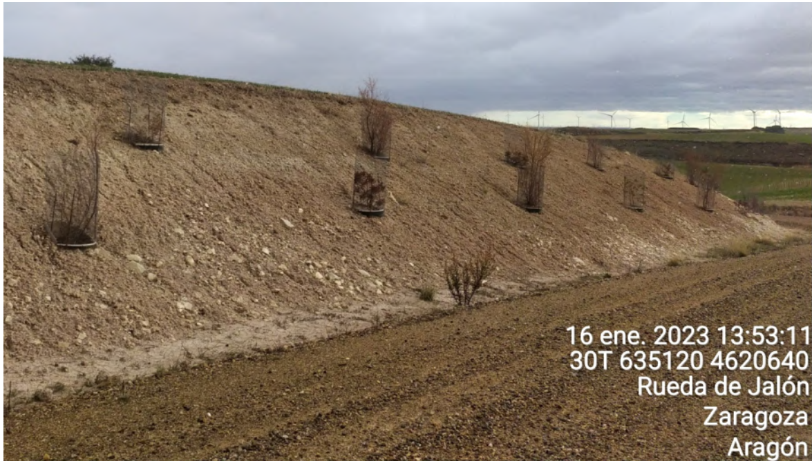
Figura 36: Otra sección de la rampa del vial entre ELL-4 y ELL3 mostrando especies arbustivas plantadas artificialmente en sus taludes.
