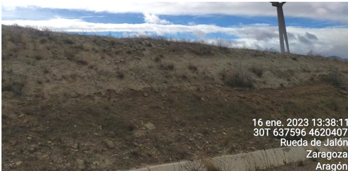
Figura 29: Talud de tierra vegetal restaurado entre aerogeneradores ELL11 y ELL10.
