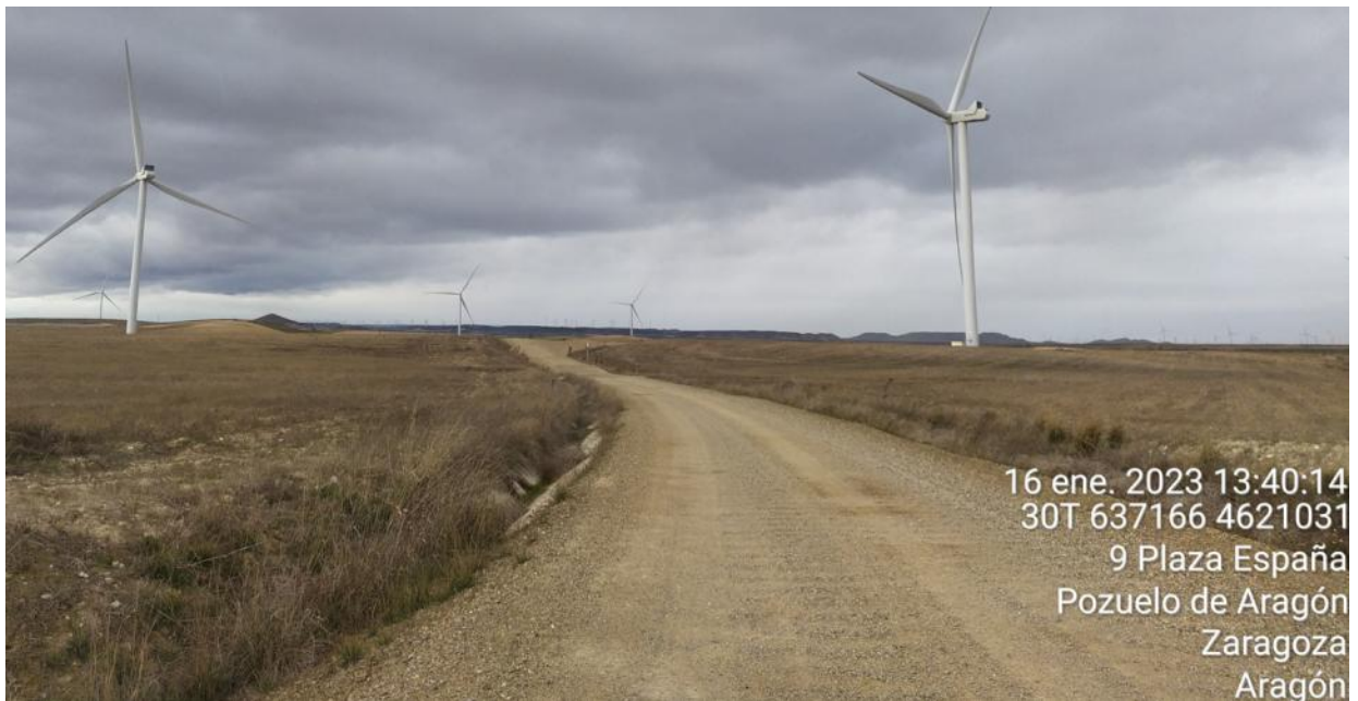
Figura 31: Vial de acceso entre aerogeneradores ELL10 y ELL9. A su derecha se ubica el campo de cultivo restaurado donde se localizó el Site Campo de Obra.
