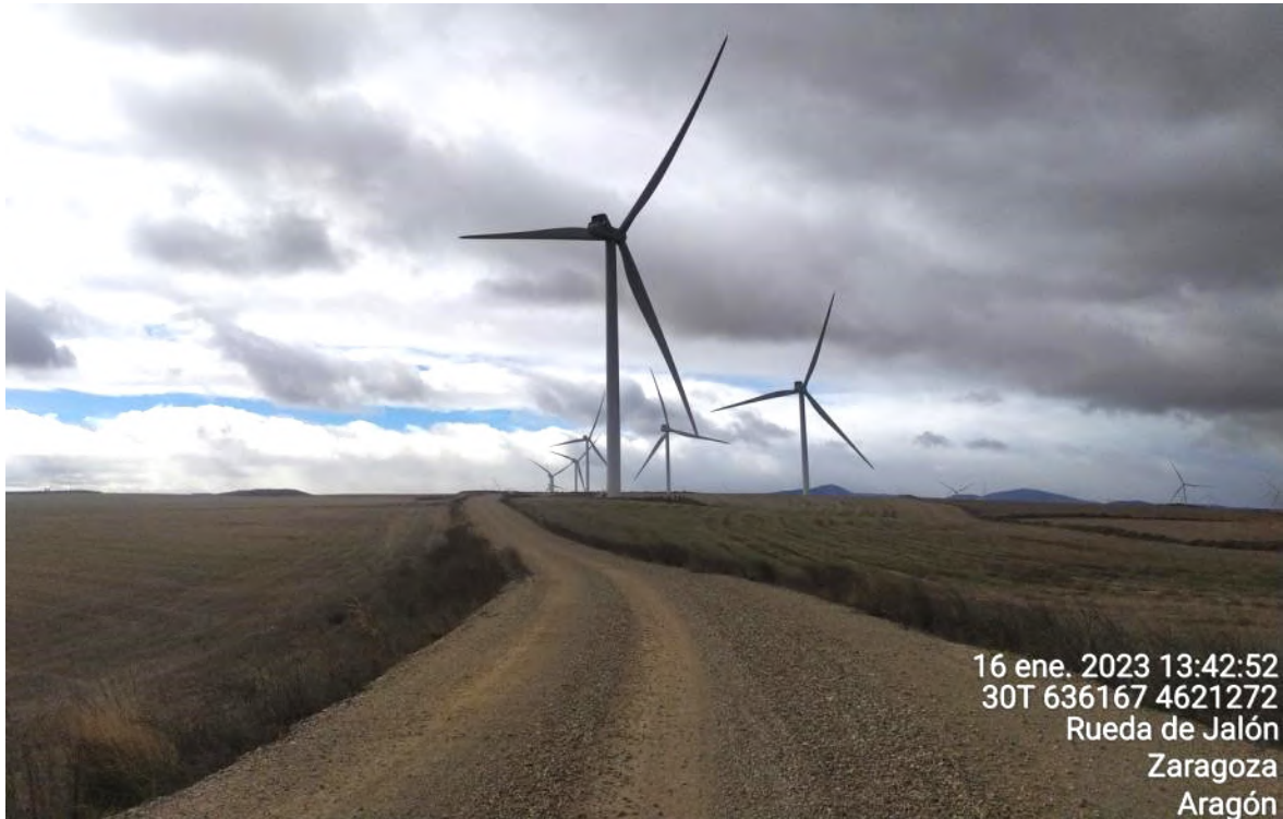
Figura 32: Vial de acceso entre aerogeneradores ELL7 y ELL8.
