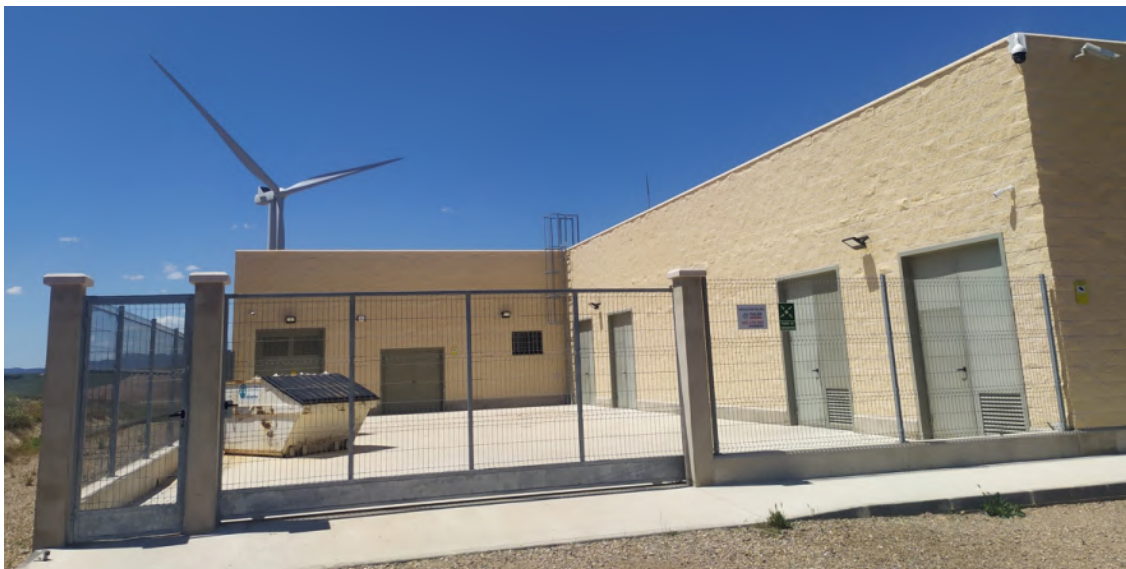
Figura 38: Almacén del PE El Llano, localizado al norte del aerogenerador ELL10.
