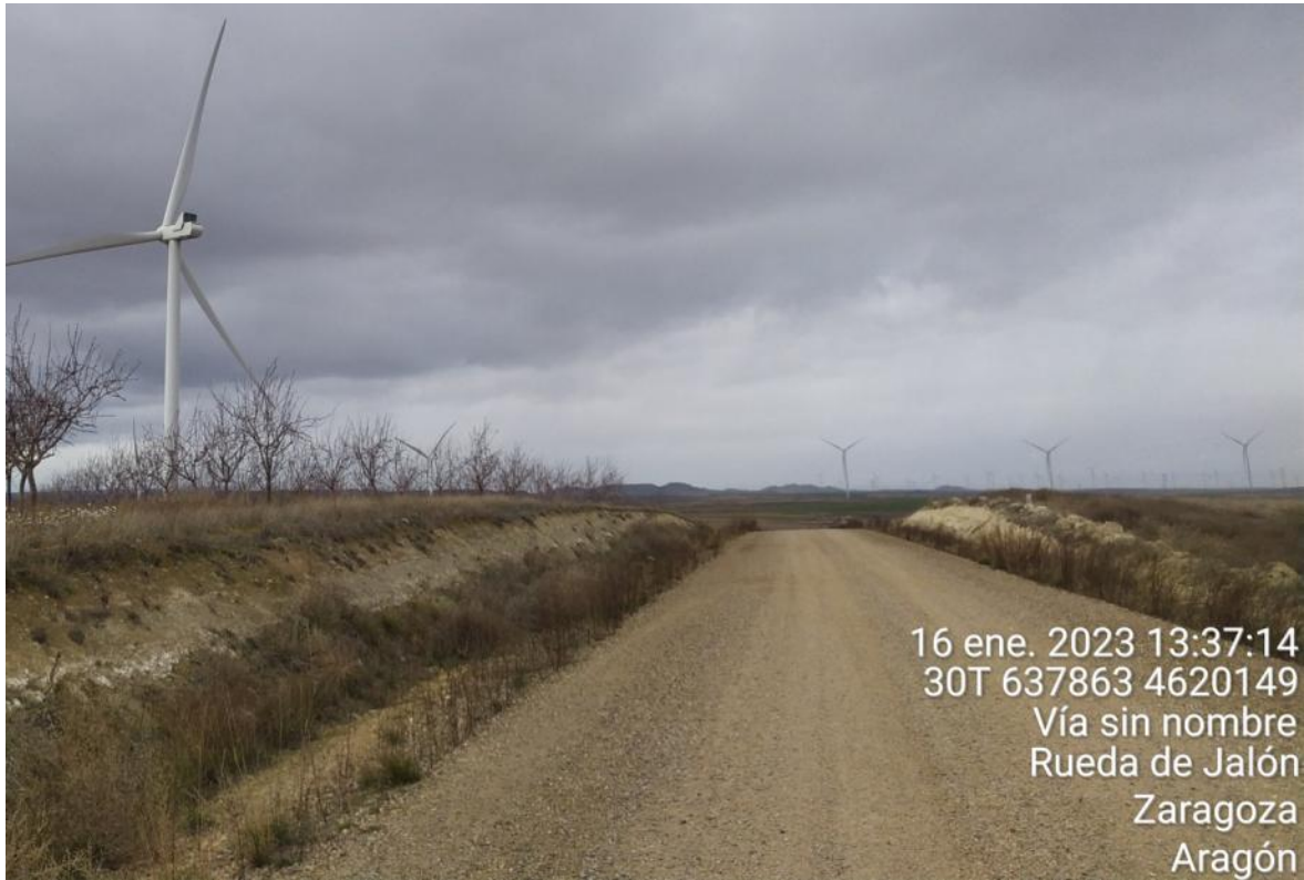
Figura 28: Vial de acceso entre aerogeneradores ELL11 y ELL10.
