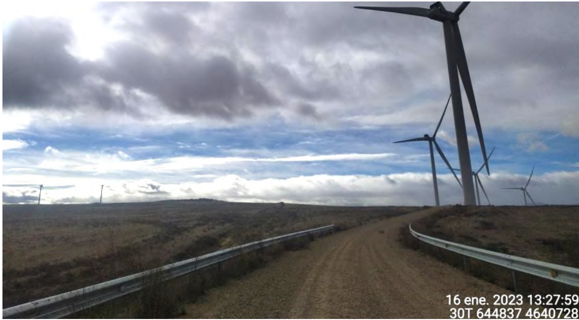
Figura 26: Vial de acceso a aerogeneradores ELL13 y 14.
