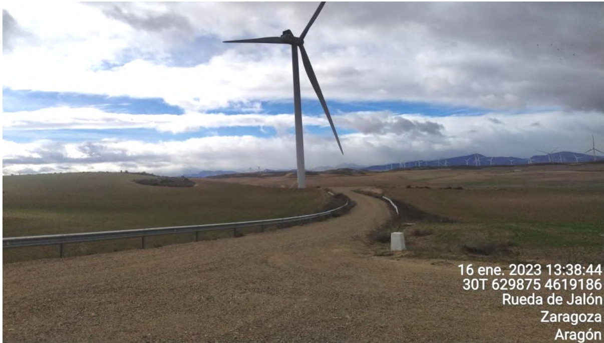
Figura 30: Vial de acceso a aerogenerador ELL-10.
