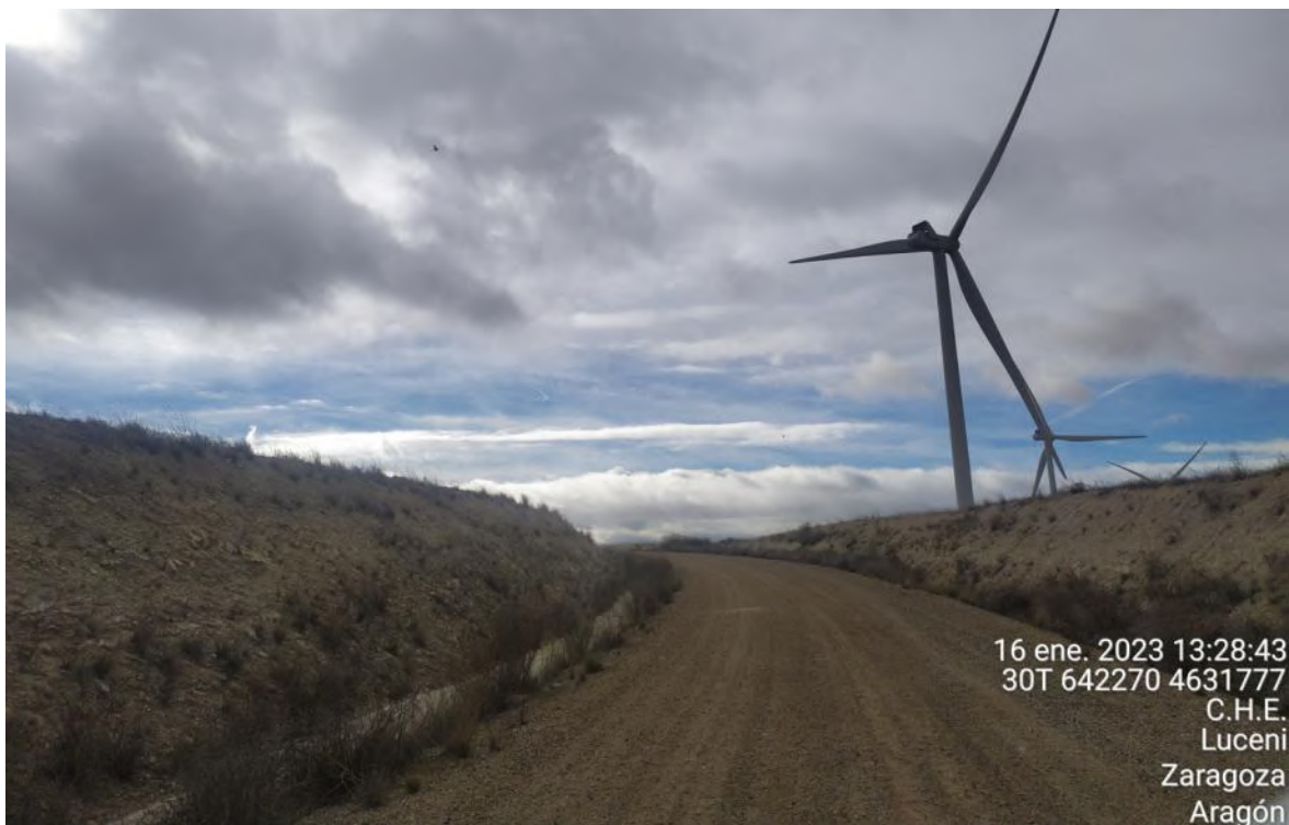
Figura 27: Vial de acceso entre aerogeneradores ELL12y ELL11.
