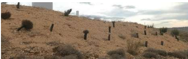
Estado general de los taludes restaurados (T-13)
