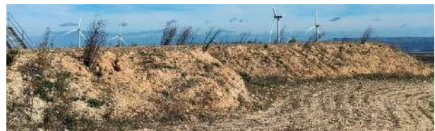
Estado general de los taludes restaurados (T-10)
