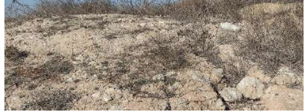
Estado general de los taludes restaurados (AP-20)
