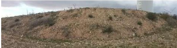
Estado general de los taludes restaurados (T-04)
