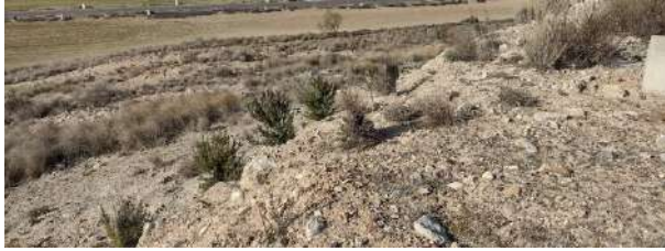
Estado general de los taludes restaurados (AP-19)
