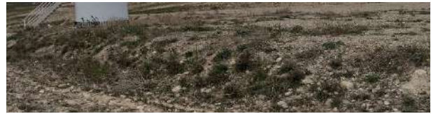
Estado general de los taludes restaurados (T-05)
