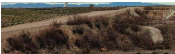
Estado general de los taludes restaurados (T-07)
