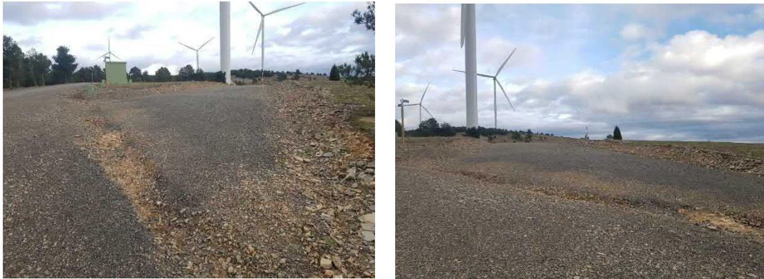
Figura 15. Riera formada en la entrada al vial de acceso al Aerogenerador APE-01 en el parque eólico “Ampliación Puerto Escandón”.
