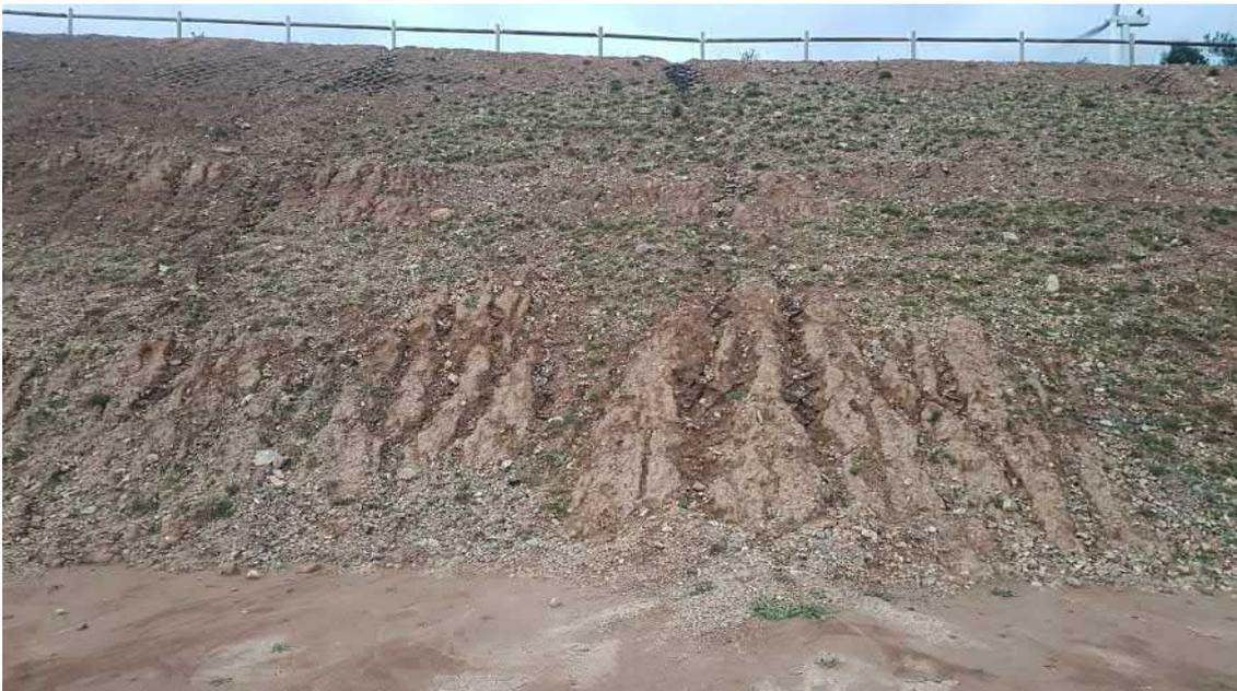
Figura 12. Pequeñas cárcavas en el talud del Aerogenerador APE-03 con la geomalla textil parcialmente expuesta en el parque eólico “Ampliación Puerto Escandón”.
