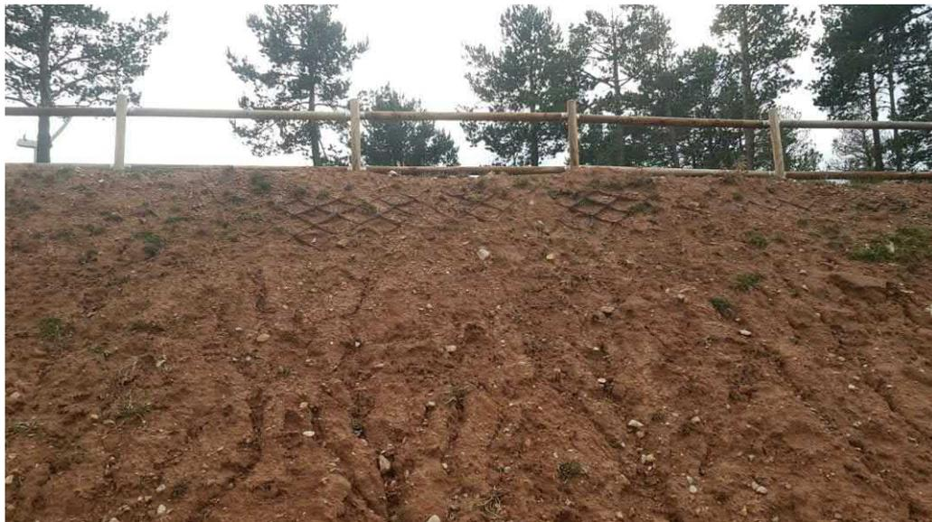
Figura 14. Pequeñas cárcavas en el talud del Aerogenerador APE-05 con parte de la geomalla textil expuesta en el parque eólico “Ampliación Puerto Escandón”.
