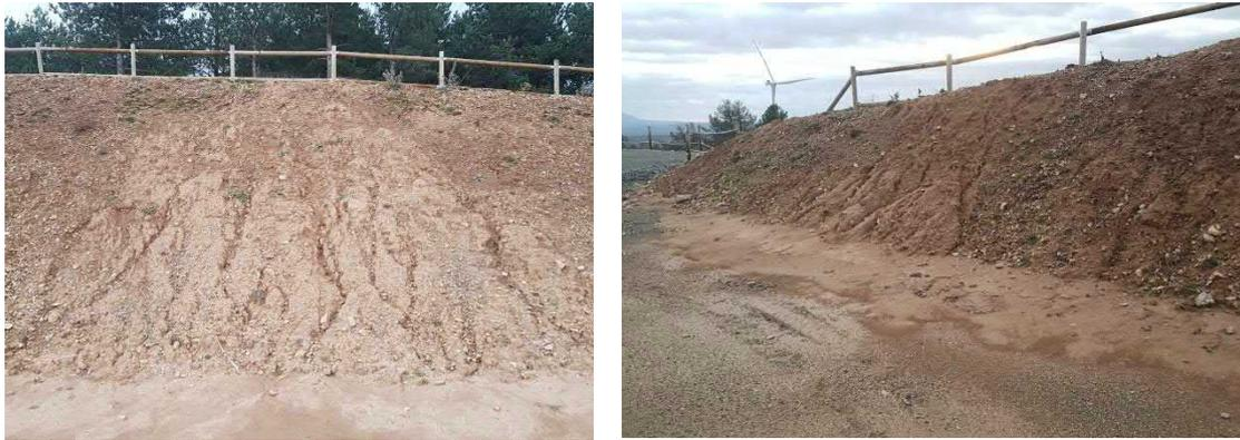
Figura 13. Pequeñas cárcavas en el talud con deposición de colada sedimentaria sobre la plataforma del Aerogenerador APE-04 en el parque eólico “Ampliación Puerto Escandón”.
