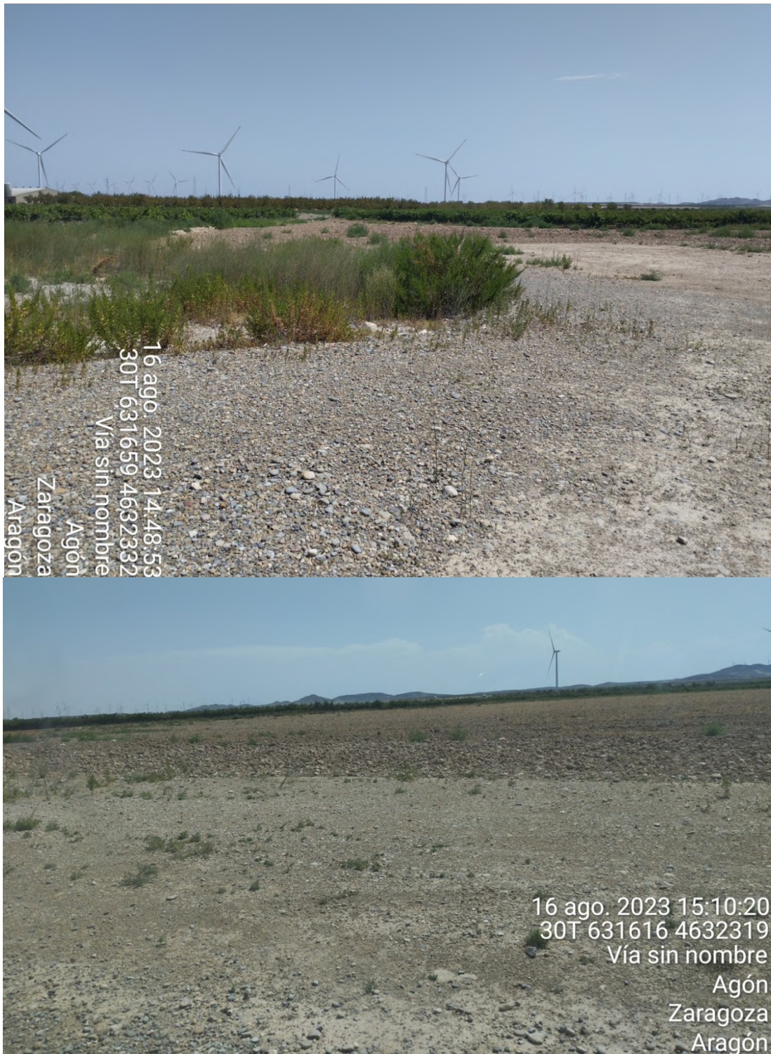
Figura 28: Estado de la plataforma de AG-02. Puede obser
