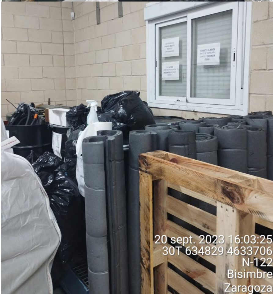
Figura 31: Interior del almacén de residuos de la SET “Valcardera”, con los diferentes residuos peligrosos clasificados con su código LER correspondiente, aislados de la intemperie y sobre una tarima aislante para evitar posibles filtraciones al suelo.
