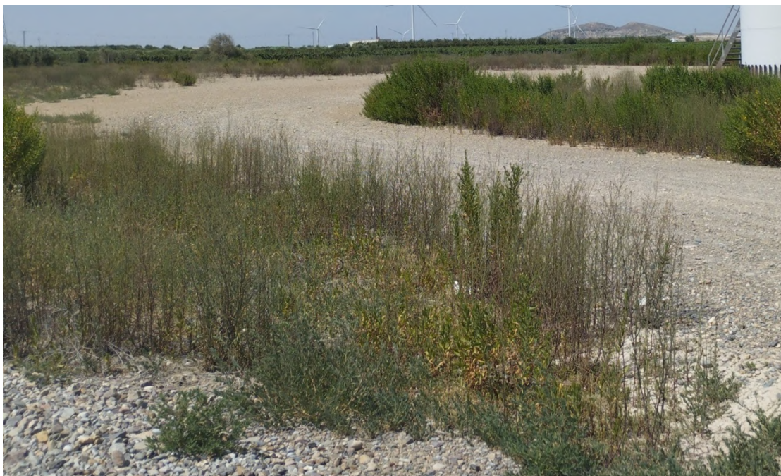
Figura 29: Detalle de los taludes de viales de AG-03 donde se puede observar vegetación herbácea y arbustiva creciendo en las áreas restauradas.
