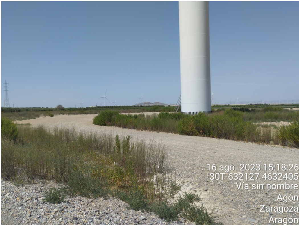
Figura 24: Vial de acceso a plataforma de AG-03.
