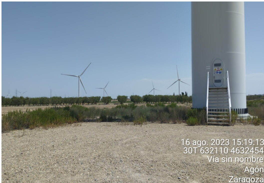
Figura 23: Área restaurada entorno a plataforma de AG-03, puede observarse vegetación natural desarrollándose en la superficie restaurada, así como en parte de la plataforma. Se ha recomendado el desbroce de ésta vegetación natural.
