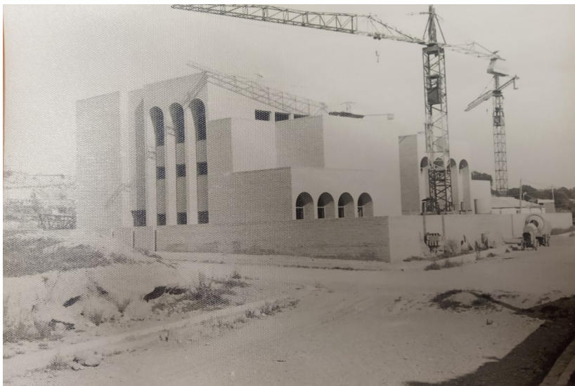
Obras de construcción del Hogar
