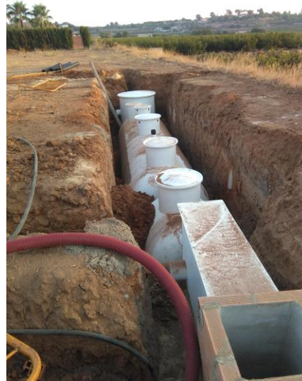
VISTA GENERAL ANTES DE ENTERRAR
