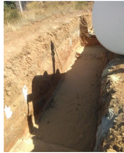
FOSO PARA ENTERRAMIENTO
