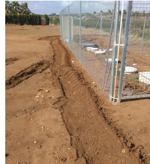
VISTA GENERAL DESPUES DE ENTERRAR
