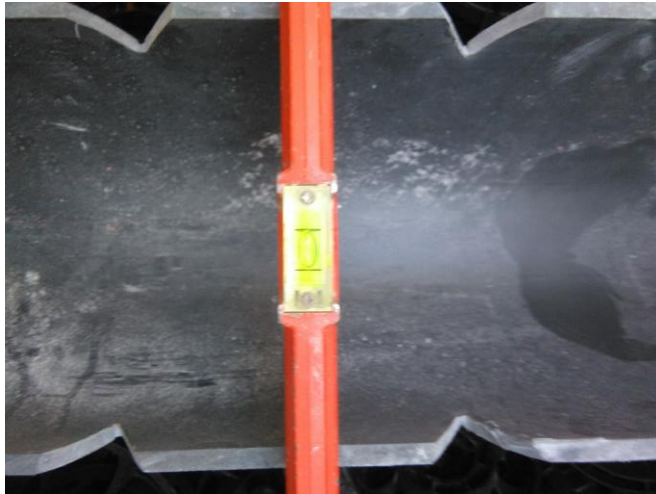
NIVELACIÓN REPARTO A LECHO BIOLÓGICO
