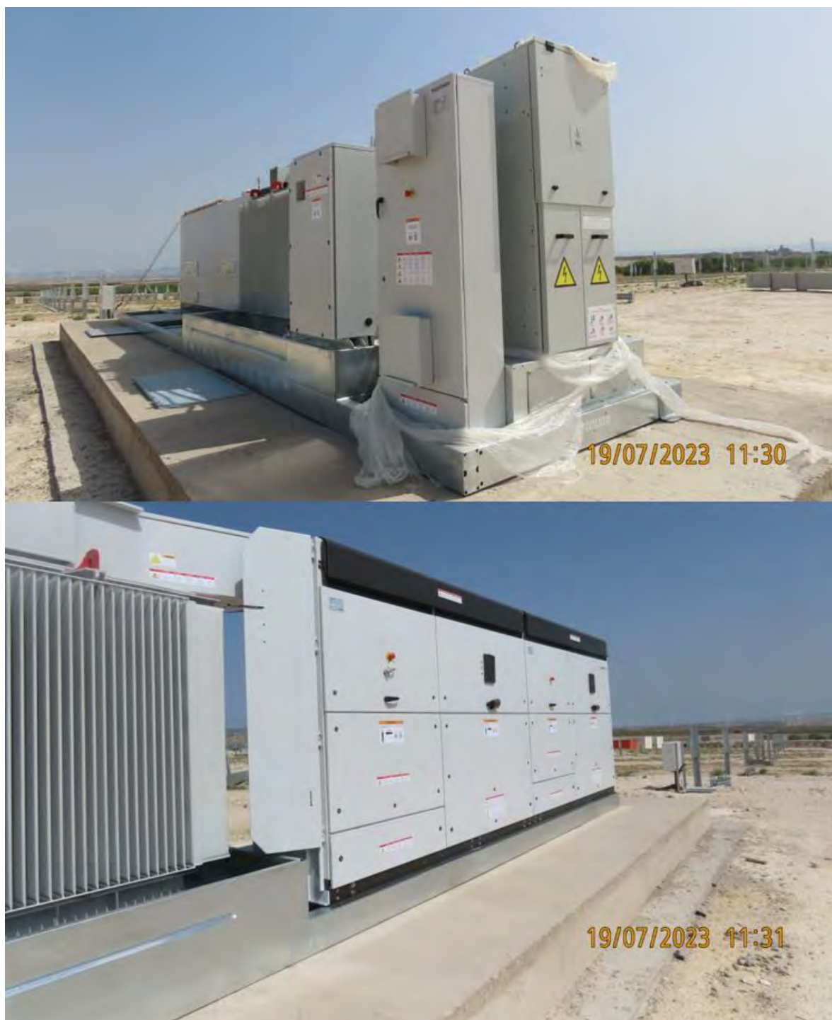
Ilustración 4. Instalación de las Power Station.
