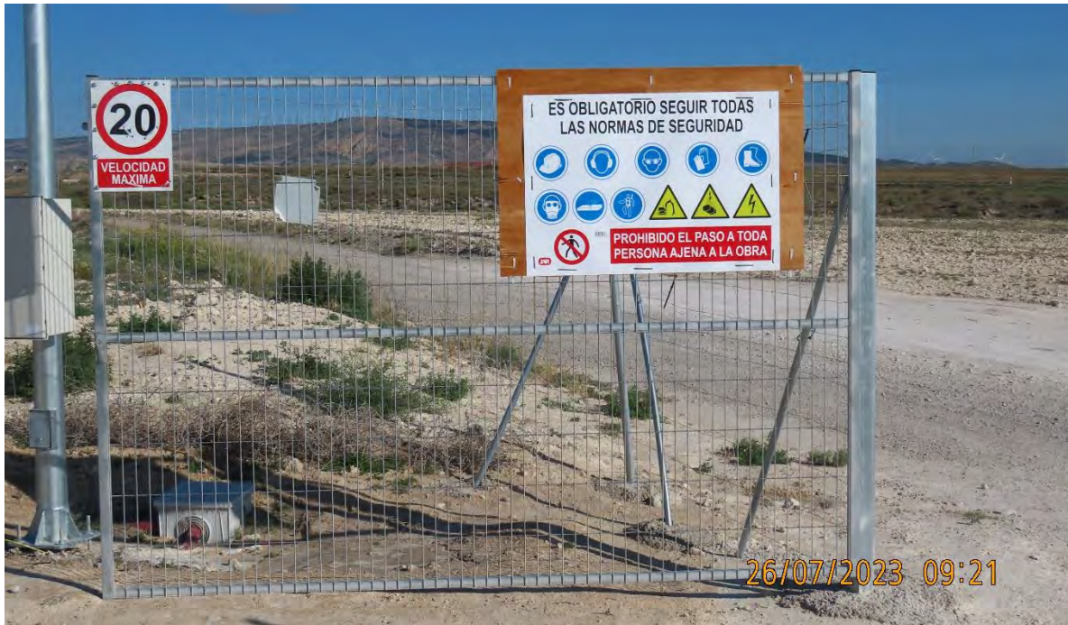
Ilustración 6. Señalización de la obra.
