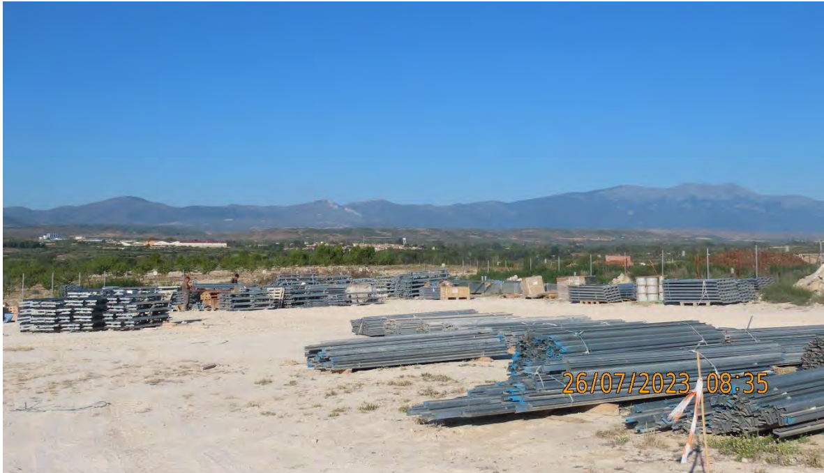
Ilustración 5. Zona de acopio de materiales de obra.
