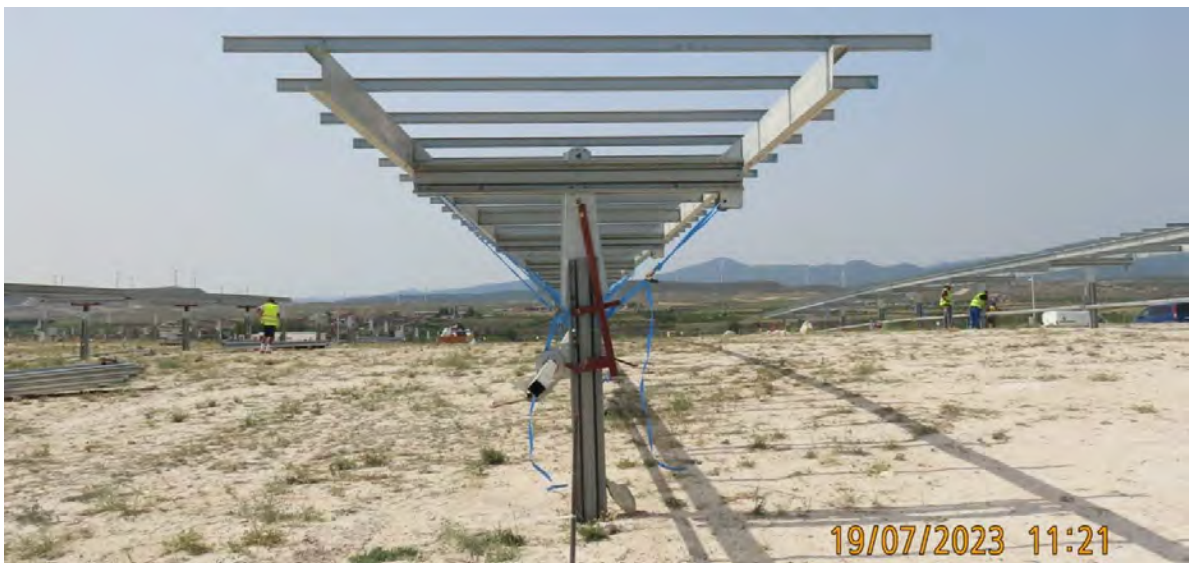
Ilustración 2. Instalación de estructuras de los seguidores.
