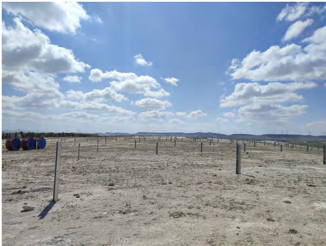
Fotografía 7. PFV con las hincas colocadas.
