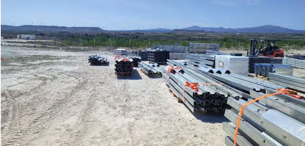
Fotografía 1. Zona de acopio de las hincas.
