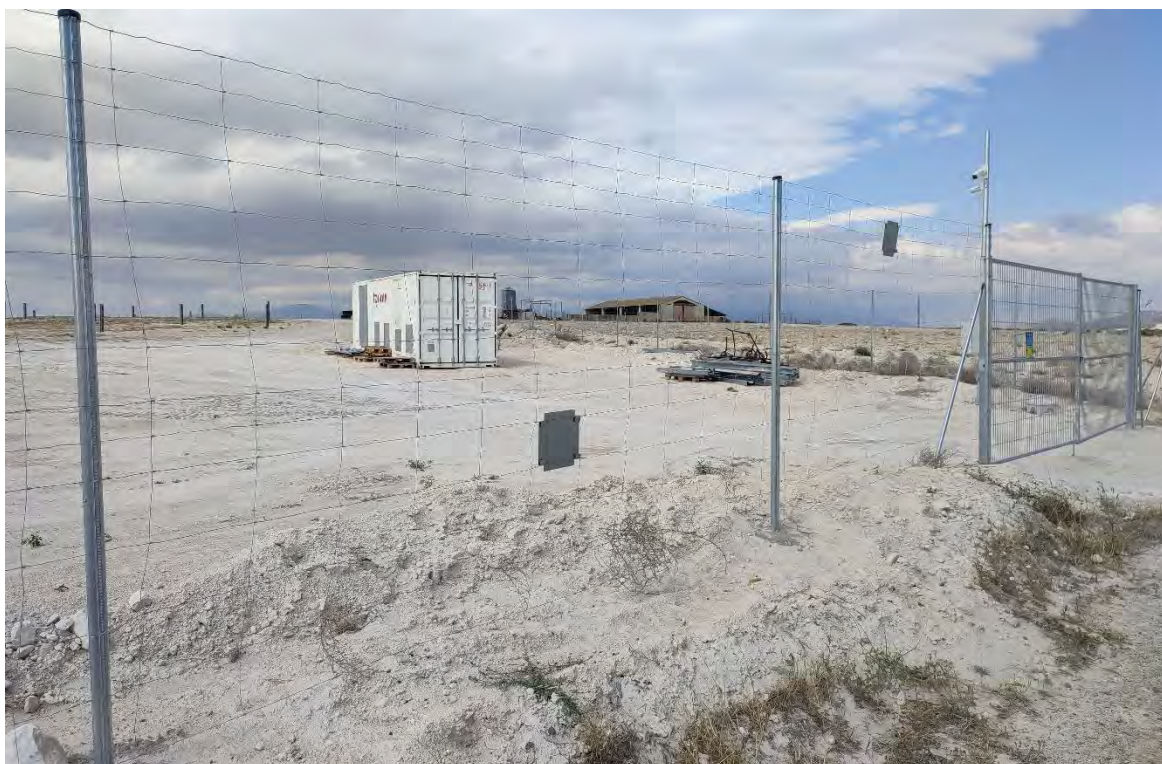
Fotografía 4. Placas del vallado para avifauna.
