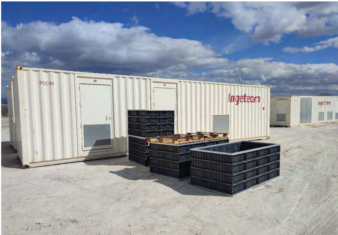
Fotografía 12. Zona de casetas de obra y contenedores para depósito de basura.
