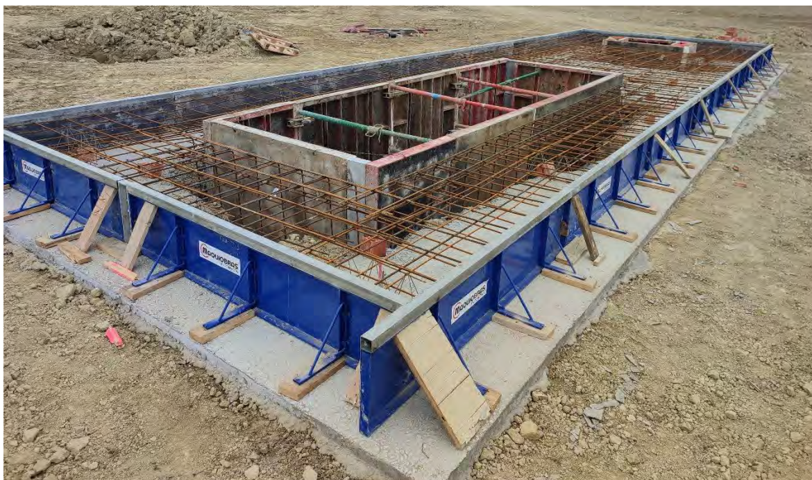
Fotografía 3. Colocación del molde metálico del Centro de transformación.
