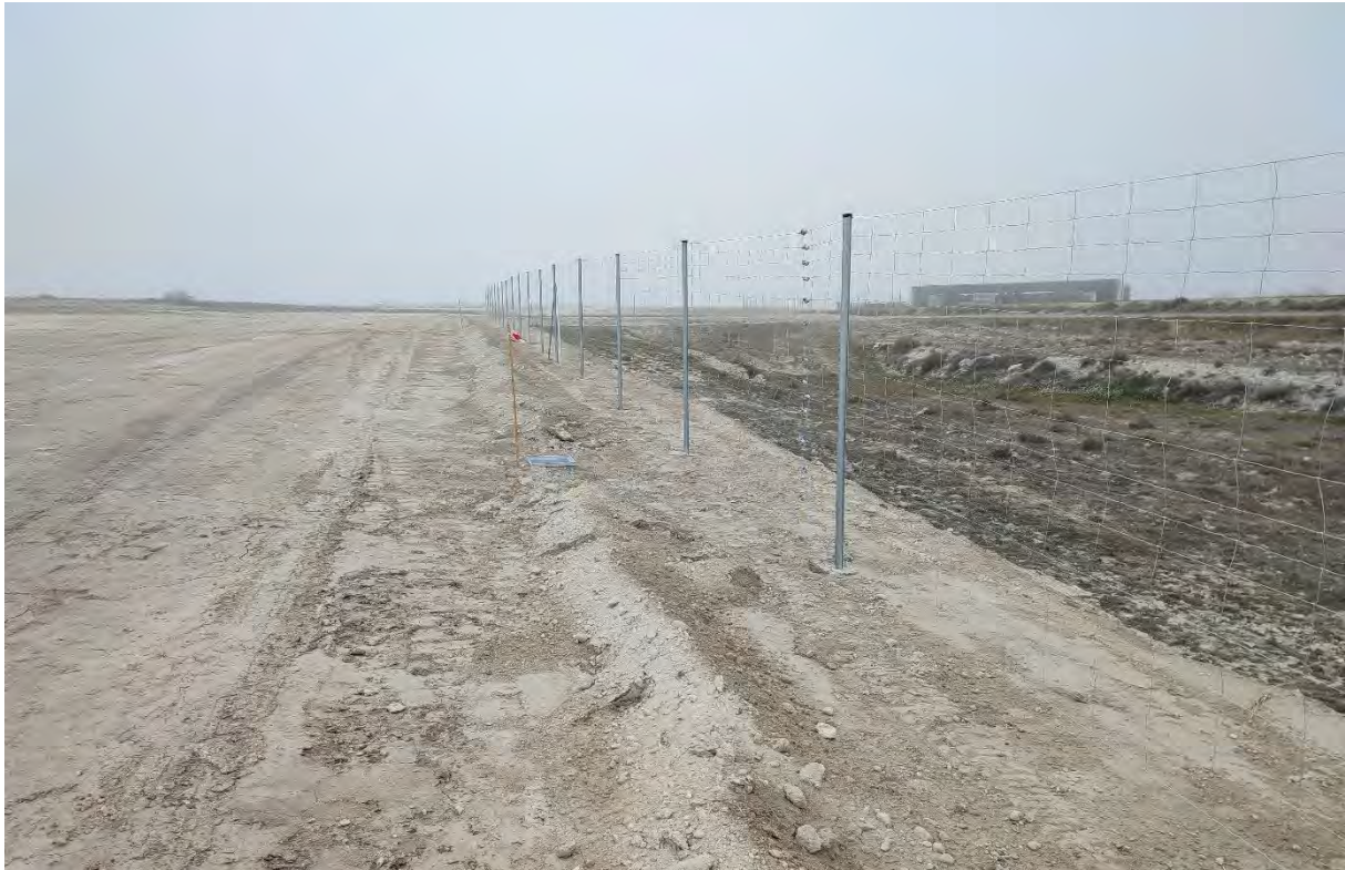
Fotografía 9. Vallado cinegético perimetral
