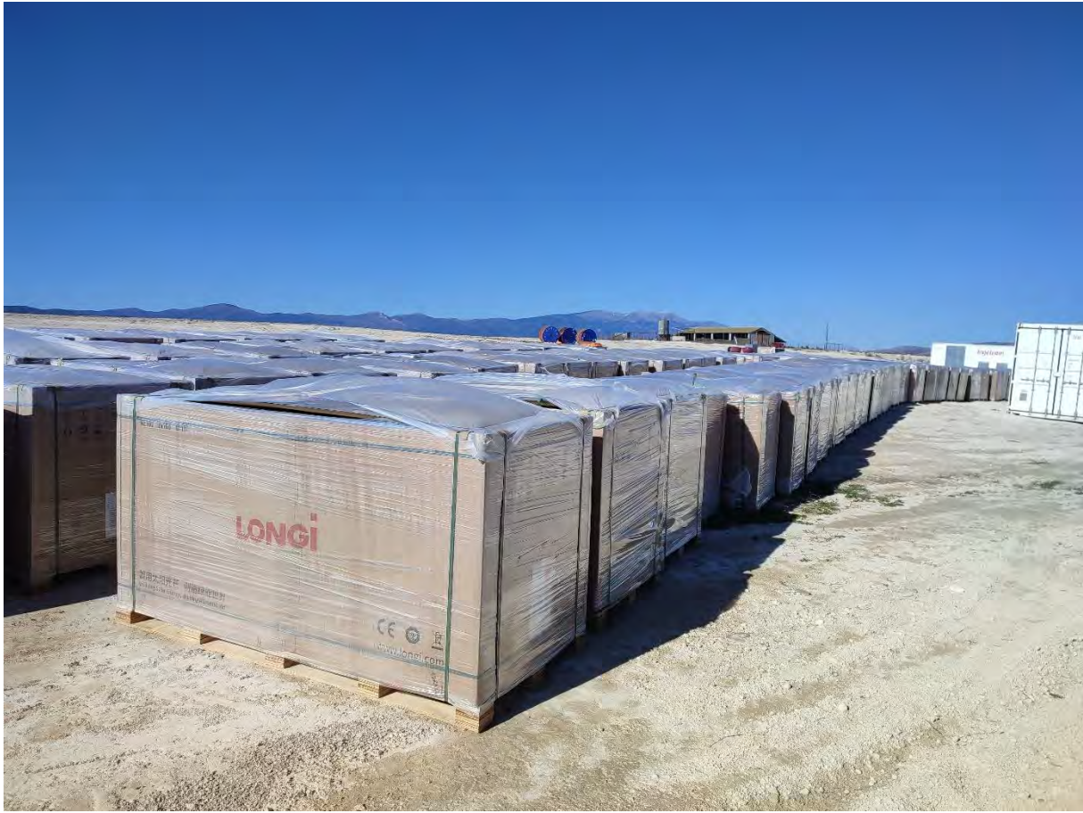
Fotografía 15. Acopio de módulos solares.
