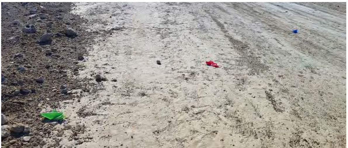
Fotografía 2. Señalización para la instalación de los seguidores.
