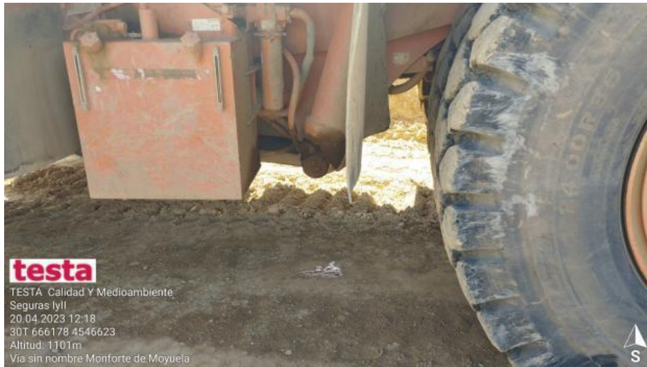
Fuga en camión/volquete, se solicita a la contrata que se coloque un plástico para evitar contaminar el suelo
