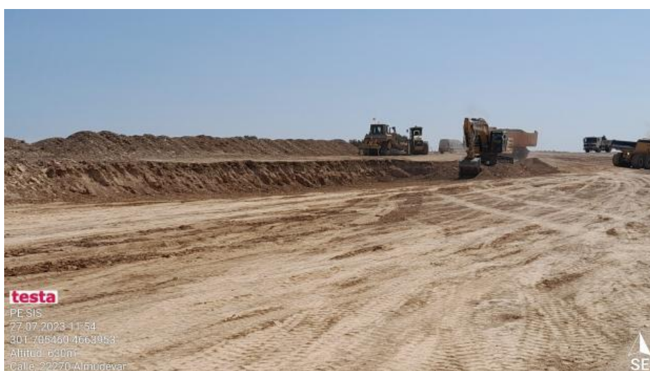
Trabajos en SIS-06.
