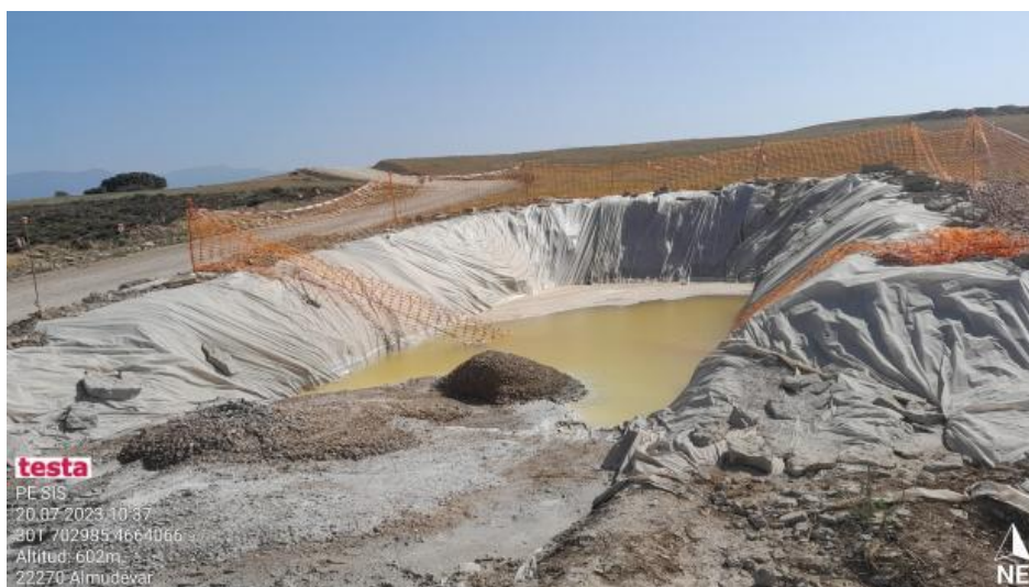
Pozo de Lavado tras hormigonado en SIS-02
