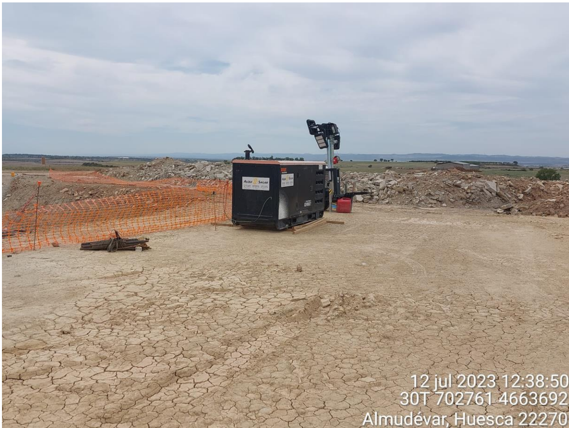
Imagen 2. Grupo electrógeno sin protección del suelo.
