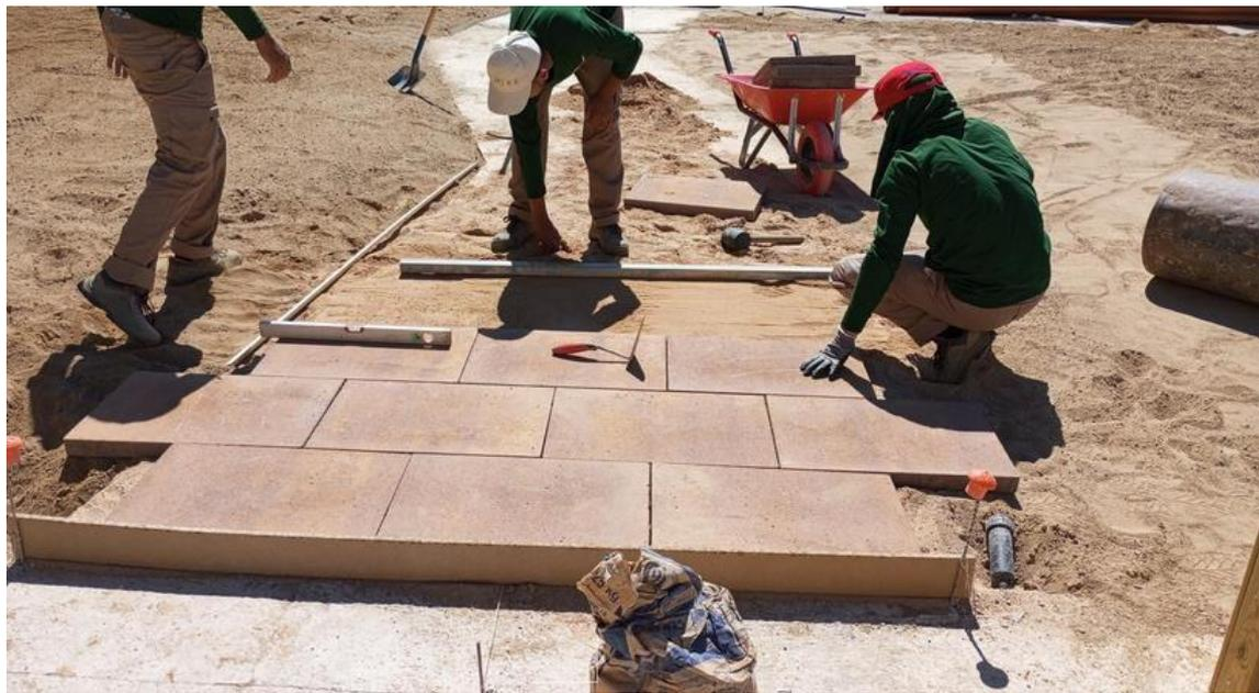
**CONSTRUCCIÓN DE PAVIMENTO CONTINUO CON LOSA DE HORMIGÓN DE 60\*40\*5cm(250m<sup>2</sup>)**
