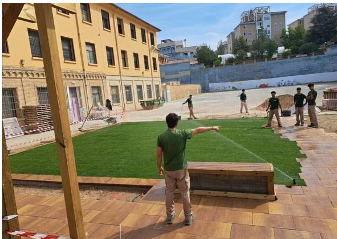
**COMPROBACIÓN DE QUE EL TEPES ESTÁ BIEN INSTALADO Y EL RIEGO POR ASPERSIÓN FUNCIONANDO CORRECTAMENTE**
