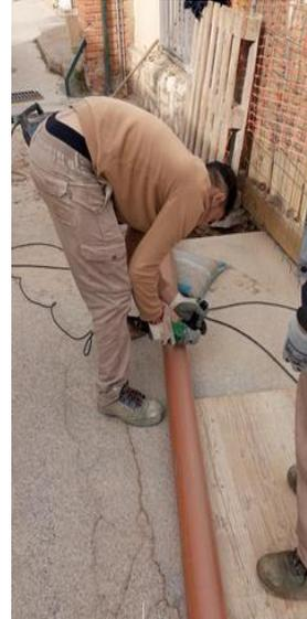
**CONSTRUCCIÓN DE DRENAJE CENTRAL DE TUBERÍA DE PVC DE 110 CON ARQUETAS DE CAPTACIÓN DE AGUAS SUPERFICIALES (CORTE DE ASFALTO, APERTURA DE ZANJA Y COLOCACIÓN DE TUBERÍA).**
