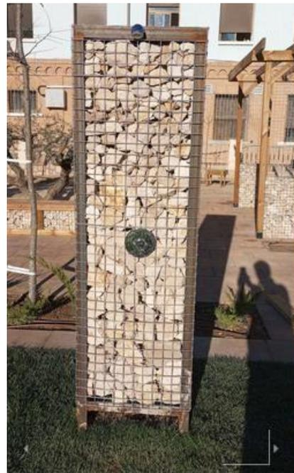
**RELLENO DE PIEDRA CALIZA EN LA CONSTRUCCIÓN DE GAVIONES, BANCOS Y MURETES EN PÉRGOLA Y DUCHA.**
