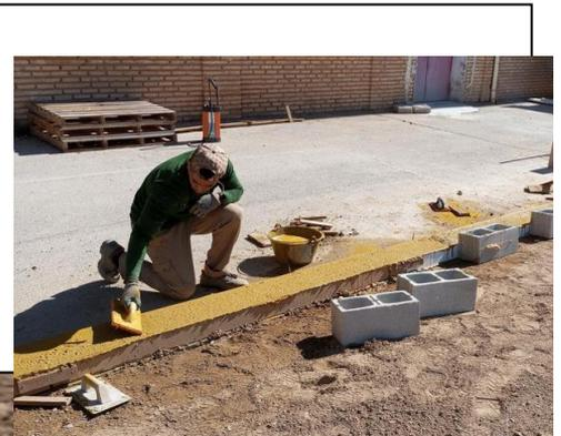
**CONSTRUCCIÓN DE BORDILLOS JARDINEROS IN SITU DE HORMIGÓN –HIERRO Y MADERA, APLICANDO TINTES DE IMPRESIÓN EN EL HORMIGÓN Y METÁLICOS CON SOLDADURA**
