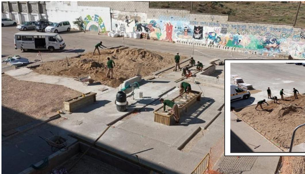
**CONSTRUCCION DE LA ESTRUCTURA DE LOS BANCOS Y BANCADAS (CON BLOQUE DE HORMIGÓN ASI COMO EL MOVIMIENTO DE TIERRA VEGETAL PARA LA INSTALACION DE CESPED)**
