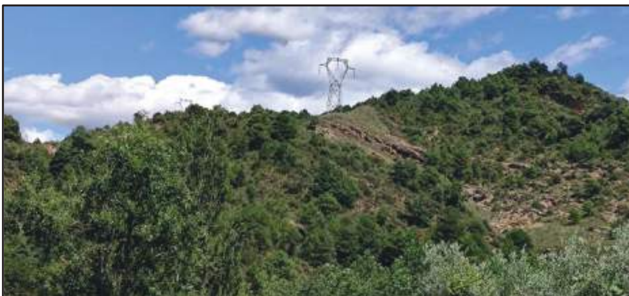
Imagen 13. La línea eléctrica de alta tensión va paralela a una línea ya existente al transitar al sur del núcleo de Palo. Se ha evitado transitar próximo a este núcleo. La vegetación del entorno está dominada por el pinar de salgareño, con presencia también del pino silvestre, del roble marcescente y de la encina.
