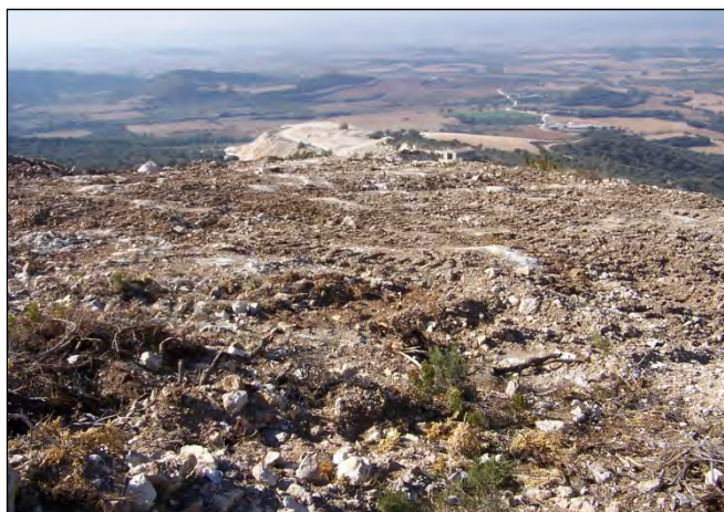
Aspecto de la superficie superior tras los trabajos de desmonte.
