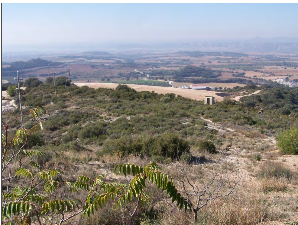
Vista general de la escombrera oeste restaurada.
