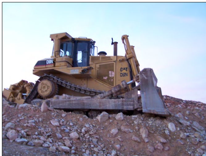
Equipo bulldozer realizando el desmonte.
