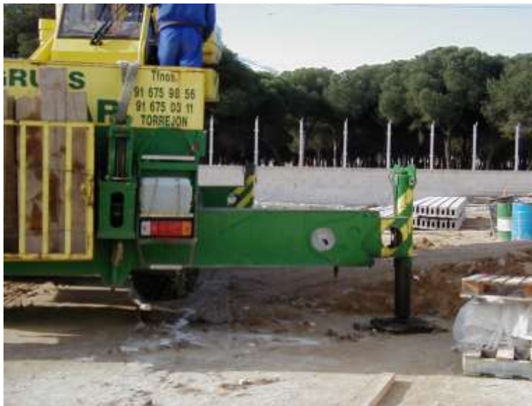
Estabilizadores de la grúa extendidos en su totalidad
