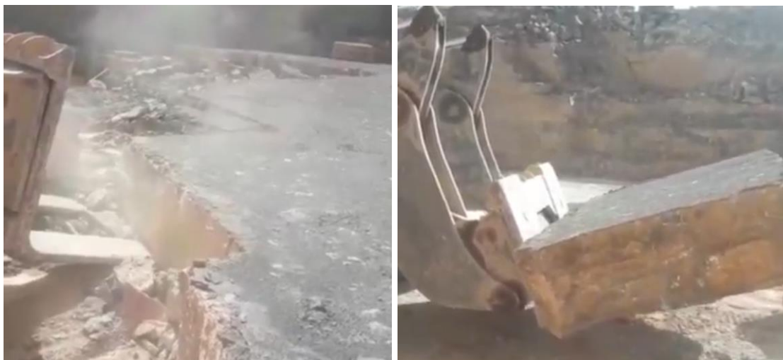
Figura 57.Extracción de bloque mediante pala.
