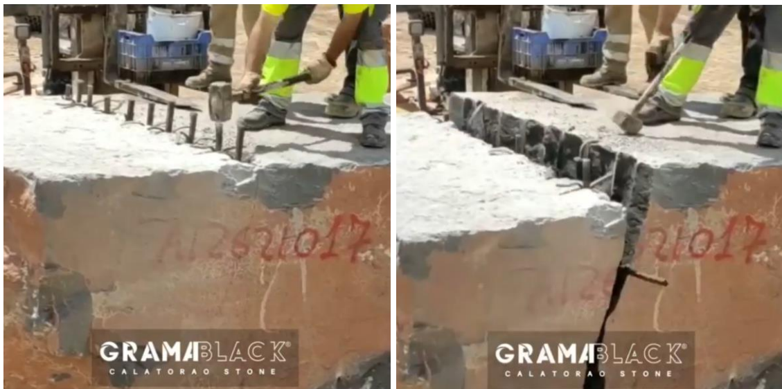
Figura 56. División del bloque mediante cuñas manuales
