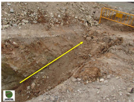
Figura 27. Ejemplo de talud en el extremo de una zanja de obra para la salida de fauna (izquierda), y de una rampa de escape de fauna en una plataforma de edificación bajo nivel (derecha).
