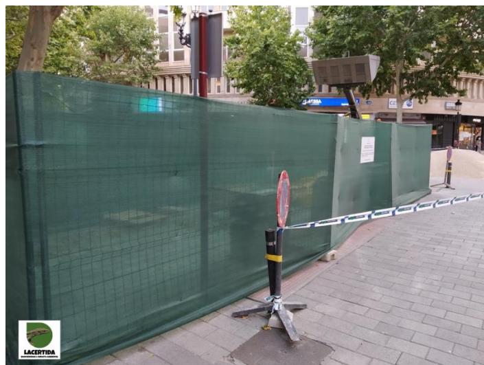
Figura 28. Ejemplo de vallado de obra móvil y opaco para minimizar la interacción visual entre la fauna y la actividad constructiva.
