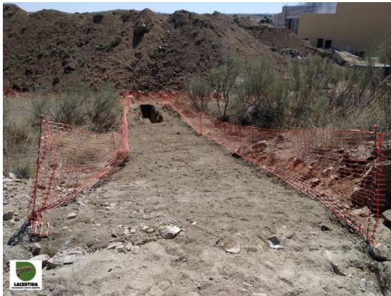
Figura 26. Ejemplo de balizado con malla naranja de zonas con vegetación a preservar (izquierda) y balizado con pacas de paja de elementos de especial interés (derecha).
