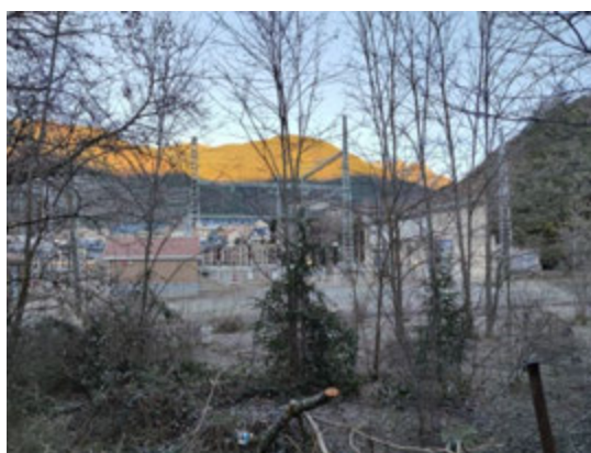
Figura 72: SET final donde termina la línea de evacuación en Biescas.
