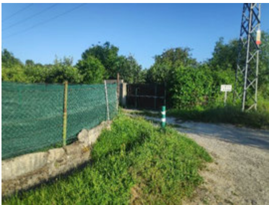
Figura 49: Zona de fincas al este del Gállego en el trazado de la línea de evacuación
