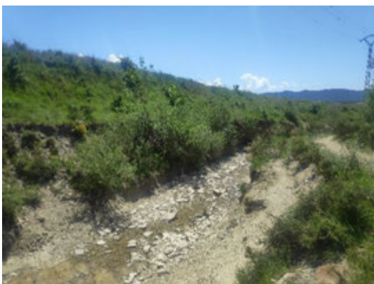
Figura 41: Zona del barranco de Acuastias en el trazado de la línea de evacuación
