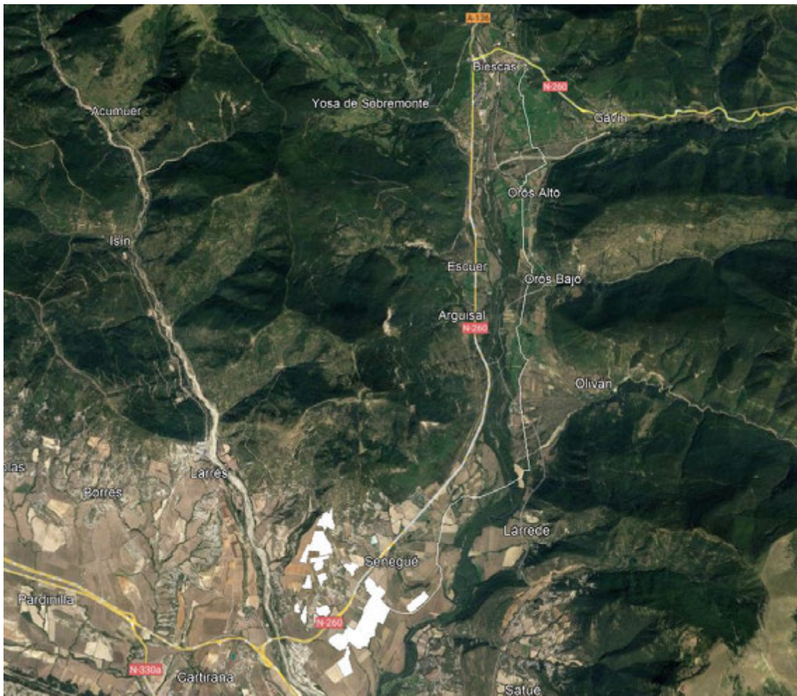
Figura 3: Situación general de los parques fotovoltaicos de Sierra Plana I con la línea de evacuación incluida.
