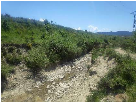
Figura 38: Zona del barranco de Acuastias en el trazado de la línea de evacuación
