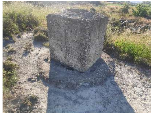
Figura 49: Estructura de hormigón del siglo XX en el trazado de la línea de evacuación
