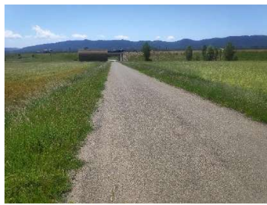
Figura 39: Camino asfaltado en el trazado de la línea de evacuación
