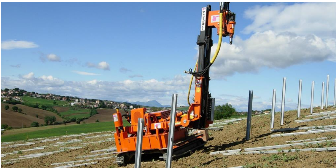
Ilustración 8: Máquina hinca postes. Fuente: Pauselli Group
