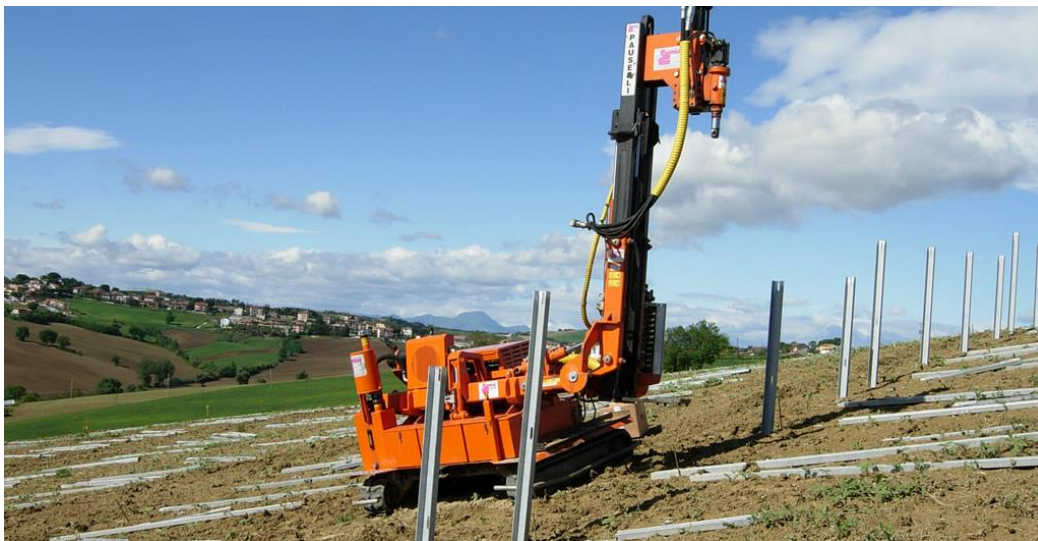
Ilustración 10: Máquina hinca postes. Fuente: Pauselli Group
