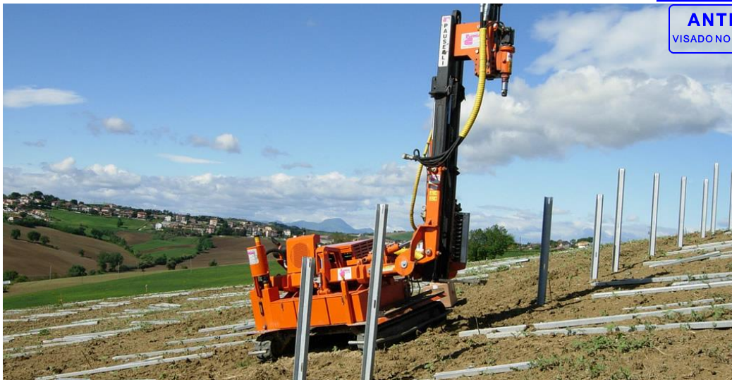
Ilustración 11: Máquina hinca postes. Fuente: Pauselli Group
