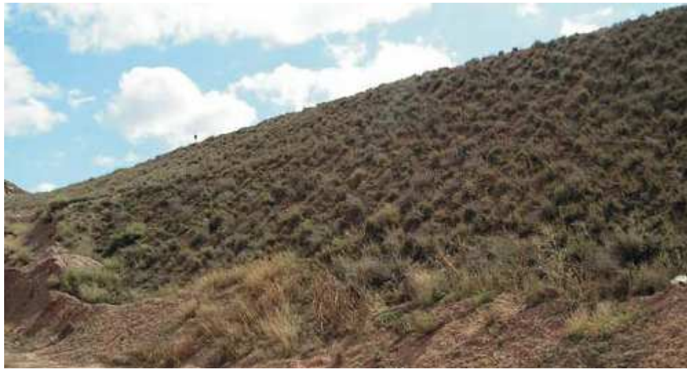
Taludes remodelados y revegetados
