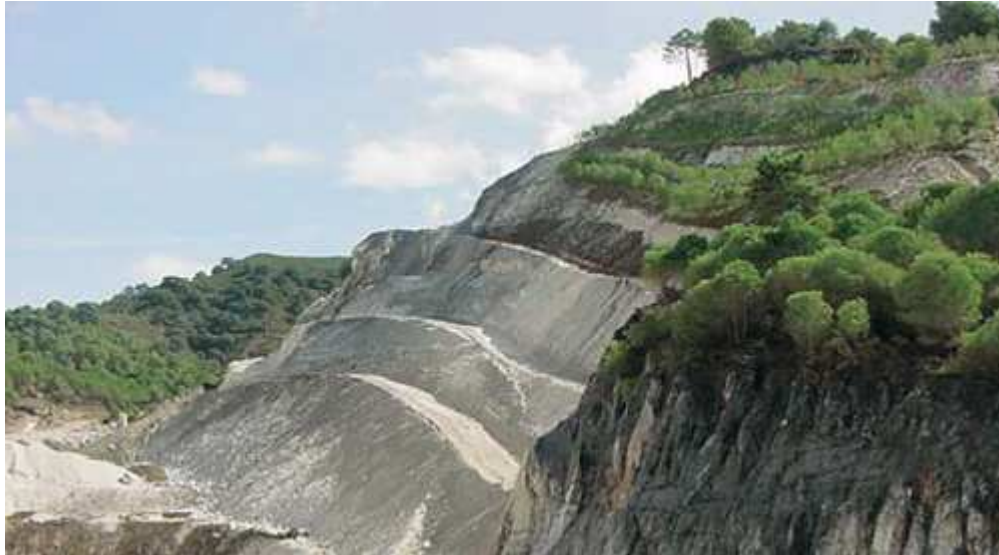
Frente de explotación extractiva con los bancos superiores restaurados y revegetados. Los inferiores se encuentran remodelados, a la espera de la plantación.
