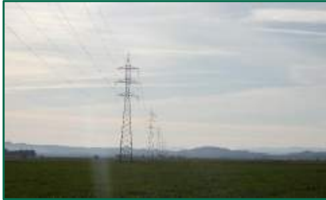
Fotografía 1. Línea eléctrica de Alta Tensión 132kV ALCAÑIZ-HÍJAR al norte de la planta fotovoltaica.
