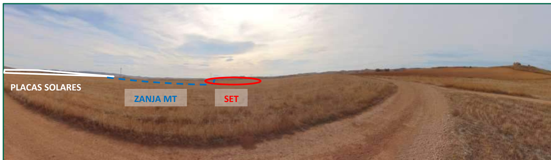
Fotografía 4. Planta fotovoltaica vista desde el sureste, con zanja de cable de media tensión en dirección a la Subestación, y Subestación
