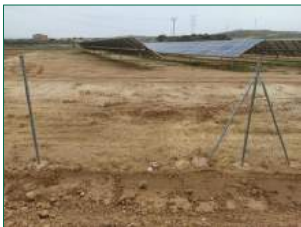
Fotografía 10. Hidrosiembra realizada en el interior del vallado y vista del resultado del crecimiento en su primera etapa. Fuente: restauración para un proyecto propio
