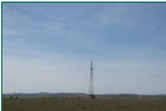
Fotografía 8. Línea eléctrica de Alta Tensión 132kV ALCAÑIZ-HÍJAR al norte de la planta fotovoltaica
