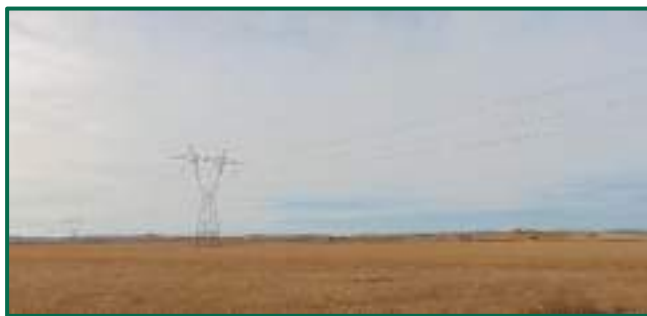
Fotografía 2. Línea eléctrica de Alta Tensión 400kV ARAGÓN- MORELLA al sur de la planta fotovoltaica.
