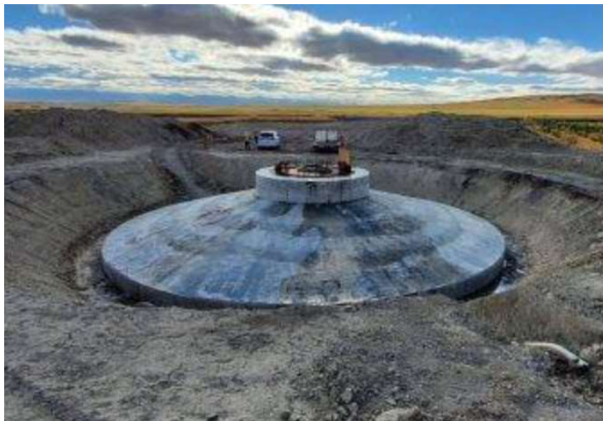
Imagen de cimentación tipo de Aerogenerador
