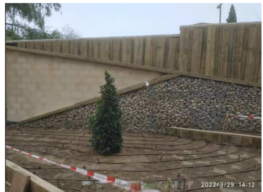
PARAMENTOS ACABADOS PIEDRA, ENFOSCADO Y MADERA.
