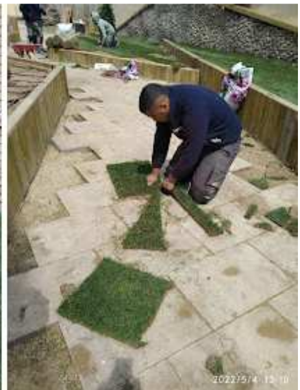
INSTALACION DE TEPES, AJUSTE E INSTALACION DE RECORTES.
