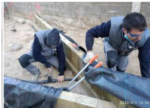
MONTAJE DE LA TUBERIA DE RIEGO GENERAL CON TUBERIA POLIETILENO Y SALIDAS EN CADA PARTERRE.
