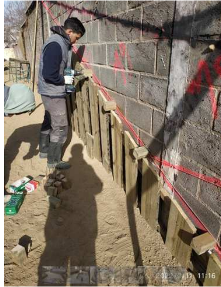
INSTALACION DE REVESTIMIENTO DE MADERA EN PARED DE BLOQUE DE CEMENTO.
