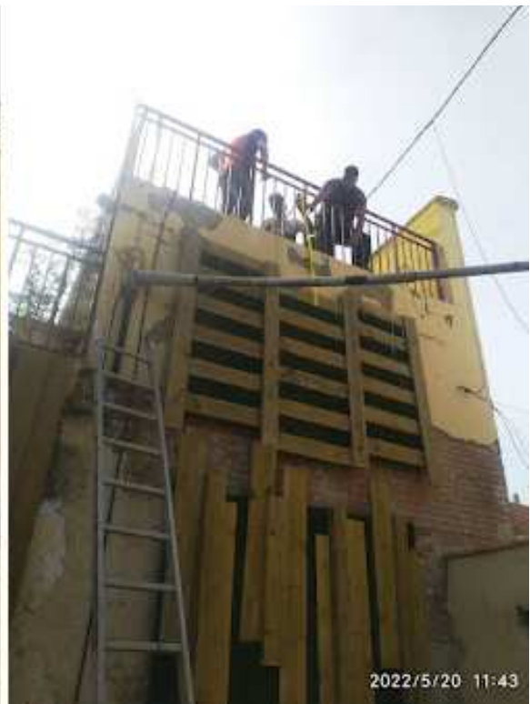
INSTALACION DE ESTRUCTURA DE JARDIN VERTICAL PARA COLOCAR JARDINERAS DE GERANIOS.
