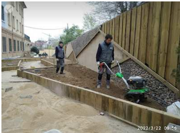
ACONDICIONAMIENTO DEL TERRENO PARA REALIZAR LA PLANTACION DEL TEPES Y ELEMENTOS VEGETALES COMO ARBOLES Y ARBUSTOS
