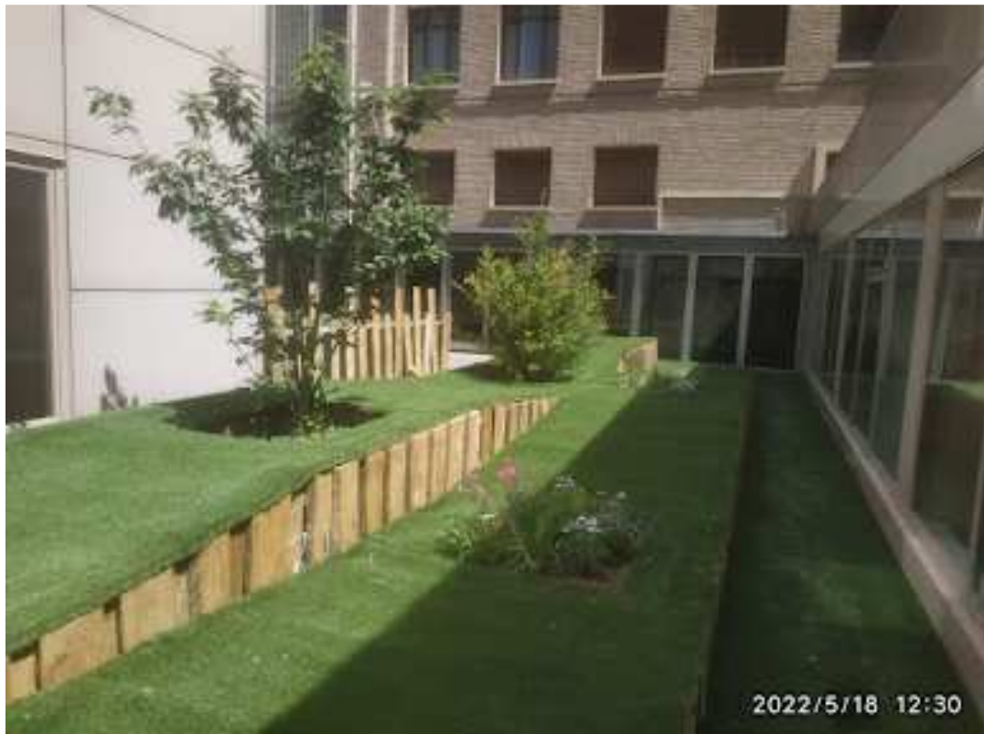
COLOCACION DE CESPED ARTIFICIAL EN LA ESTRUCTURA Y PLANTAS ( ARBOLES , PLANTA VIVAZ Y TEMPORADA.)
