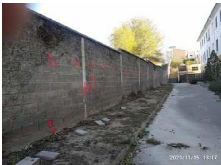
REPLANTEO DE OBRA TANTO EN JARDINES VERTICALES COMO ZONIFICACION DEL JARDIN.
