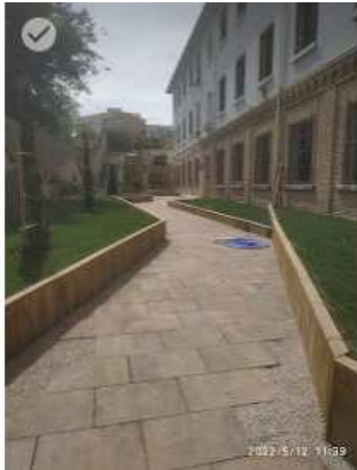
RELLENO DE GRAVAS MACHACADAS DE CALIZA EN EXTREMOS DEL VIAL.
