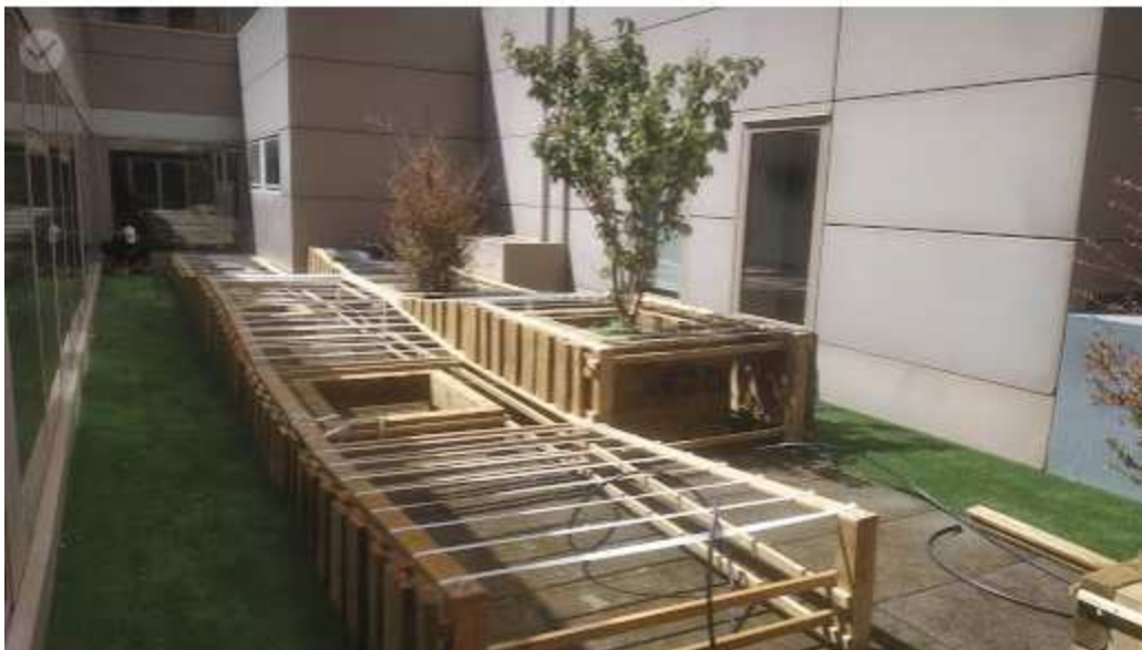
REPLANTEO E INSTALACION DE JARDINERAS INSERTADAS DENTRO DE LA ESTRUCTURA (COLINA)
