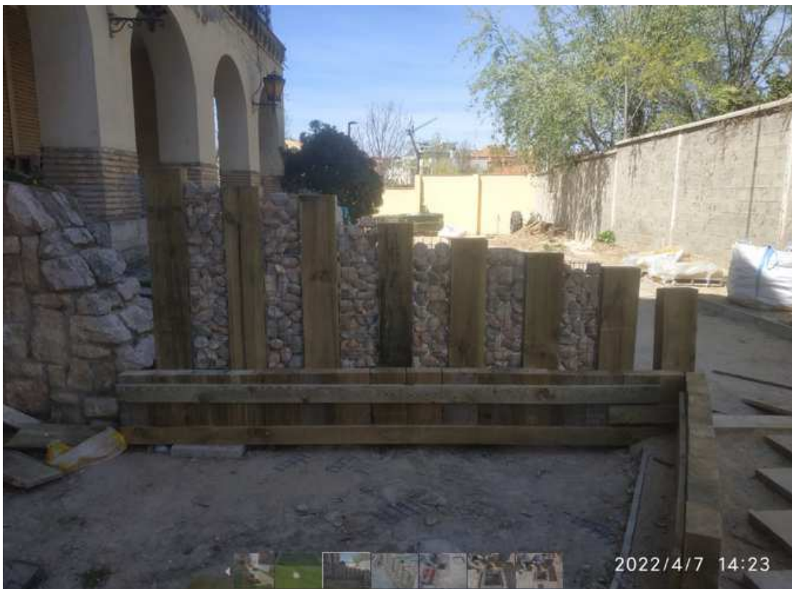
MURO COMBINADO DE PIEDRA Y MADERA FINAL DEL JARDIN
