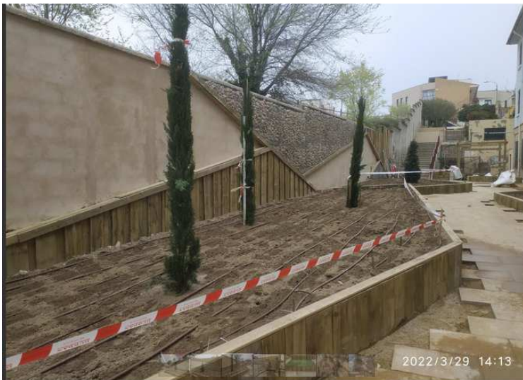
PARAMENTOS ACABADOS PIEDRA, ENFOSCADO Y MADERA.
