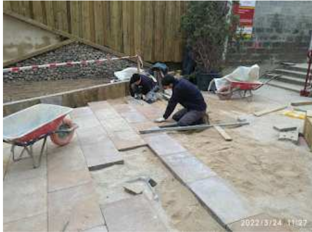
INSTALACION DE LOSA DE HORMIGON DE 60X40X0,05 PREVIO NIVELADO DEL TERRENO CON ARENA Y POSTERIOR RESETEADO
