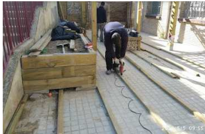
COLOCACION DE RASTRELES PARA INSTALACION DE TARIMA.
