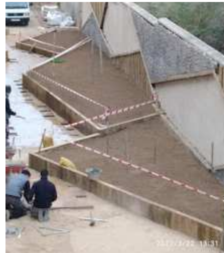
ACONDICIONAMIENTO DEL TERRENO PARA REALIZAR LA PLANTACION DEL TEPES Y ELEMENTOS VEGETALES COMO ARBOLES Y ARBUSTOS
