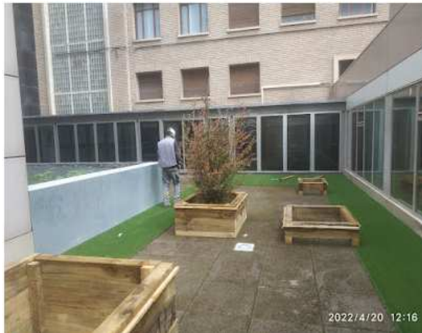
INSTALACION DE CESPED ARTIFICIAL EN EL SUELO, FUERA DE LA ESTRUCTURA DE COLINA.
