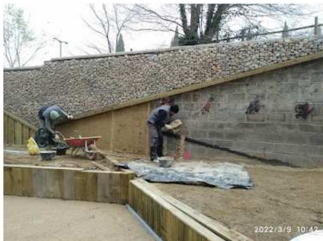
ENFOSCADO DEL JARDIN VERTICAL CON CEMENTO BLANCO Y ARENA
