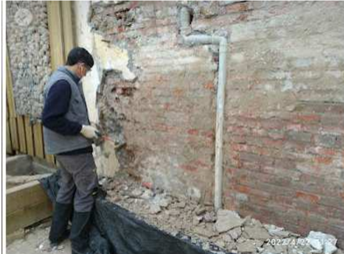
SANEAMIENTO DE PARED DESCUBRIENDO EL LADRILLO QUE HABIA DETRÁS DEL ENFOSCADO VIEJO.
