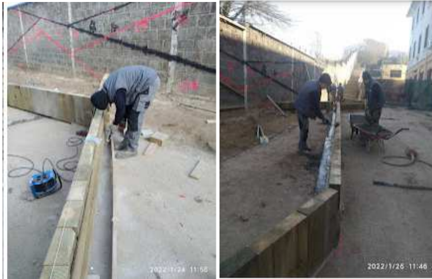
ENCOFRADO Y CIMENTACION DE LAS PAREDES DE LAS JARDINERAS PARA FIJACION CON EL SUELO ( ENCOFRADO - VERTIDO - VIBRADOS DEL HORMIGON Y DESENCOFRADO)
