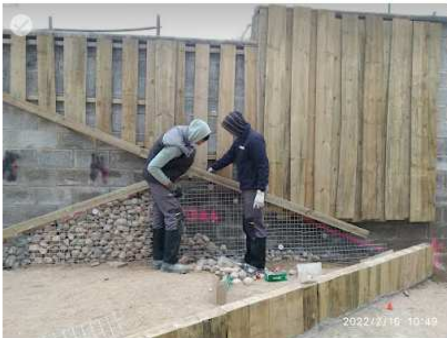
COSTRUCCION JARDIN VERTICAL TRES ZONAS : MADERA – PIEDRAS ( GAVION) – ENFOSCADO.
