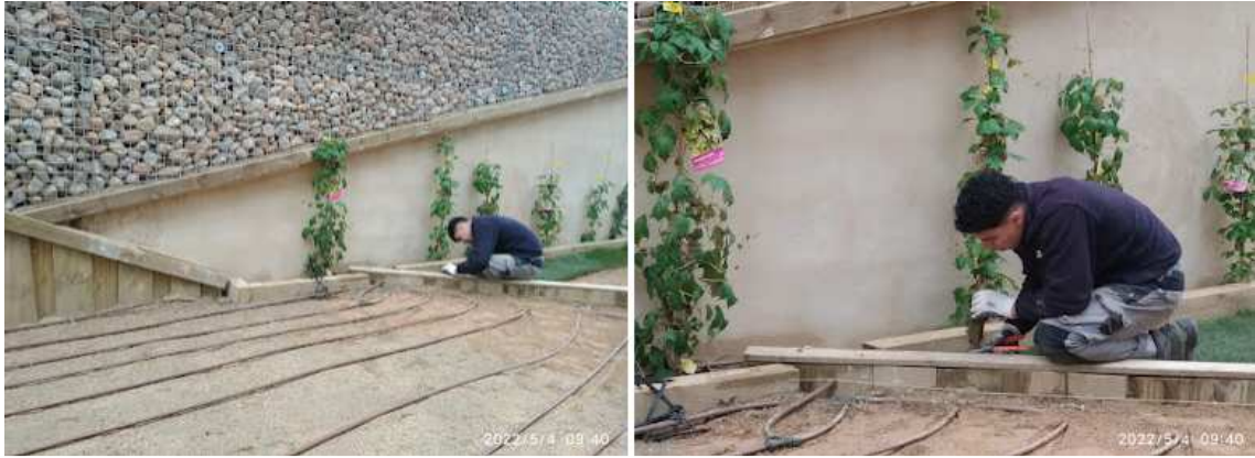
INSTALACION DE RIEGO A GOTEO PARA TEPES
