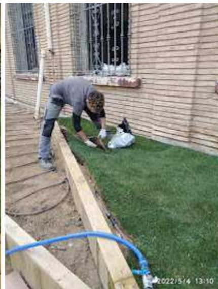
INSTALACION DE TEPES, AJUSTE E INSTALACION DE RECORTES.
