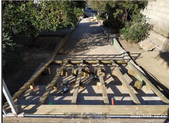
INSTALACION DE RAMPA DE MADERA ACESSO A ZONA DE BANCALES.
