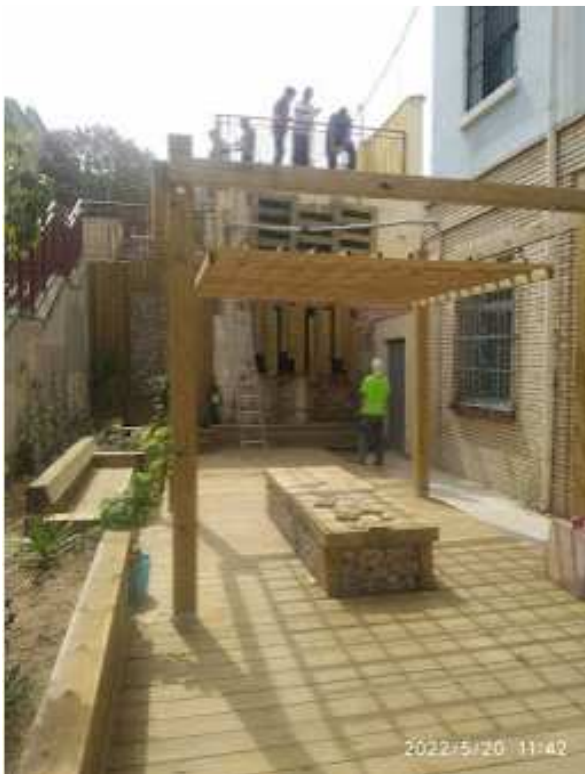
INSTALACION DE ESTRUCTURA DE JARDIN VERTICAL PARA COLOCAR JARDINERAS DE GERANIOS.
