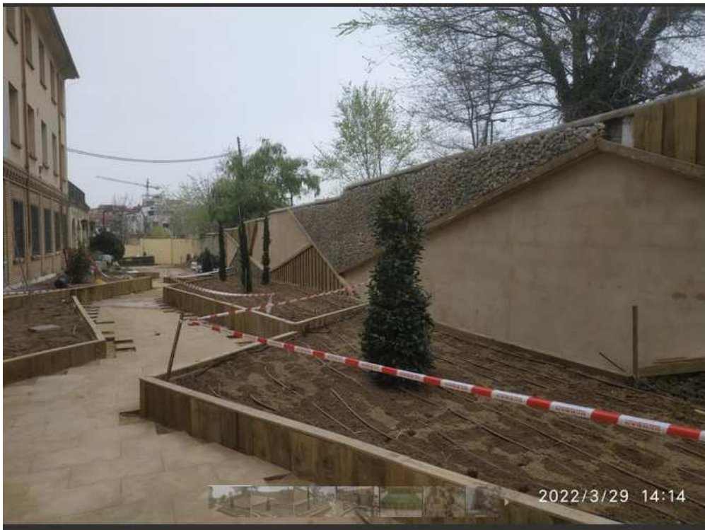
INSTALACION DE ELEMENTOS VEGETALES LAUREL - CIPRES – PHOTINIAS.
