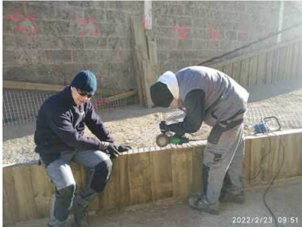
CORTE DE MALLA PARA LA FABRICACION DEL GAVION CON RADIAL.
