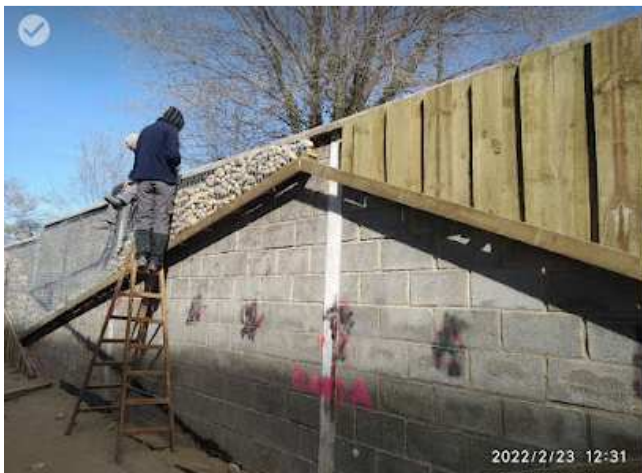
COLOCACION DE PIEDRA DENTRO DE LA MALLA DE GAVION.
