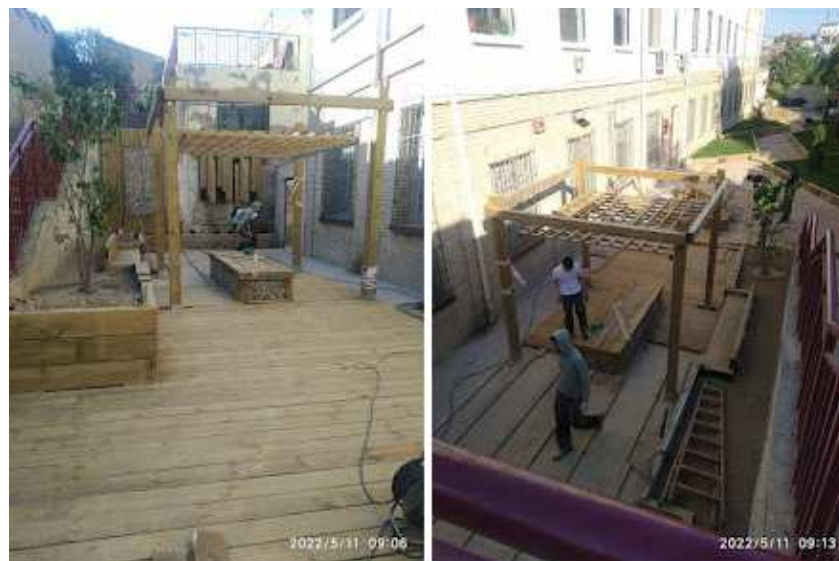
COLOCACION DE TARIMA
