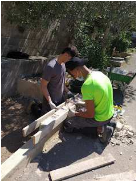
ARREGLO DE PAREDES ( ENCOFRADO Y VERTIDO DE HORMIGON)
