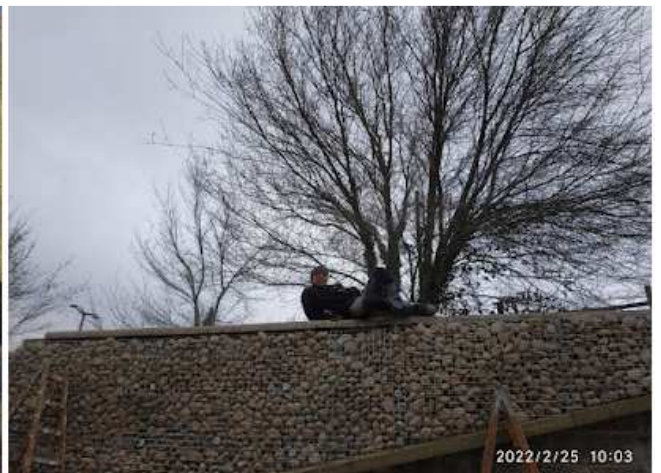
COLOCACION DE PIEDRA DENTRO DE LA MALLA DE GAVION.
