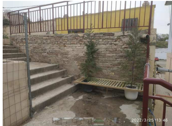
ARREGLO DE ZONA DE ACCESO DESDE LOS BANCALES A JARDIN INFERIOR : RETIRADA DEL ENFOCADO VIEJO, DEJANDO EL LADRILLO ORIGINAL VISTO Y CONSTRUCCION DE BANCO – JARDINERA DE MADERA.
