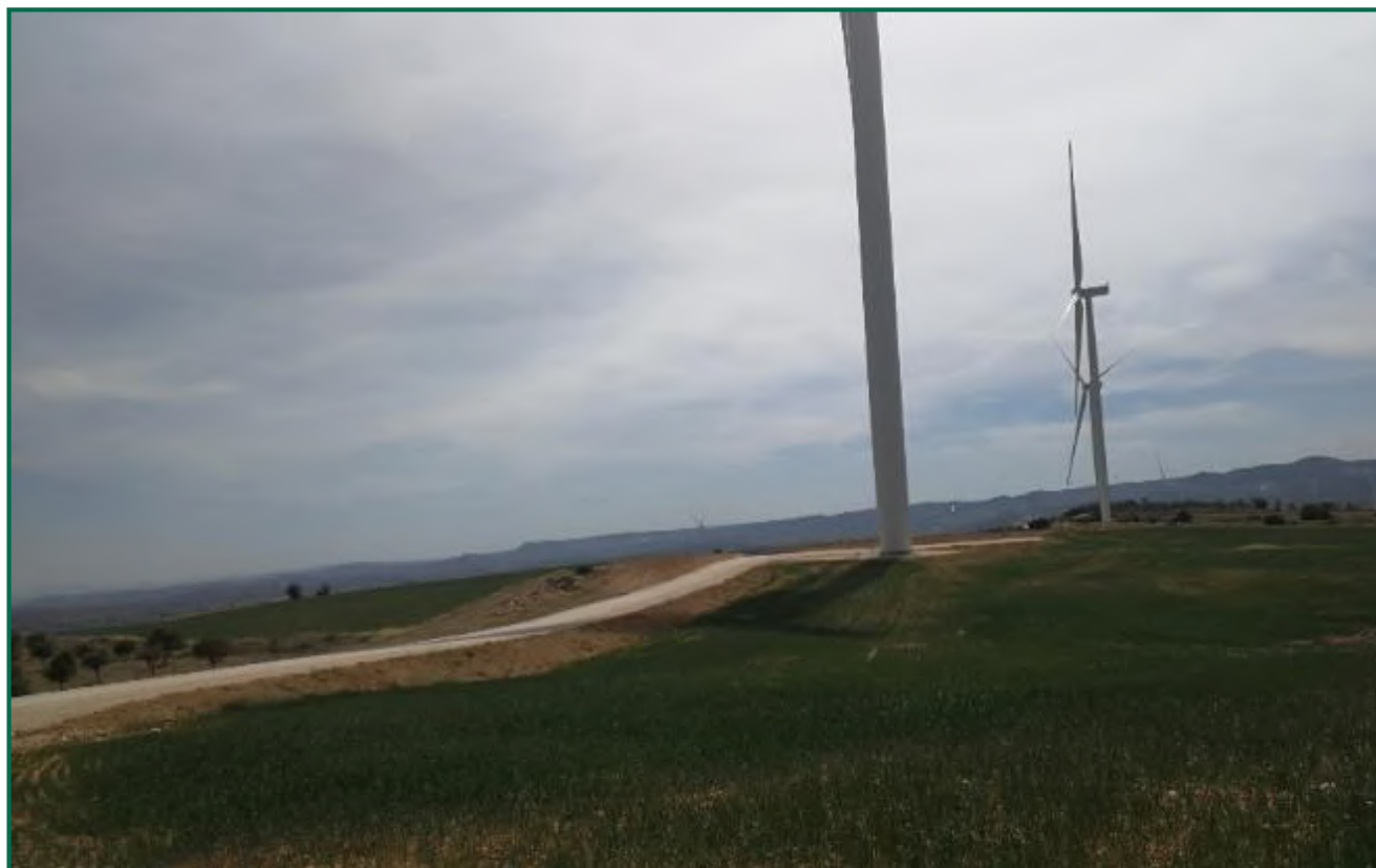
Fotografía 5. Talud AEG A1.2
