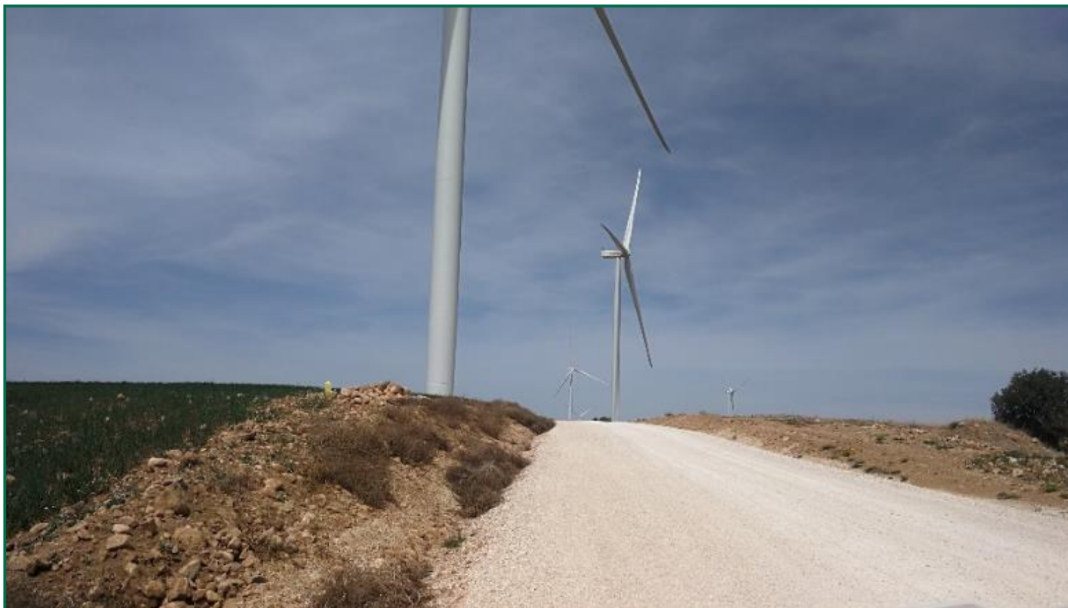
Fotografía 6. Talud AEG A1.2
