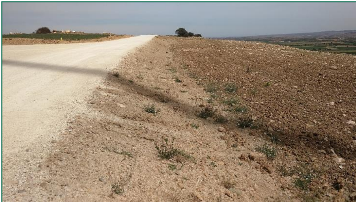
Fotografía 8. Talud pista AEG A1.3
