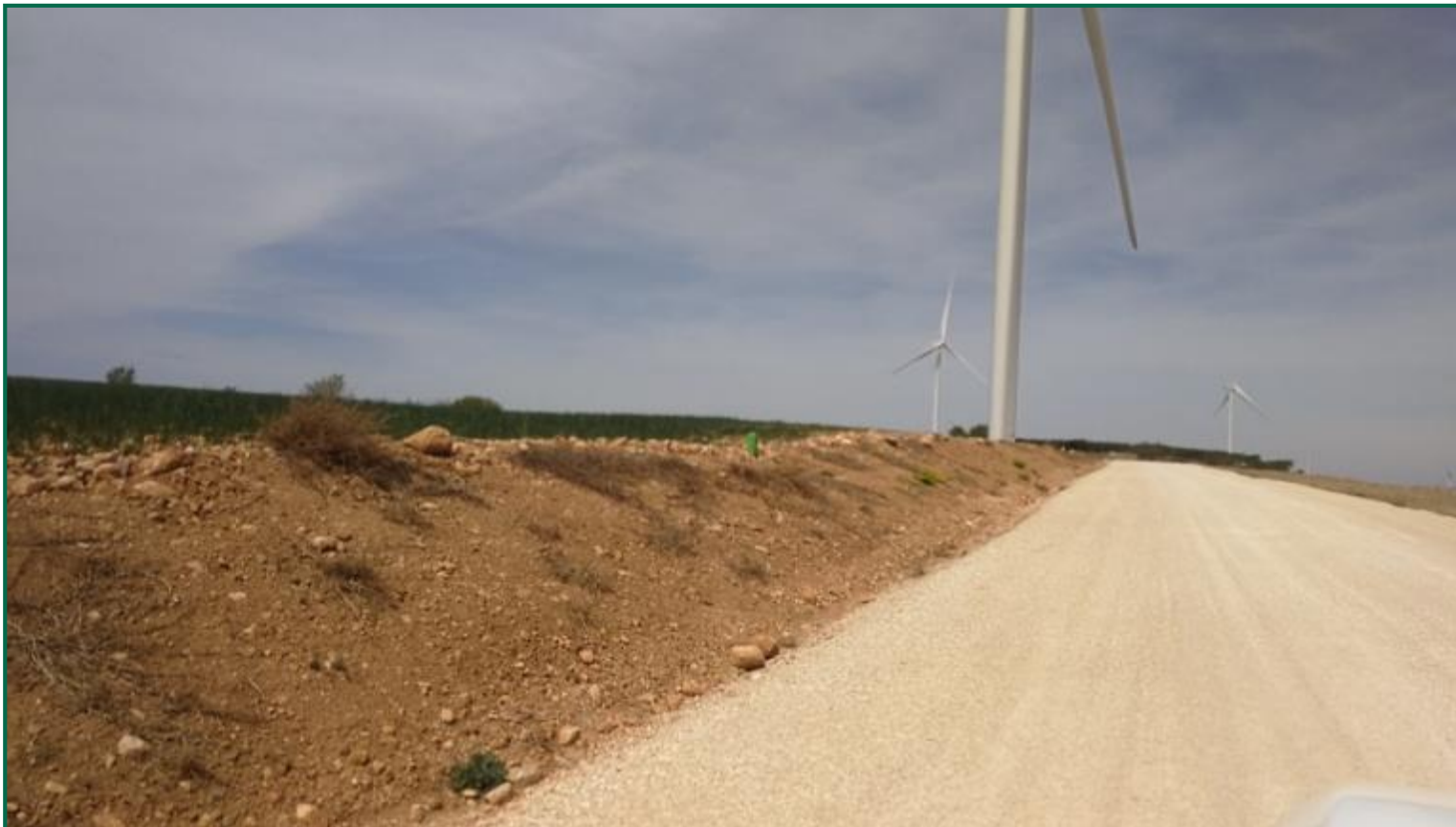
Fotografía 4. Talud AEG A1.1
