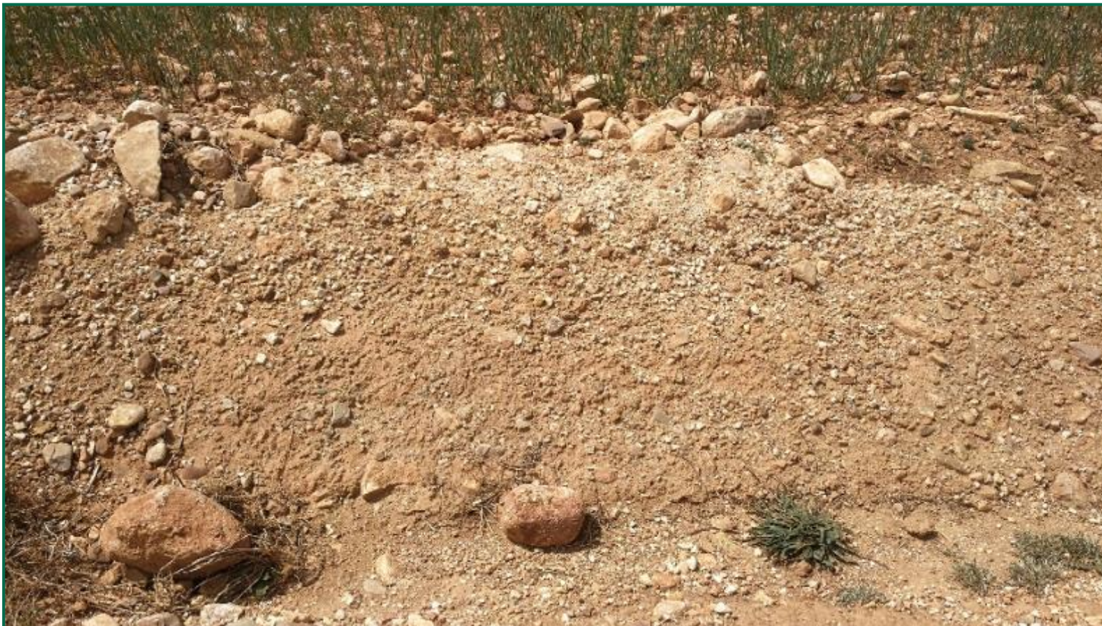
Fotografía 1. Semillas de la hidrosiembra en talud pista A1.4.
