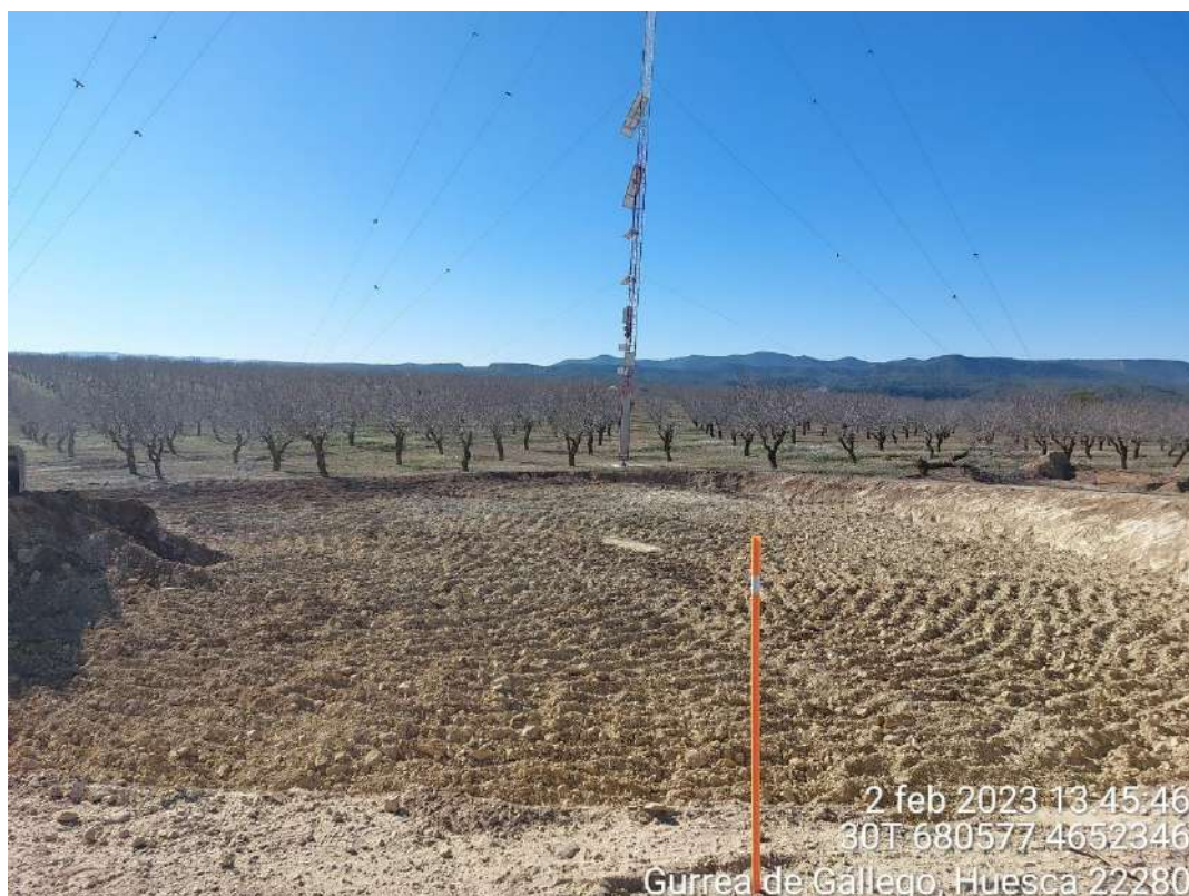
Imagen 3. Excavación en OBII.
