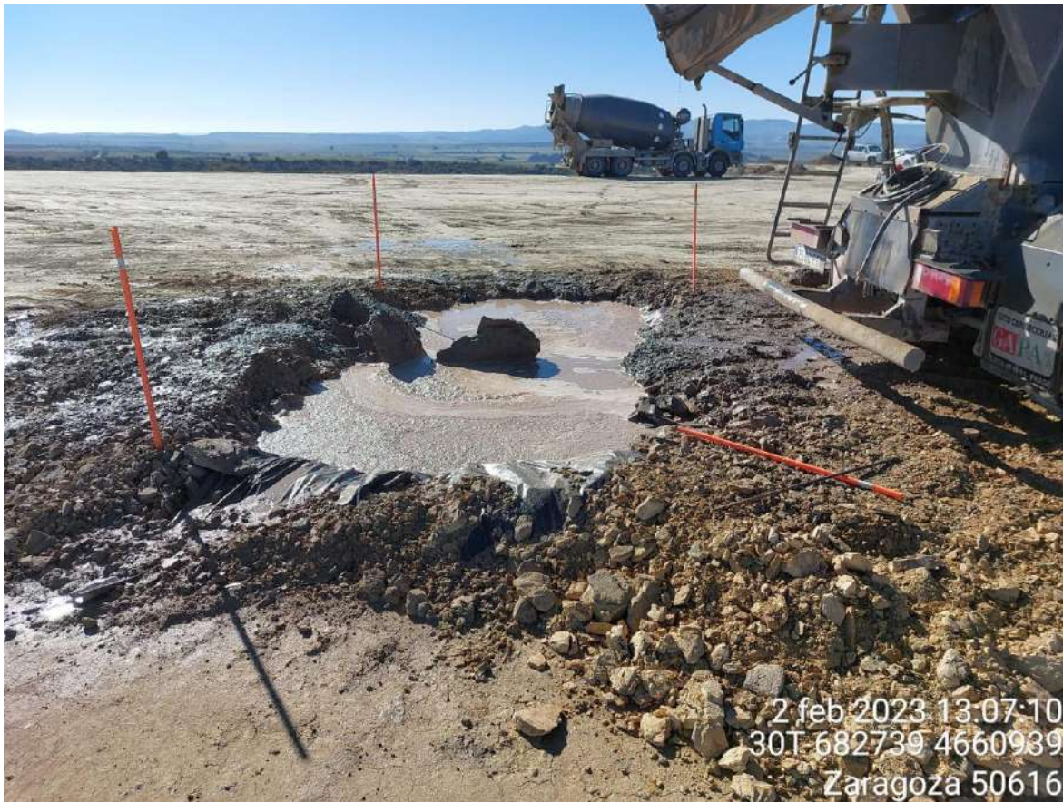
Imagen 2. Pozo de lavado colmatado durante el hormigonado de OBIII-02. COLLOSA gestiona el vaciado parcial del pozo mediante absorción. Al terminar el hormigonado se pasará maquinaria para retirar el hormigón de la plataforma y gestionarlo como tal.
