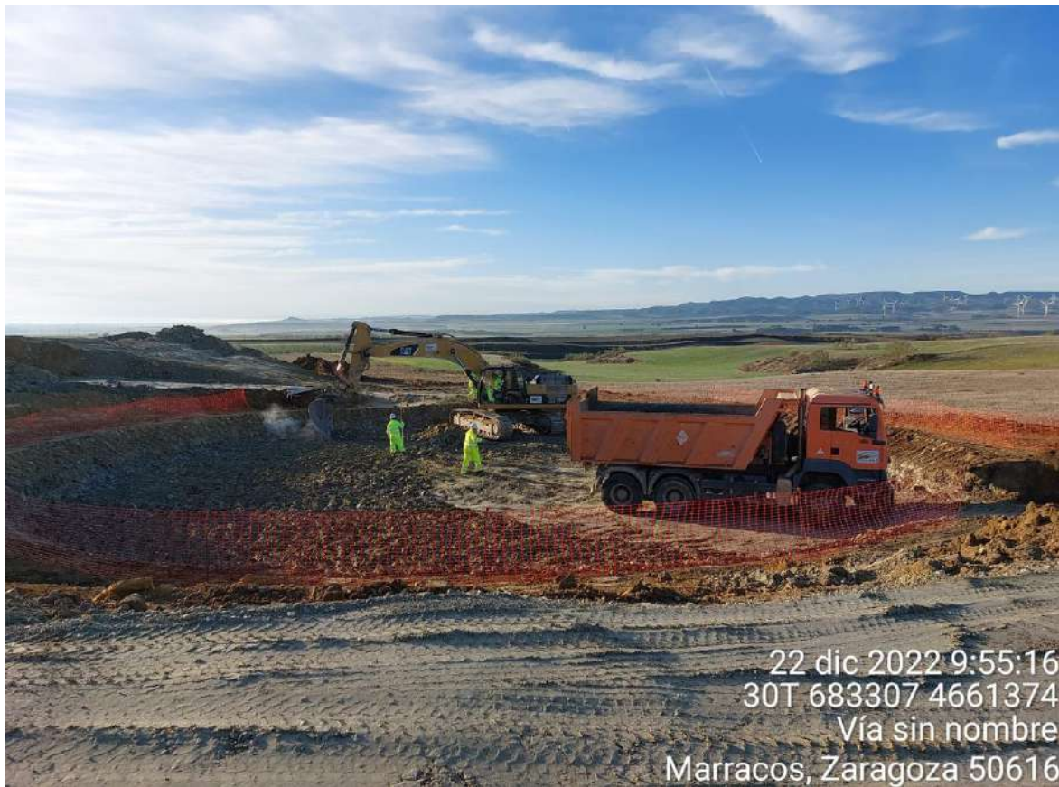
Imagen 2. Maquinaria trabajando en la excavación de OBIII-1
