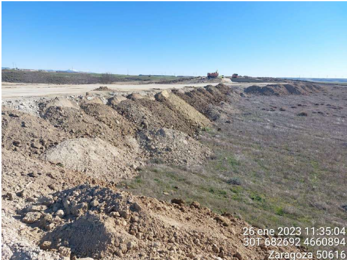
Imagen 2. Tierra vegetal acopiada en OBIII-02 que será utilizada para la restauración de ese talud.
