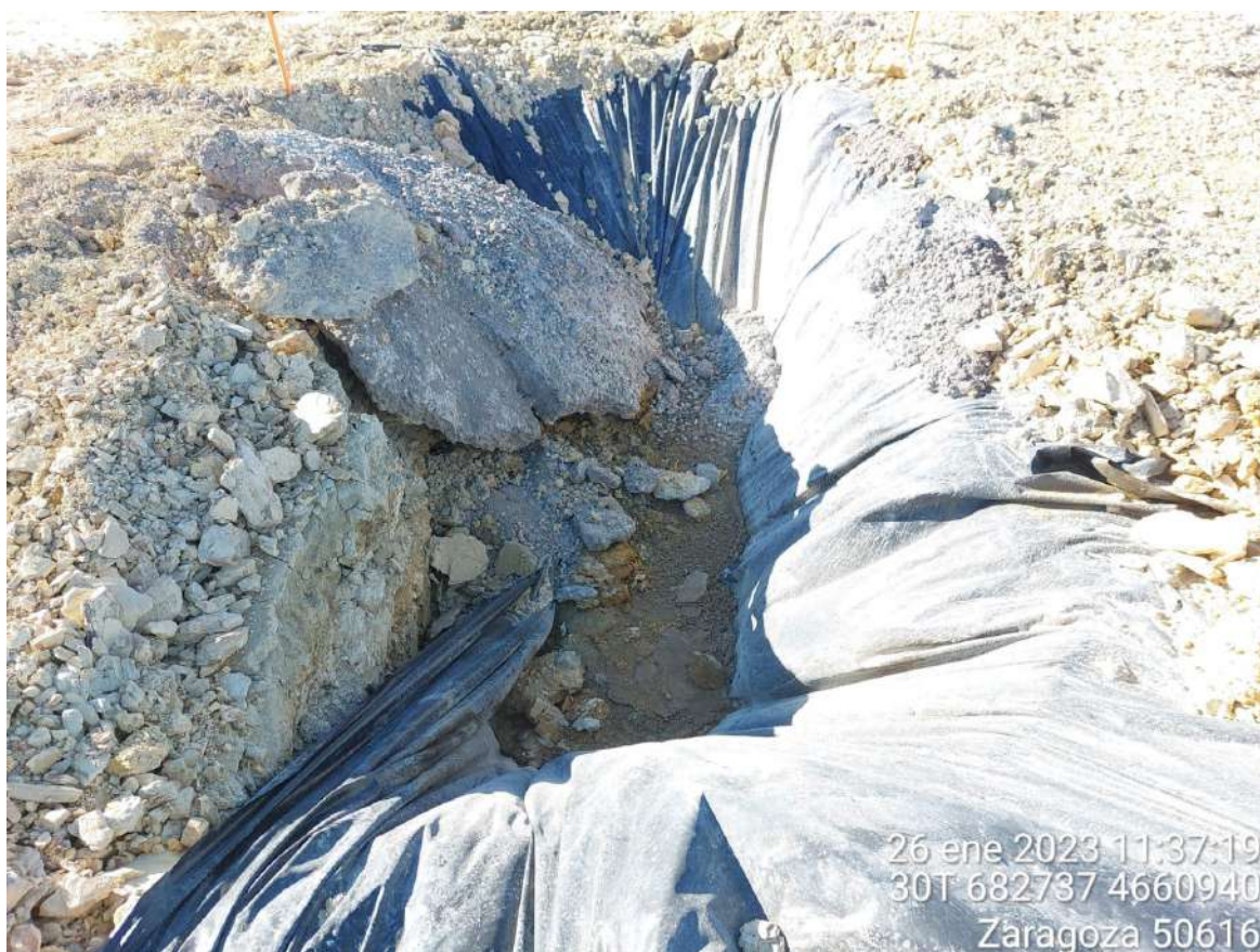
Imagen 4. Pozo de lavado utilizado en OBIII-02. Se recuerda que el suelo debe estar protegido lo máximo posible ante el hormigón. Al finalizar su uso ese hormigón se picará y se gestionará correctamente, restaurando la zona en la que se creó ese pozo.
