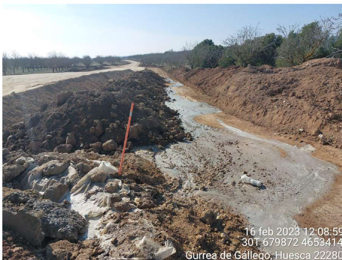
Imagen 1. Tierra contaminada por residuo de agua con hormigón debido a la colmatación del pozo de lavado.
