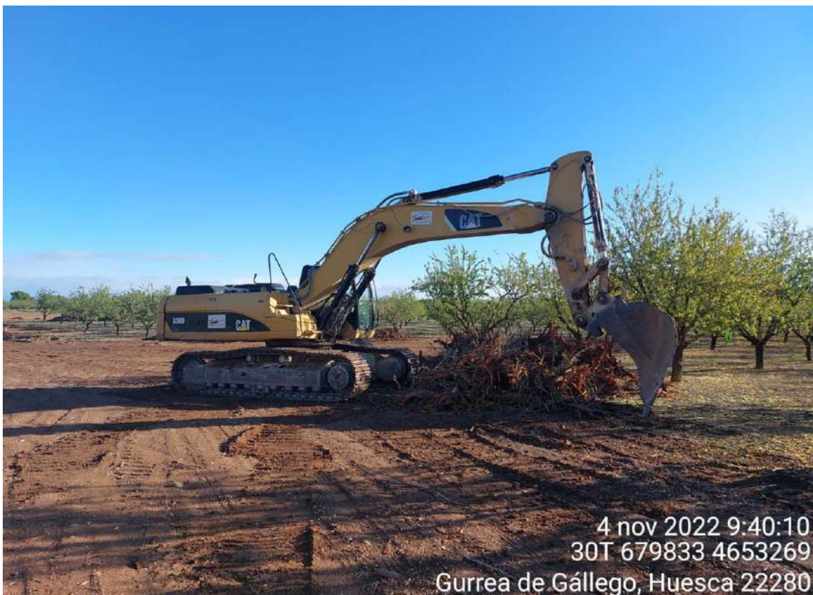
Imagen 2. Máquina en OBII-03 tras arrancar los almendros y amontonar el material extraído.
