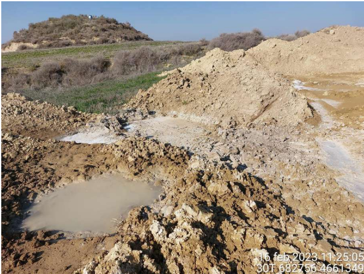
Imagen 2. Manchas de agua con hormigón en la zona de la TM de OBIII próxima a los cordones de tierra vegetal.
