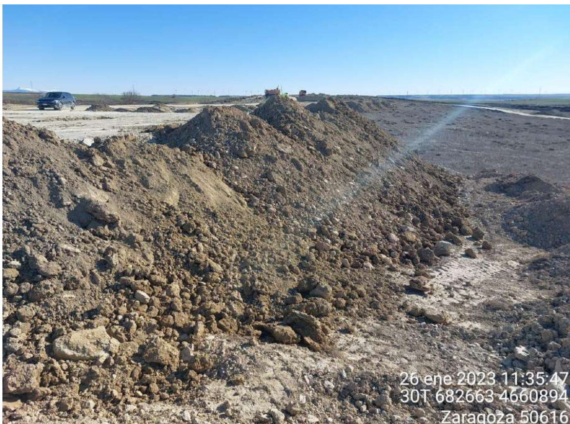
Imagen 3. Tierra vegetal acopiada en OBIII-02 que será utilizada para la restauración de ese talud.
