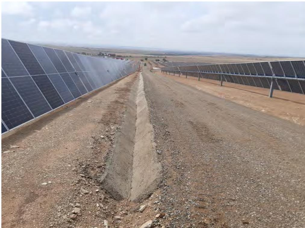
Fig. 1 Perfil de cuneta arreglado.
