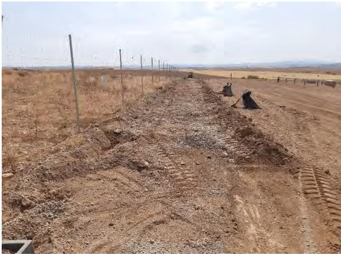
Fig. 1 Proceso de tapado de zanja. A la derecha, último cordón de tierra vegetal
