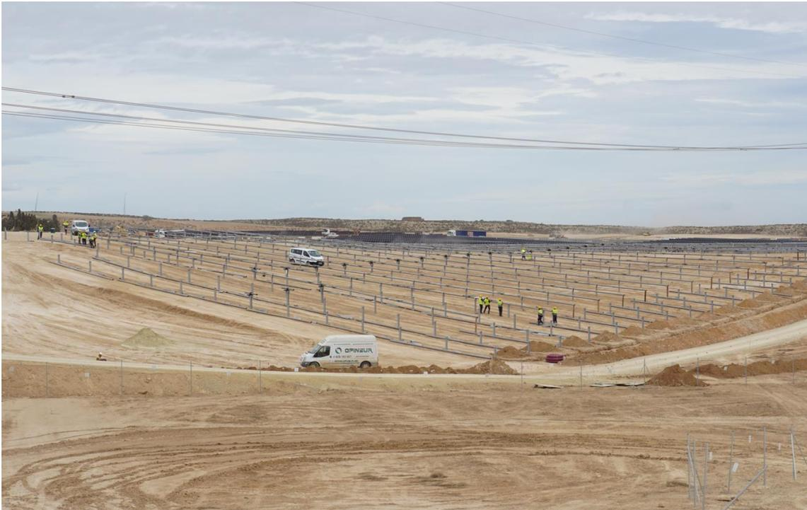
*Figura 8 Instalación de seguidores*
