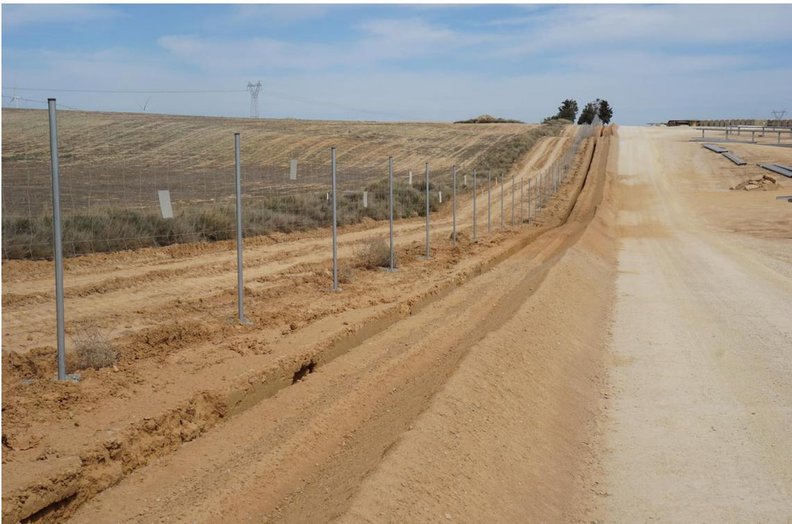
*Figura 7 Vallado y zanja para red de distribución eléctrica*
