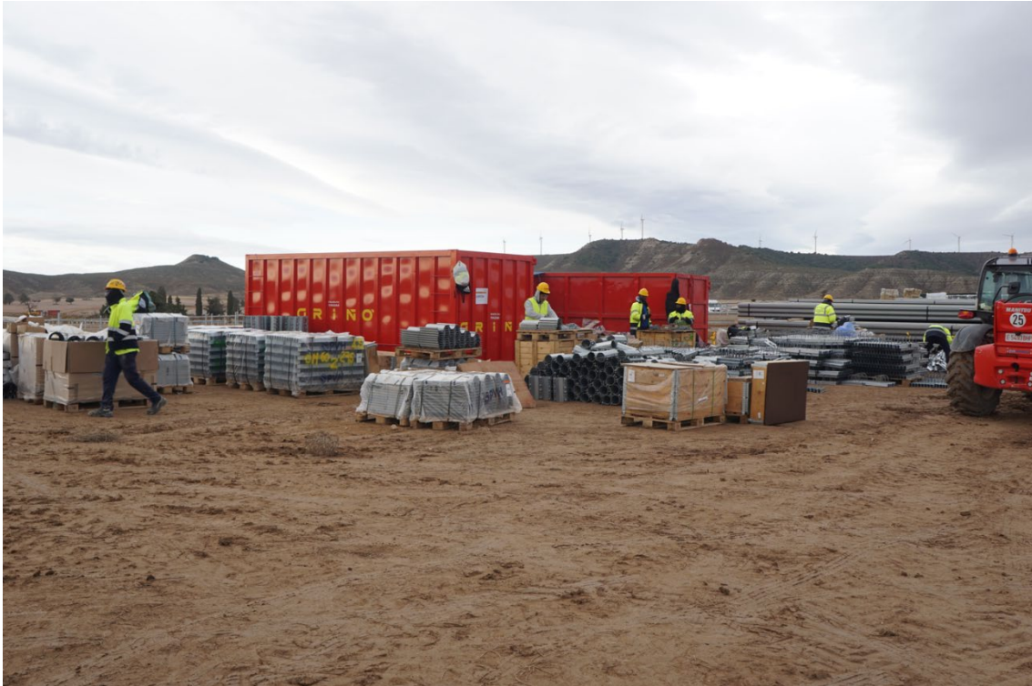
Figura 2b Mecanización de elementos para montaje de seguidores
