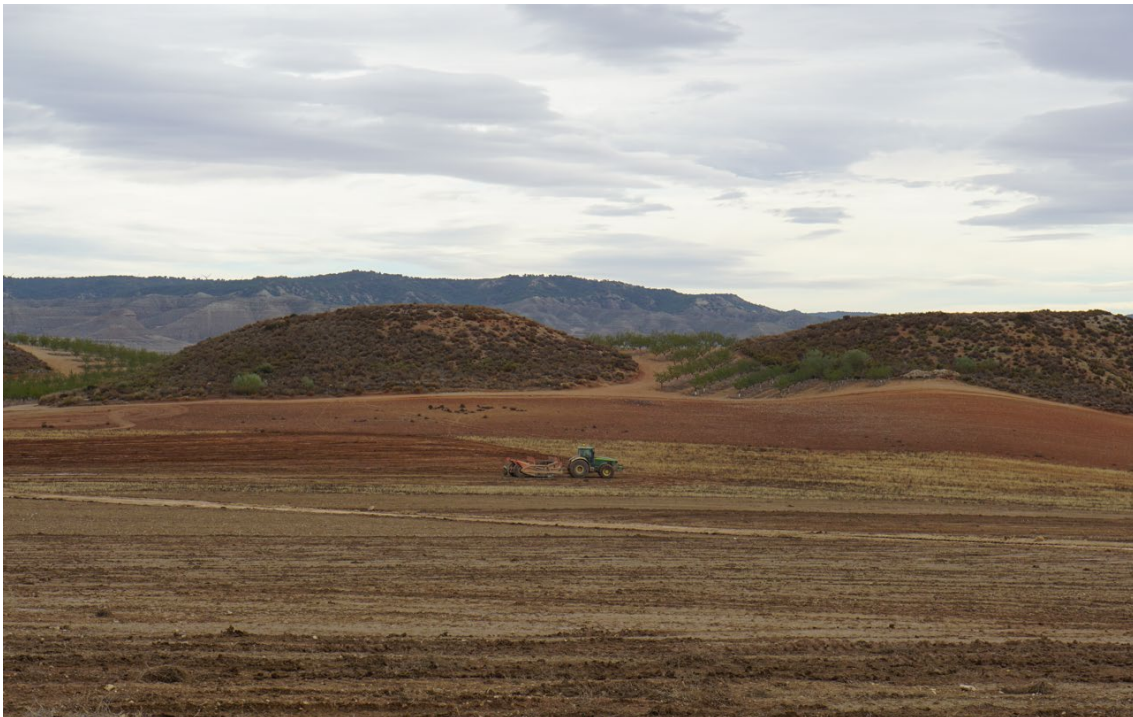
Figura 2a Trabajos de movimiento de tierras
