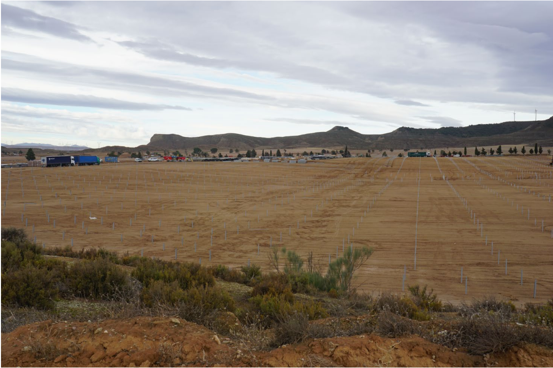
Figura 8 Trabajos de hincado en la zona Noreste
