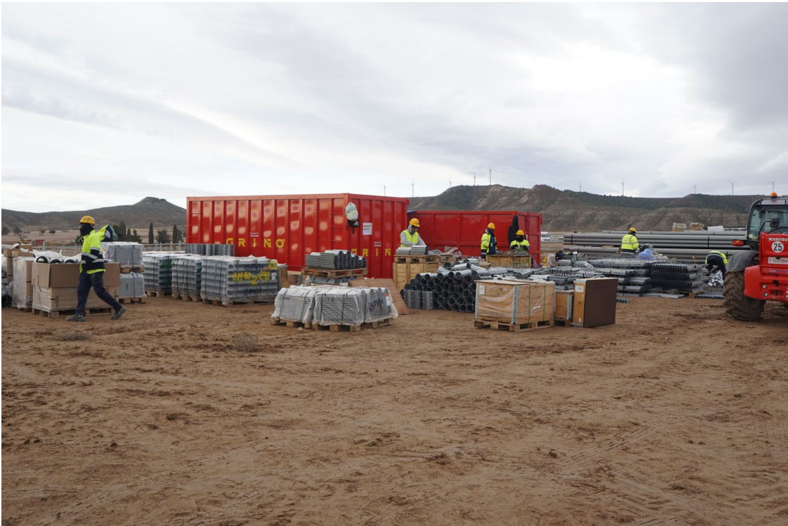
Figura 9 Mecanizado de piezas para montaje de seguidores
