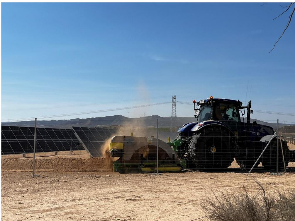
*Figura 2 Apertura de zanjas para el cableado de los CCTV*
