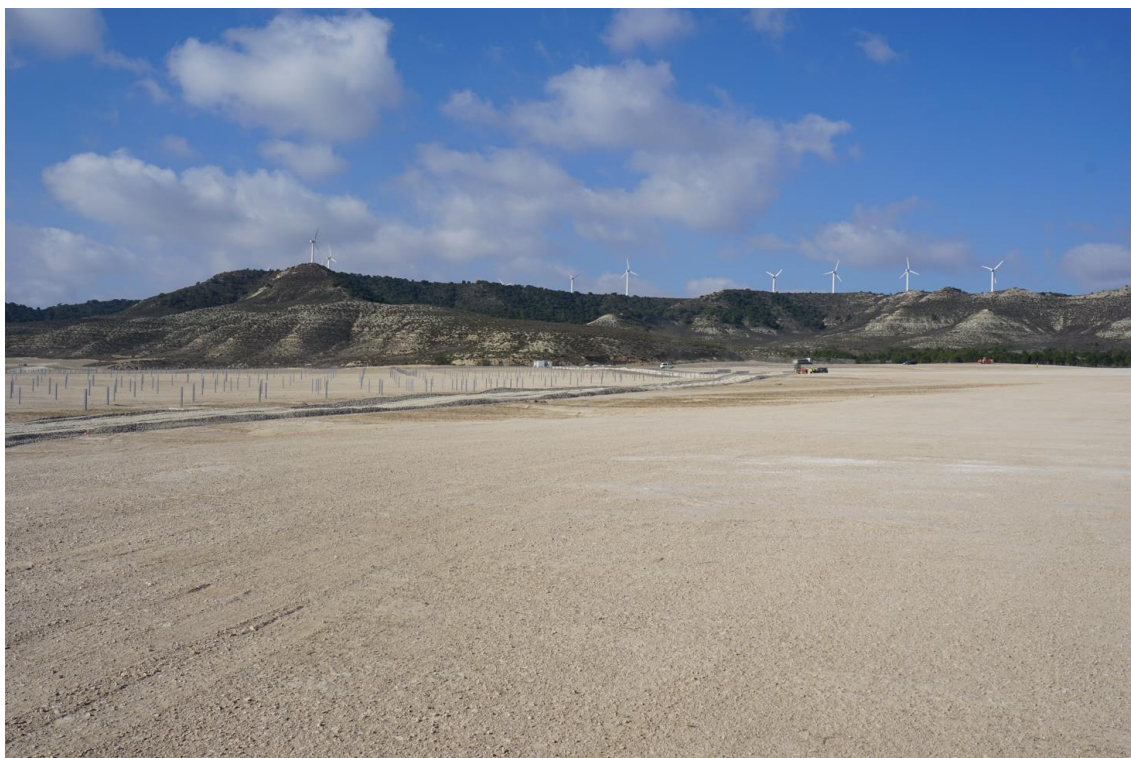
Figura 6 Adecuamiento de viales interiores
