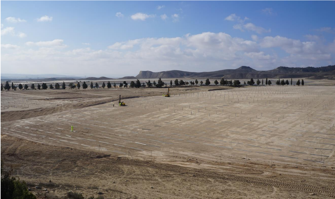
Figura 2b Trabajos de hincado
