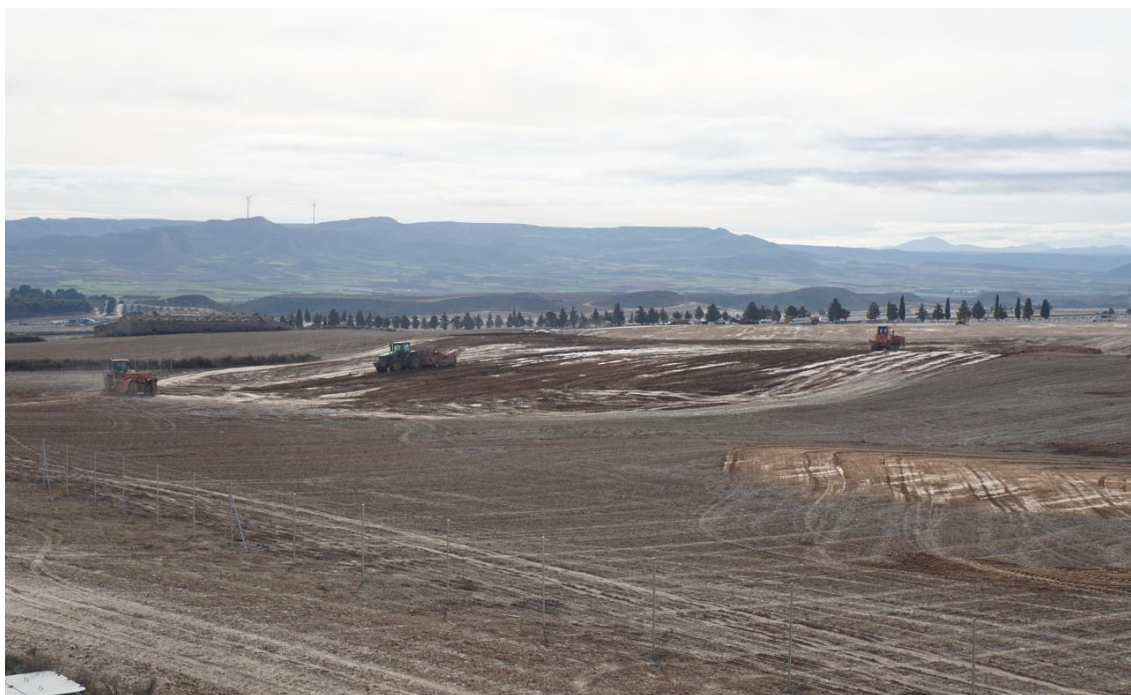
Figura 2 Movimiento de tierras en la zona norte de Plana de la Pena 1
