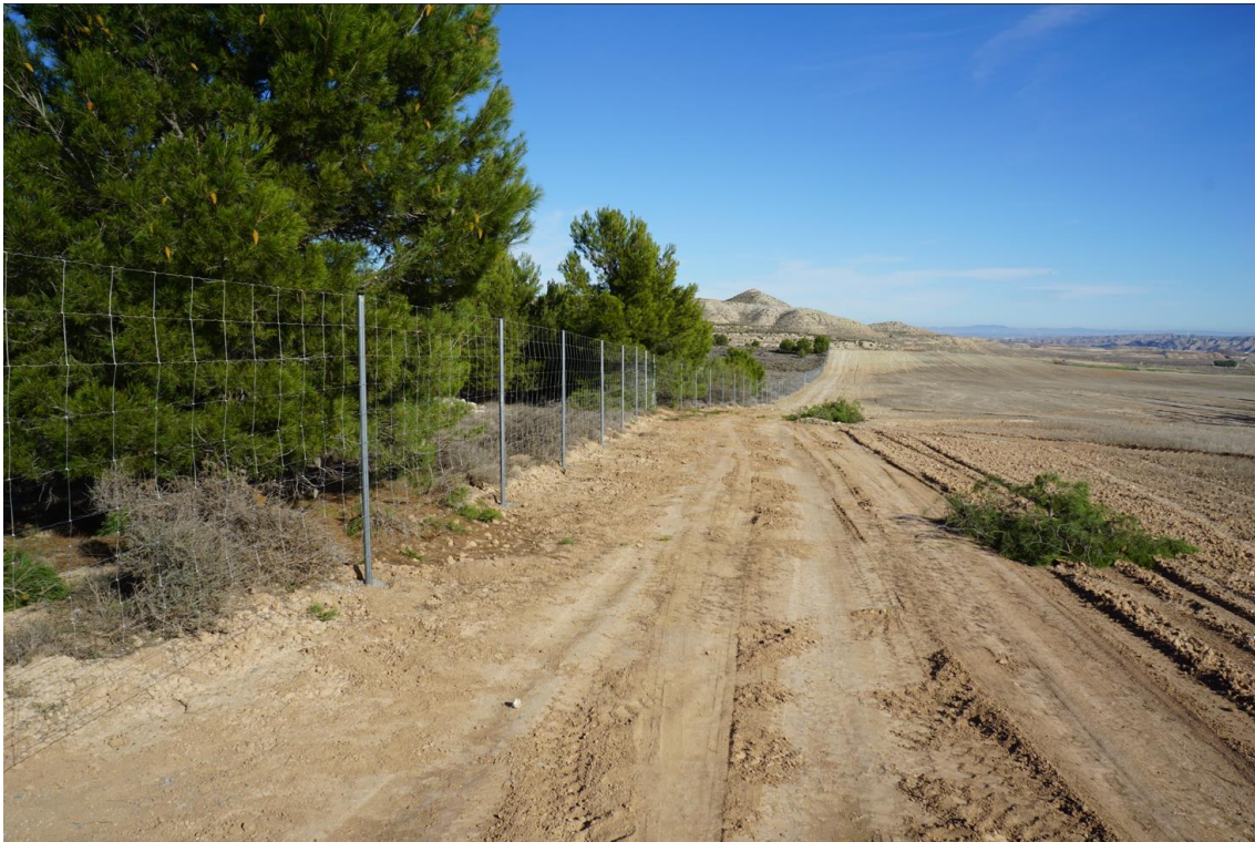
Figura 7 Instalación de vallado perimetral
