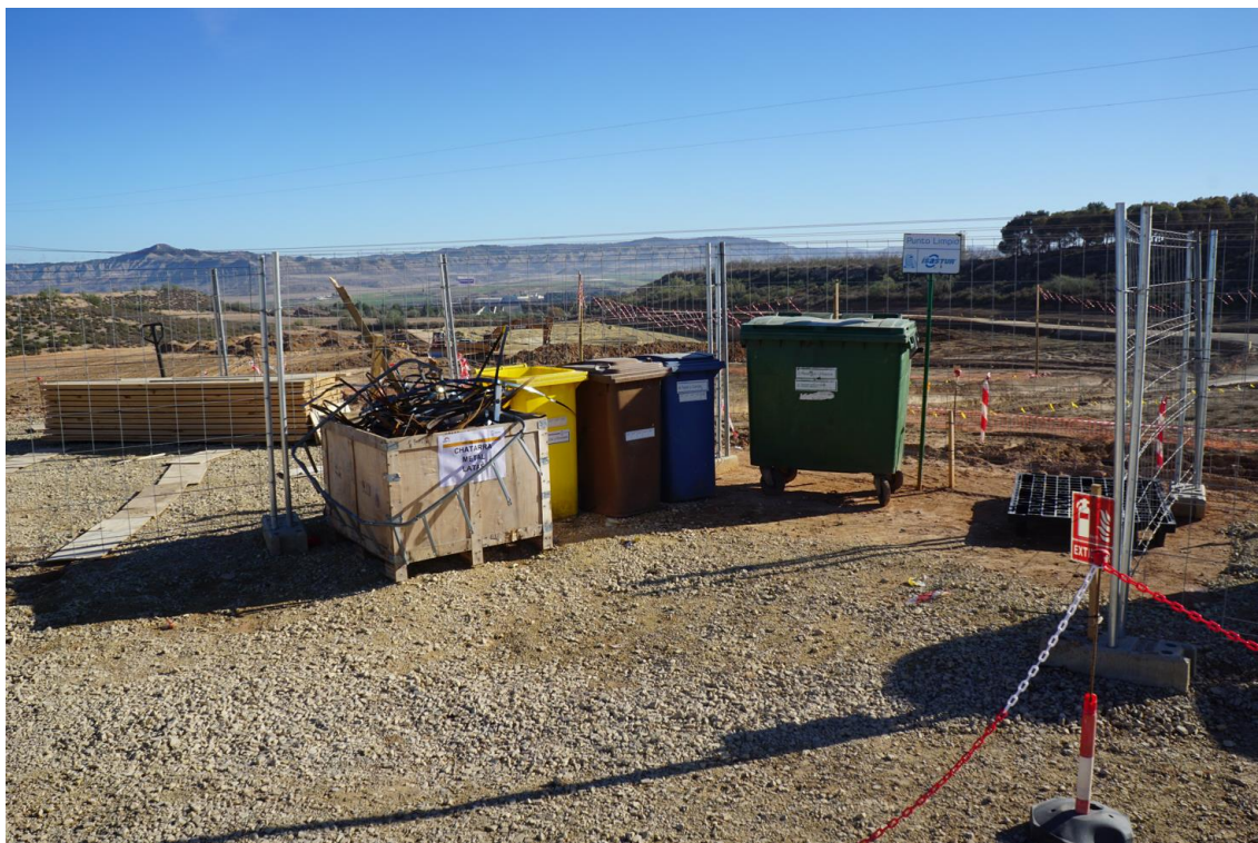
Figura 3 Punto limpio de residuos no peligrosos
