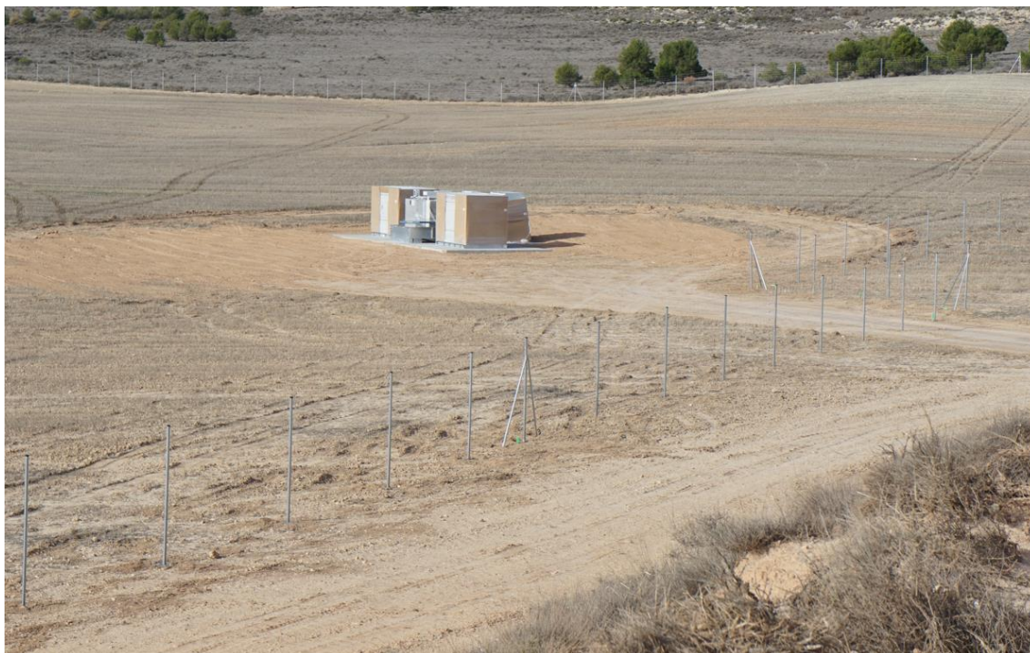
Figura 5 Vista del vallado perimetral instalado en Plana de la Pena 1
