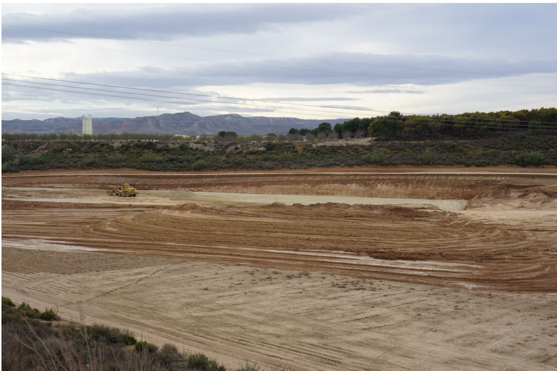
Figura 9 Movimientos de tierra en localización de subestación eléctrica
