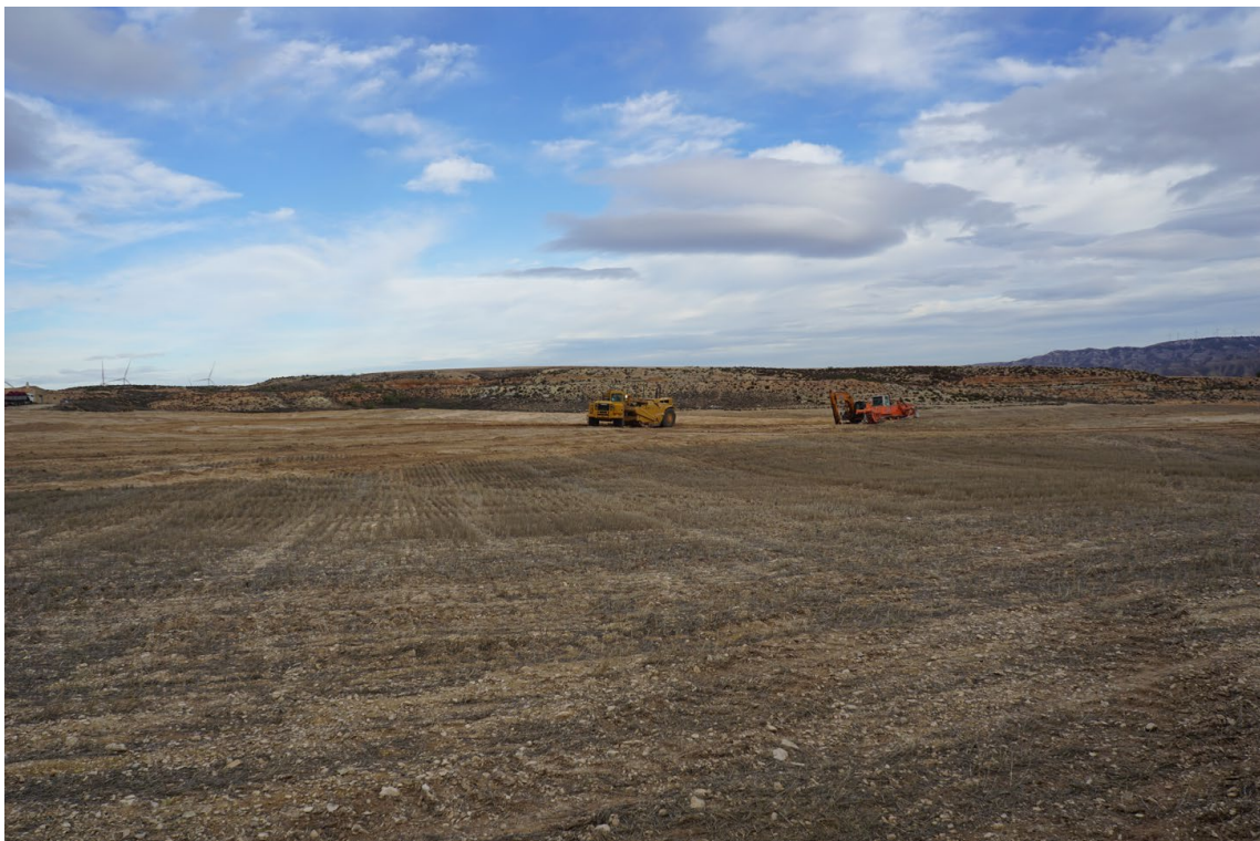
Figura 2 Movimiento de tierras en la zona norte de Plana de la Pena 1
