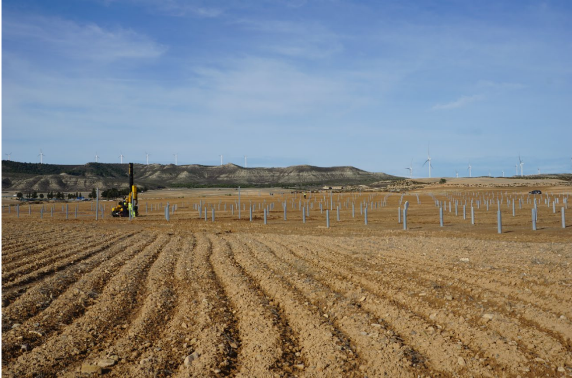
Figura 2b Trabajos de hincado
