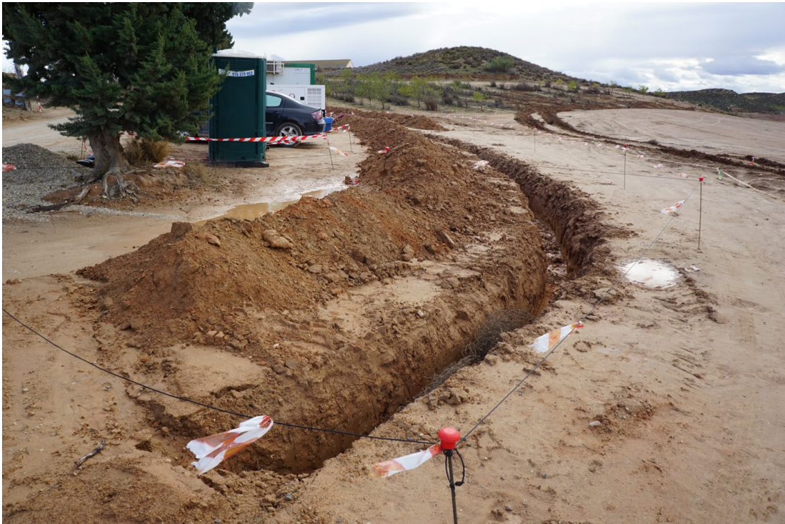
Figura 7 Construcción de zanja para evacuación eléctrica
