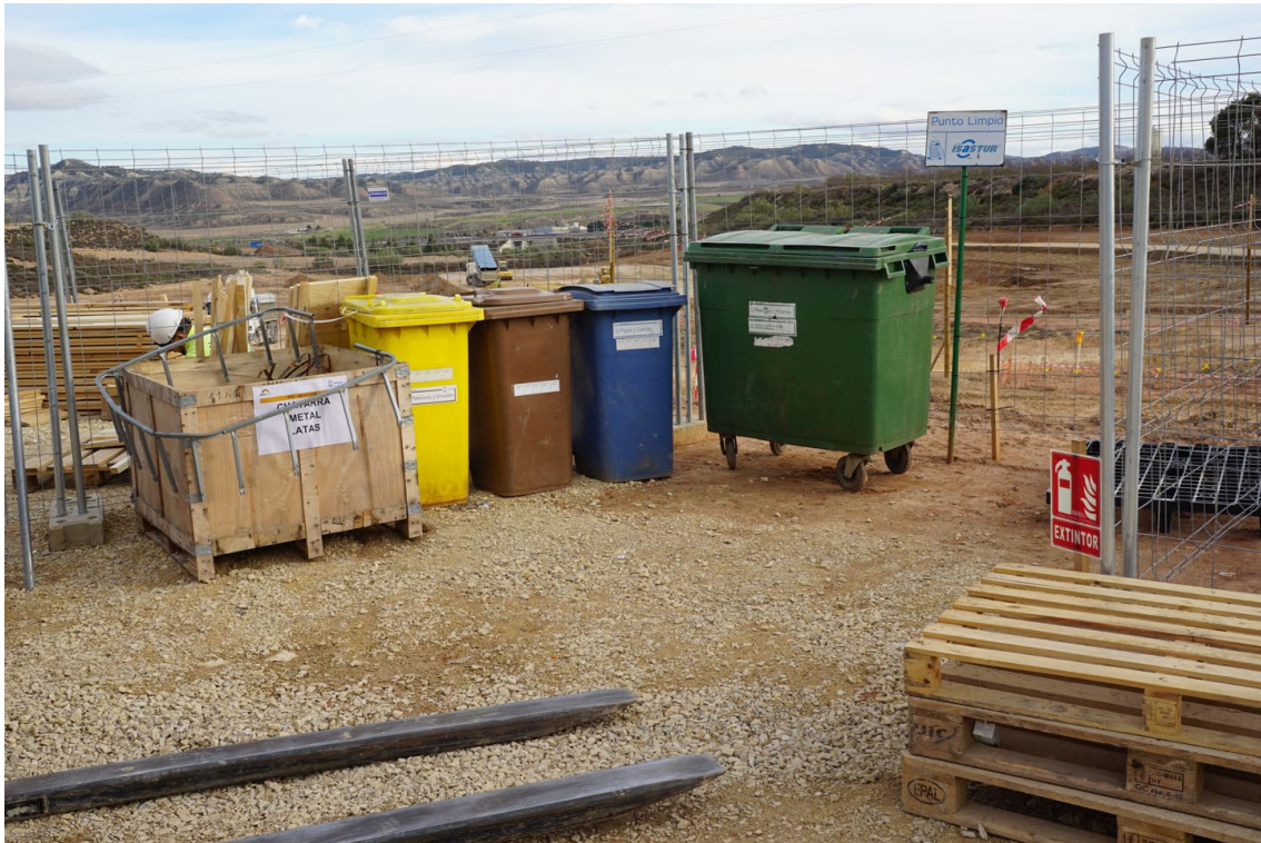
Figura 3 Punto limpio de residuos no peligrosos
