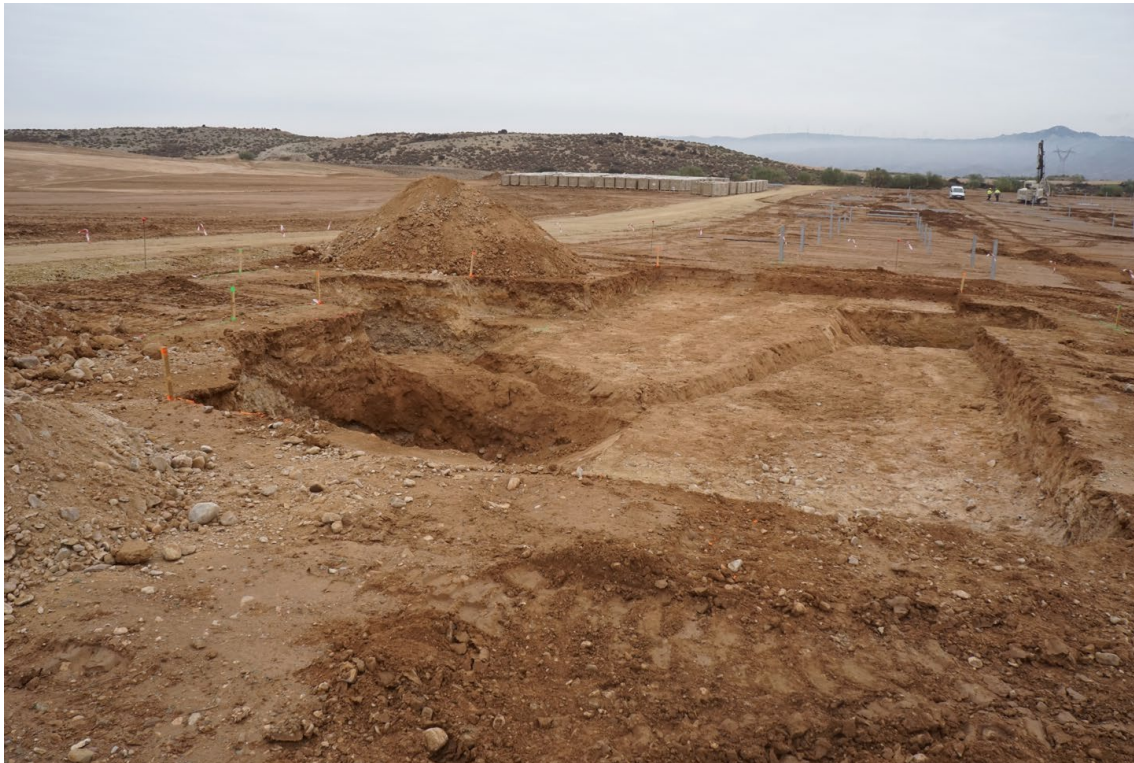
Figura 4 Vista amplia obras en Plana de la Pena 1
