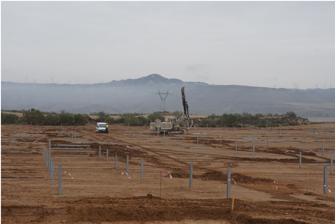
Figura 8 Repaso de hincado en Plana de la Pena 1
