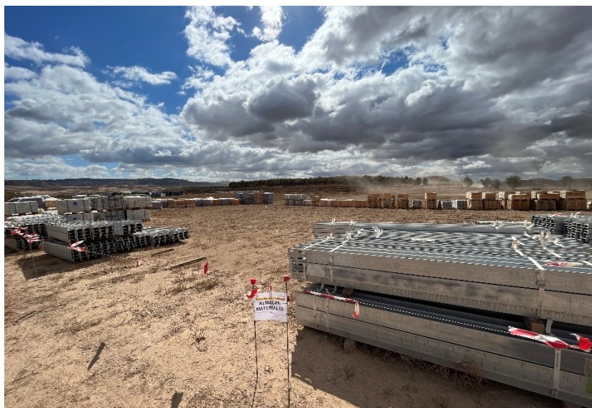
Figura 4 Zona de acopio
