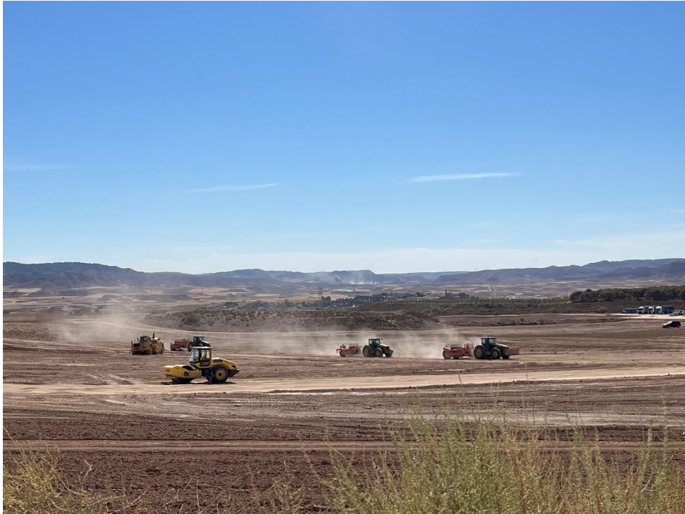
Figura 8 Trabajos de movimiento de tierras
