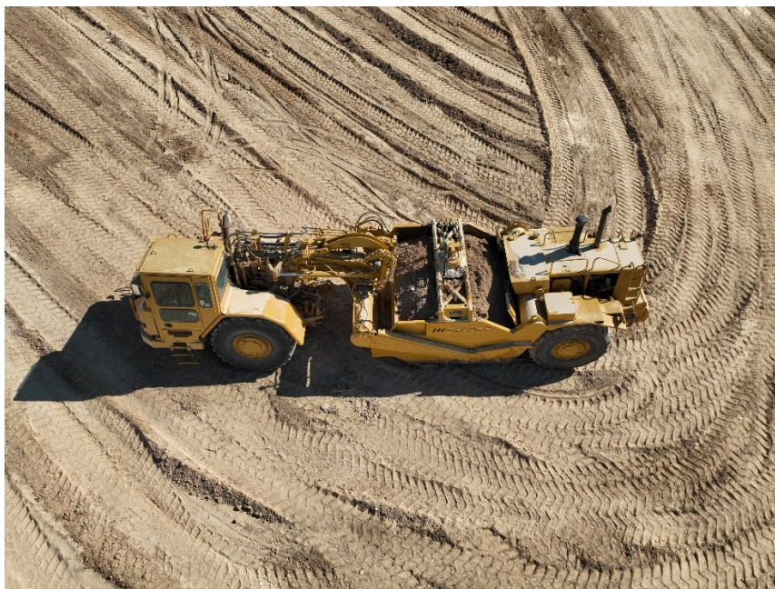
Figura 2 Trabajos de movimientos de tierras
