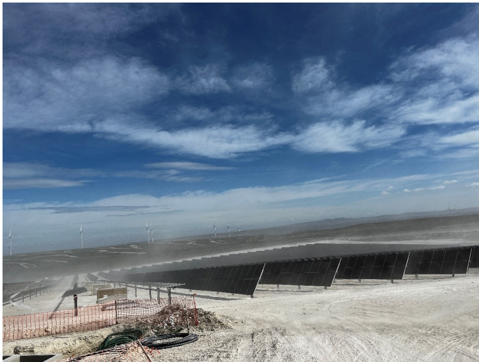
Figura 9 Montaje de los módulos fotovoltaicos
