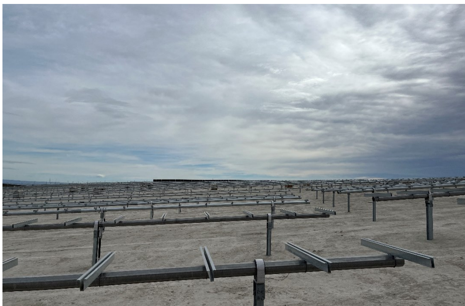
Figura 7 Montaje de los trackers
