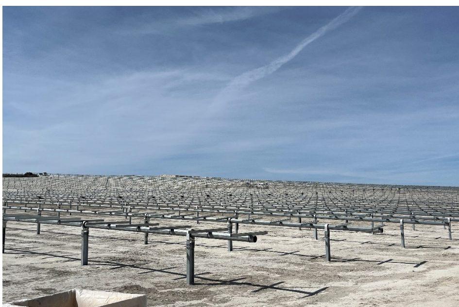
Figura 8 Montaje de los trackers
