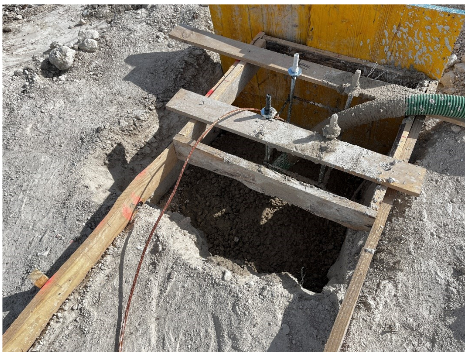
Figura 10 Cimentación de la base de los CCTV
