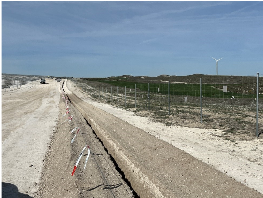
Figura 2 Apertura de zanjas
