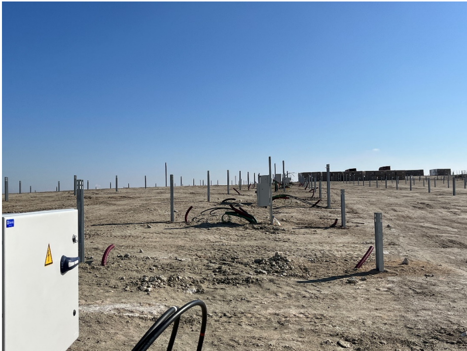
Figura 9 Montaje de los inversores
