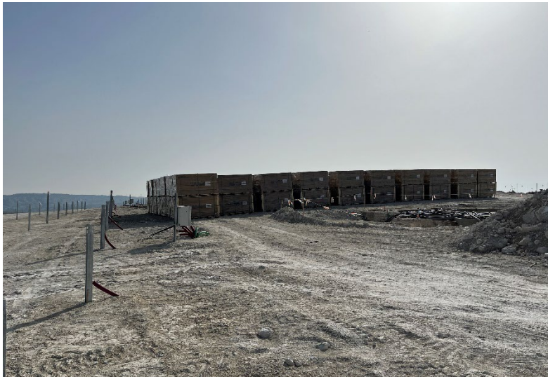
Figura 5 Acopio de módulos fotovoltaicos
