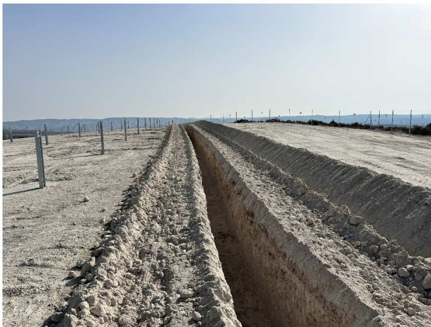
Figura 2 Apertura de zanjas
