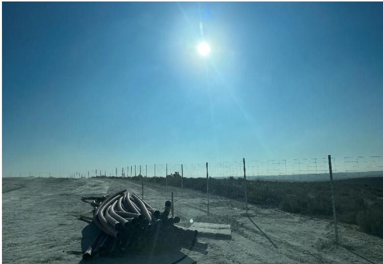
Figura 5 Acopio de tubos de corrugado
