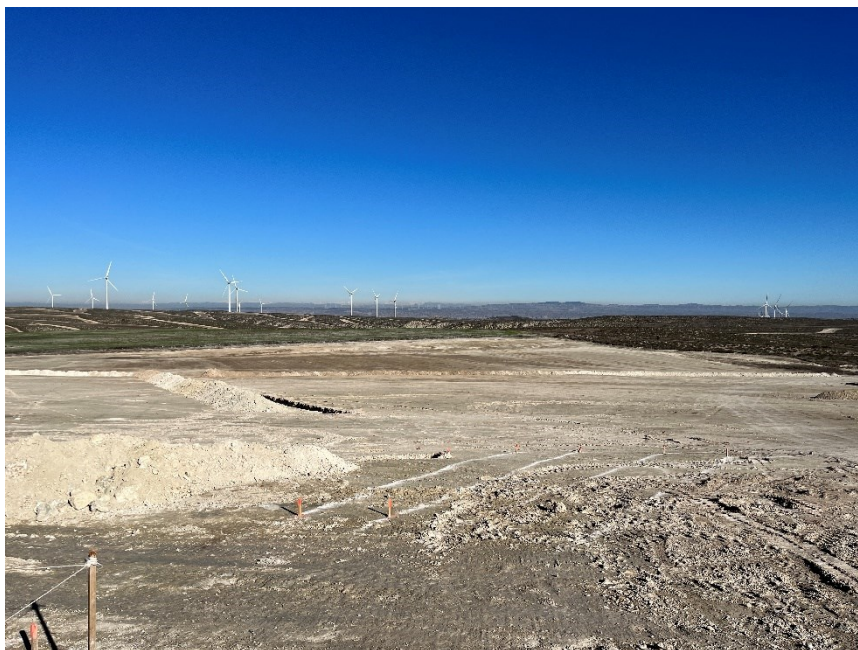
Figura 2 Apertura de zanjas
