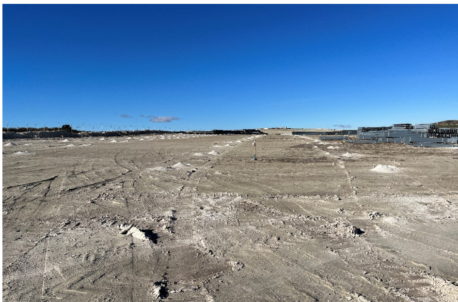
Figura 7 Perforado del terreno para facilitar el hincado
