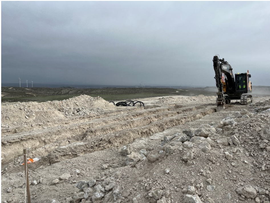
Figura 9 Apertura de zanjas
