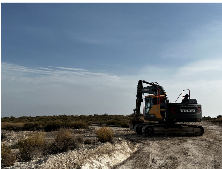
Figura 2 Trabajos de apertura de viales
