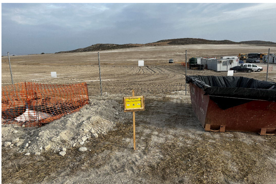
Figura 6 Zona de lavado de cubas de hormigón
