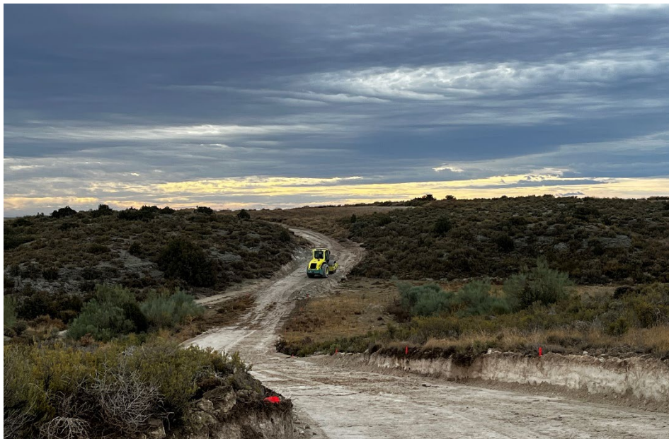
Figura 5 Apertura de viales
