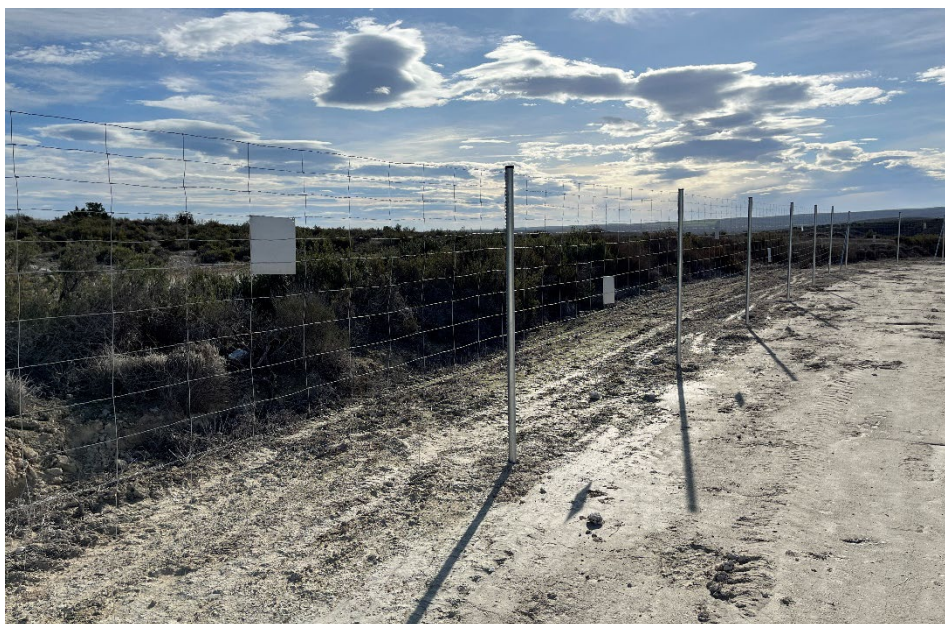
Figura 7 Instalación del vallado perimetral
