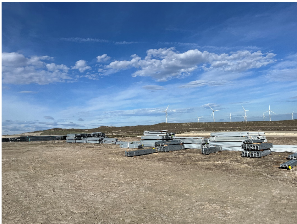
Figura 9 Acopio de material de construcción
