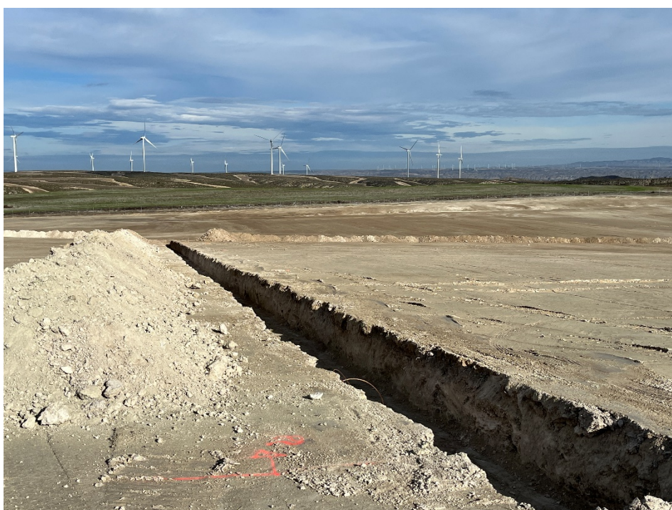
Figura 10 Apertura de zanjas
