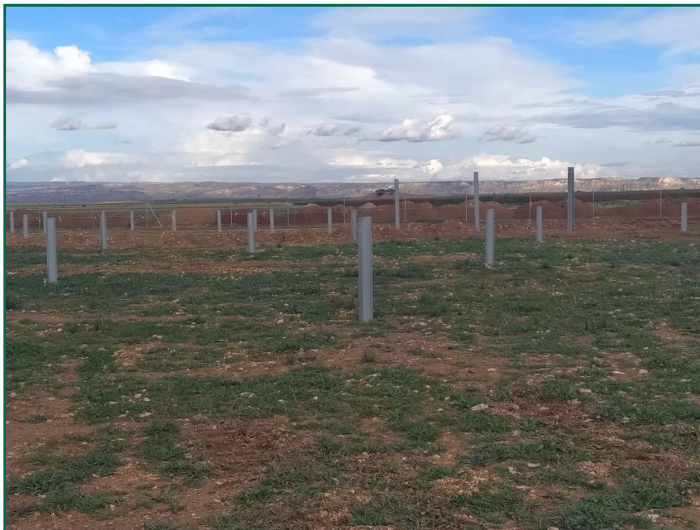
Fotografía 4. Hincas sobre el terreno.
