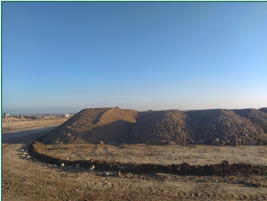
Fotografía 3. Acopio de tierra.
