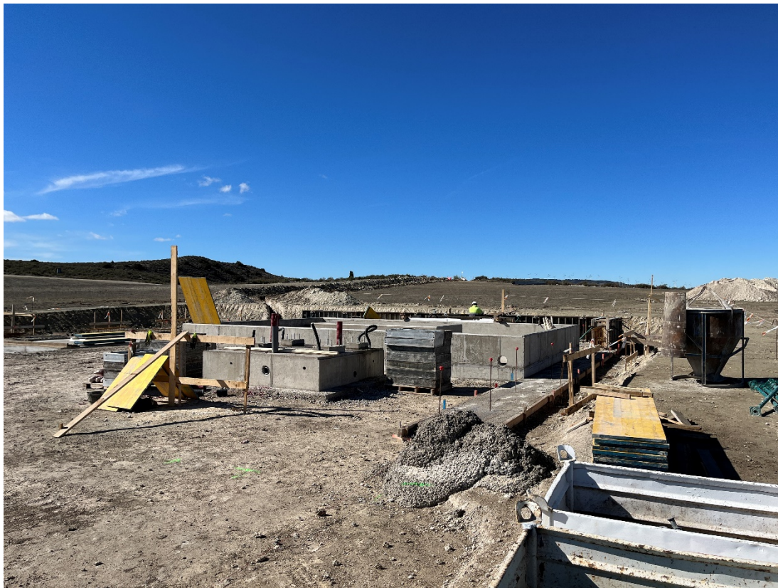
Figura 13 Cimentación de la SET
