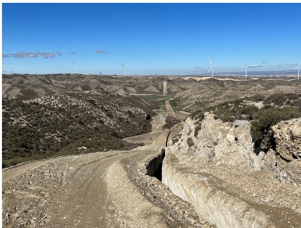
Figura 12 Zanja de la red de evacuación
