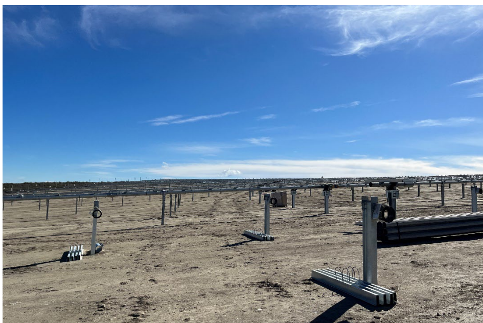
Figura 8 Montaje de los trackers
