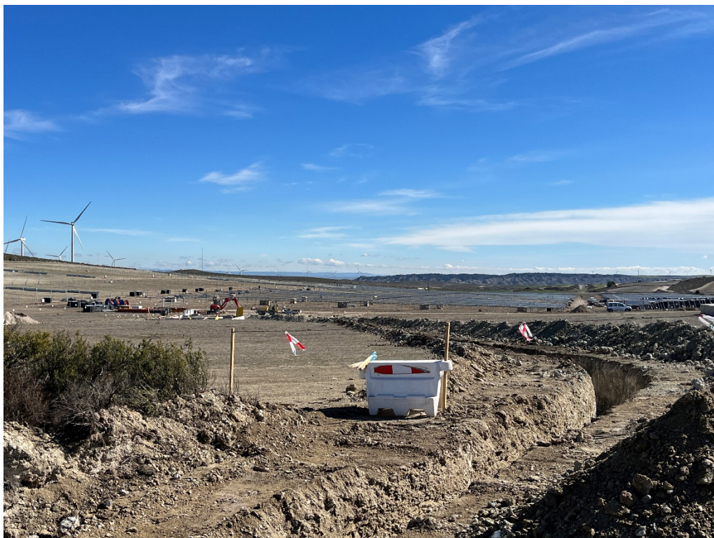
Figura 11 Zanja de la red de evacuación
