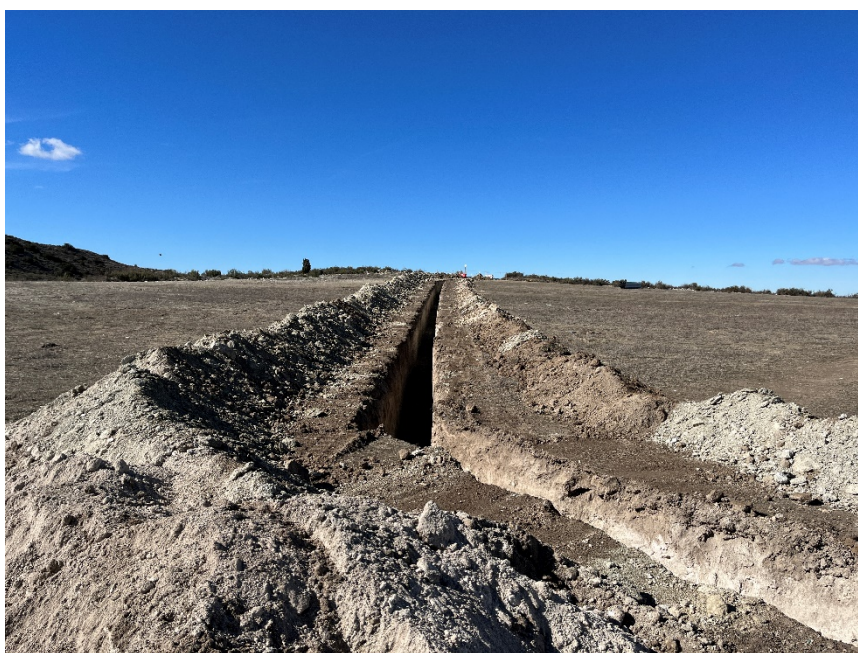
Figura 2 Apertura de zanjas para la red de evacuación
