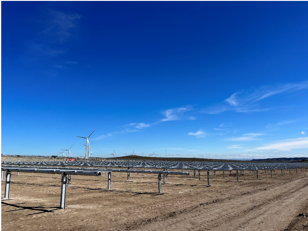
Figura 9 Montaje de los trackers
