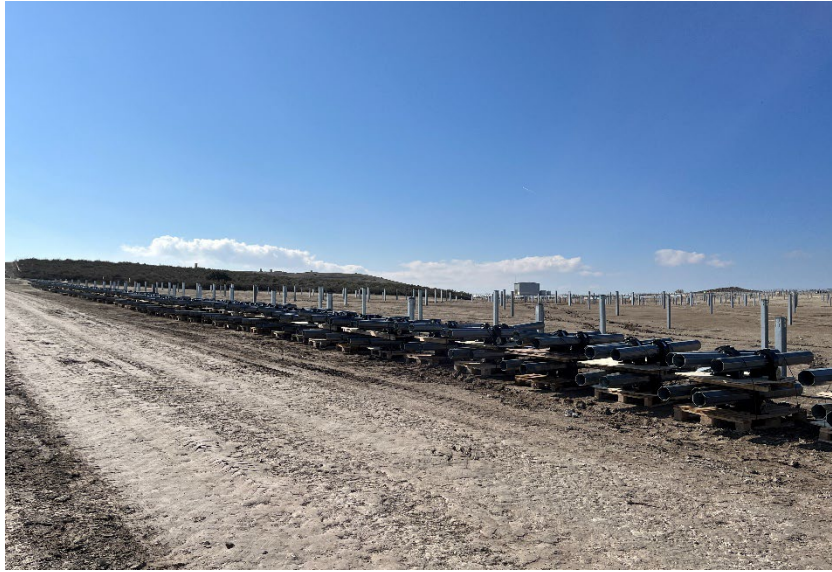
Figura 5 Zona de acopio de material de construcción
