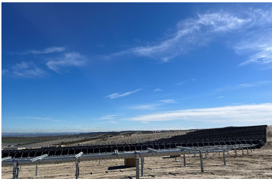
Figura 7 Montaje de los módulos fotovoltaicos
