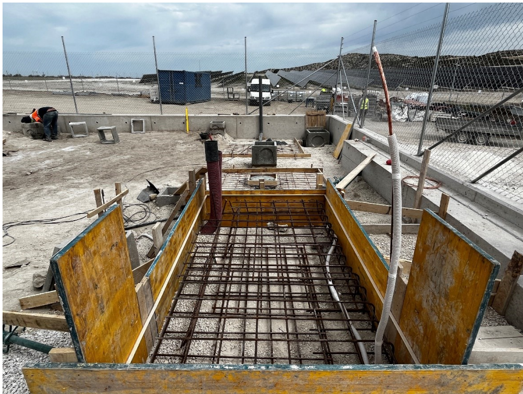
Figura 10 Trabajos de la SET
