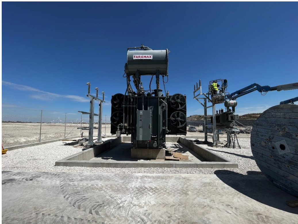
Figura 8 Montaje de la SET
