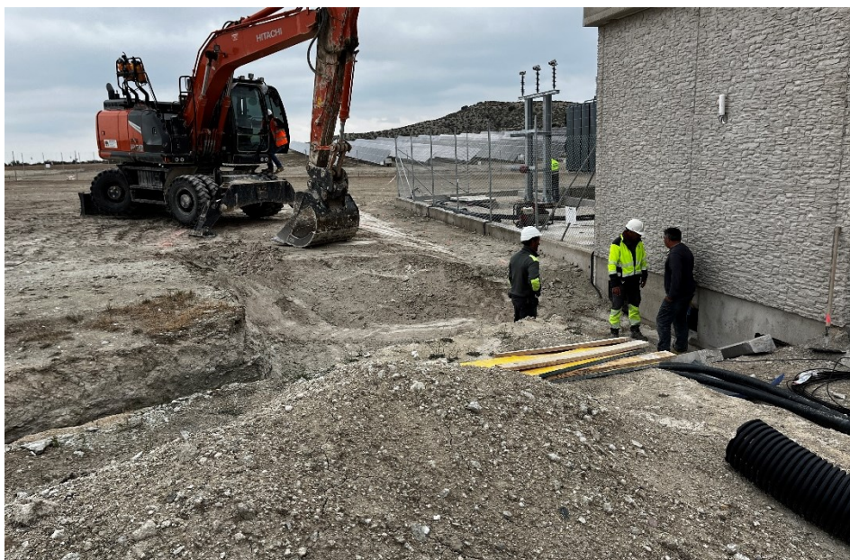
Figura 6 Apertura de zanjas para la evacuación
