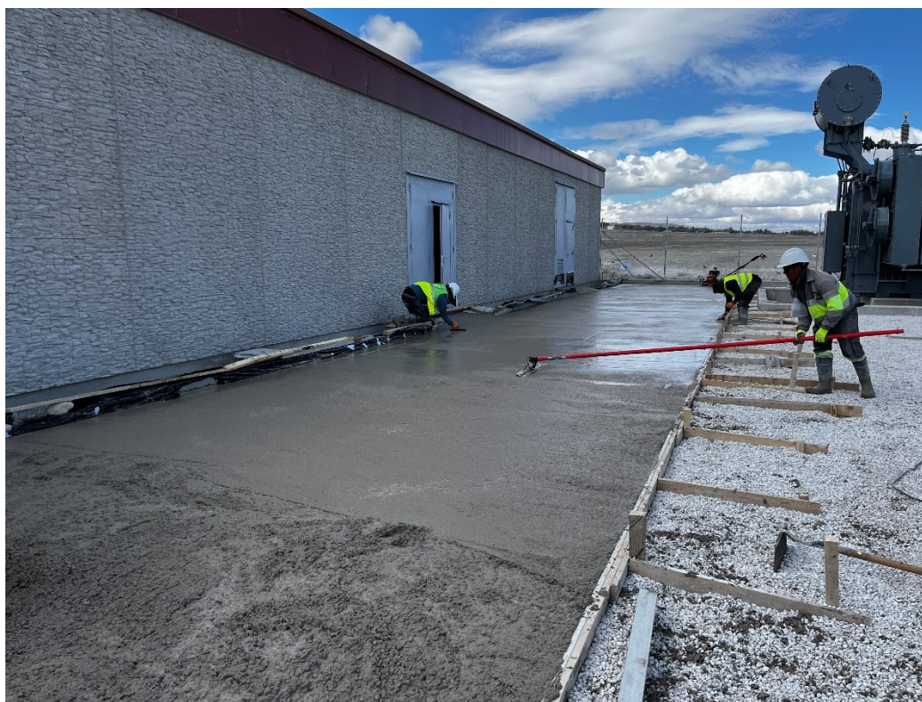
Figura 9 Cimentación del vial de la SET
