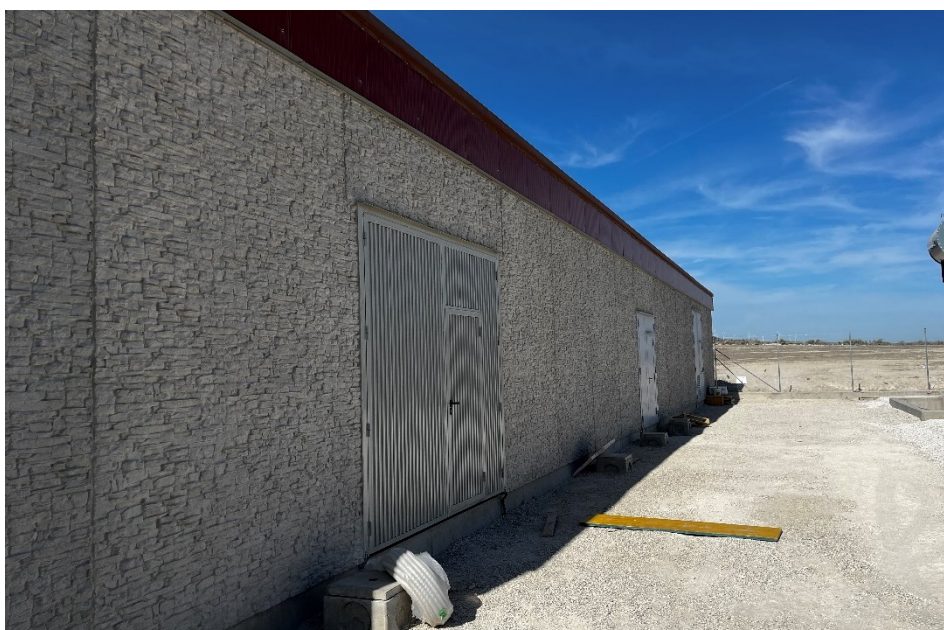
Figura 7 Montaje edificio de control de la SET
