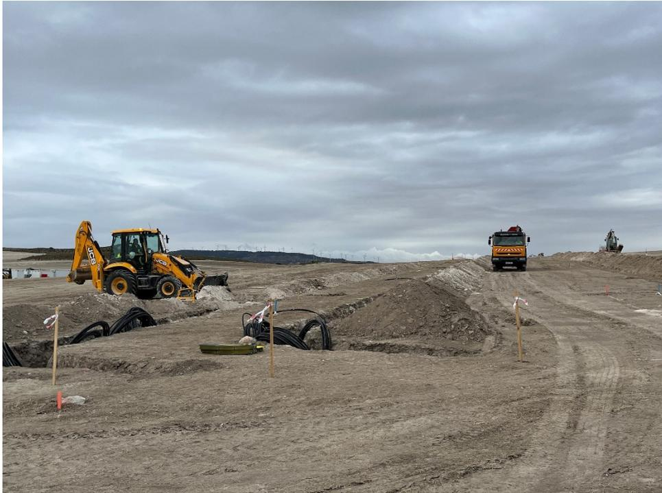
*Figura 10 Cableado de la red*
