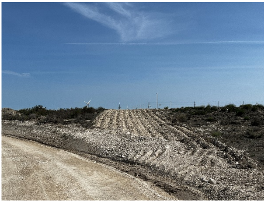
Figura 15 Restauración de accesos temporales
