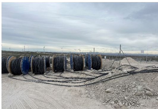
Figura 9 Tendido de cable de baja tensión
