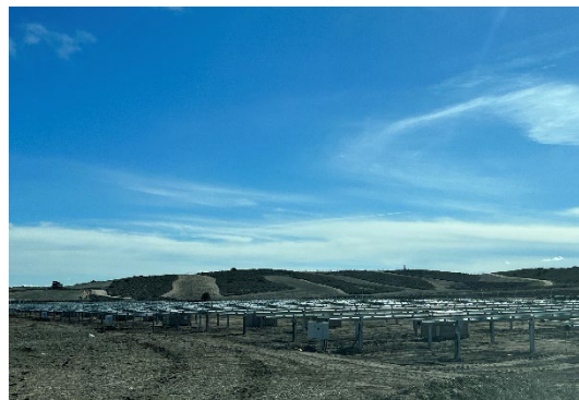
Figura 7 Montaje de los trackers
