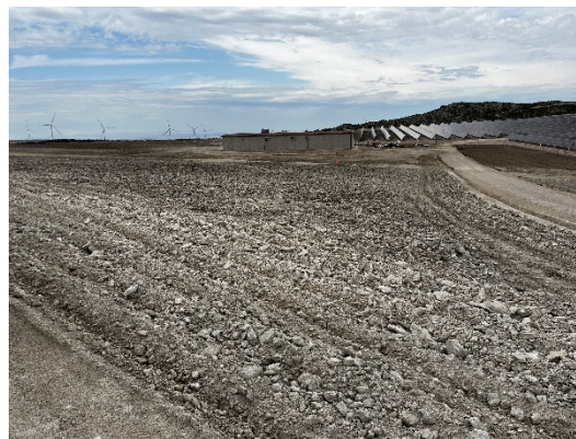
Figura 18 Descompactación del suelo
