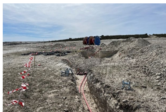
Figura 10 Tendido de cable de media tensión
