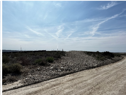
Figura 16 Restauración de accesos temporales
