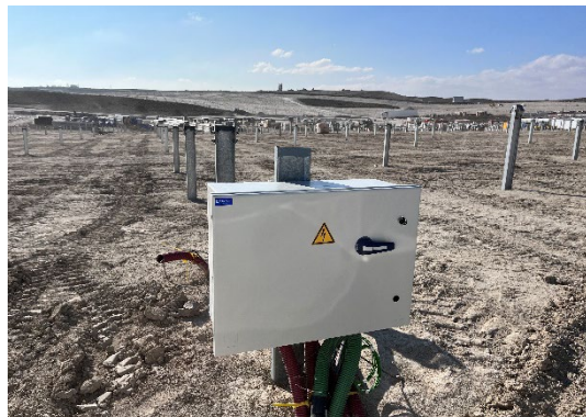
Figura 11 Montaje de los cuadros de control
