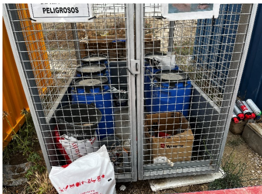
Figura 25 Punto limpio de residuos peligrosos
