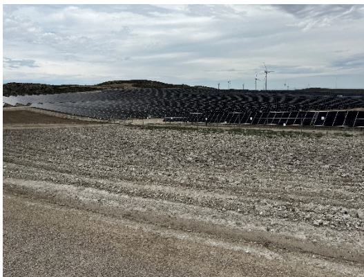
Figura 17 Descompactación del suelo
