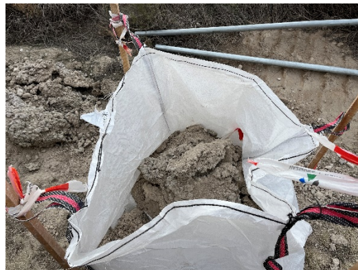
Figura 22 Retirada de los vertidos de hormigón
