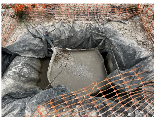
Figura 23 Lavadero de cubas de hormigón
