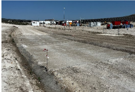
Figura 4 Trabajos de cimentación
