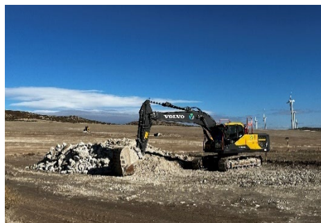
Figura 3 Apertura de zanjas
