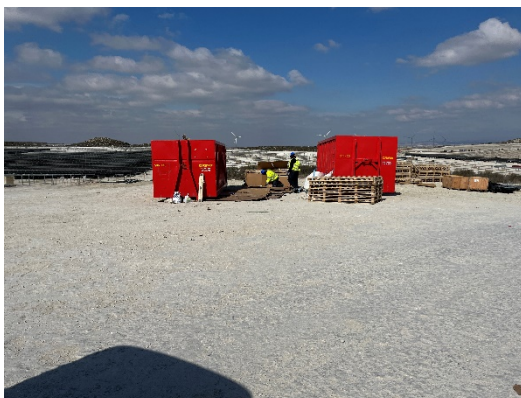
Figura 24 Punto limpio de RNP del PSFV
