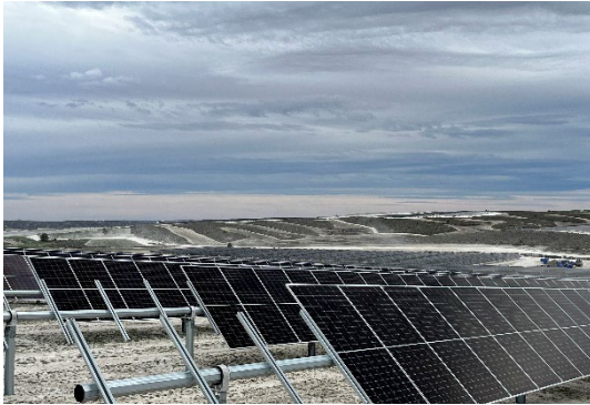
Figura 8 Montaje de los módulos fotovoltaicos
