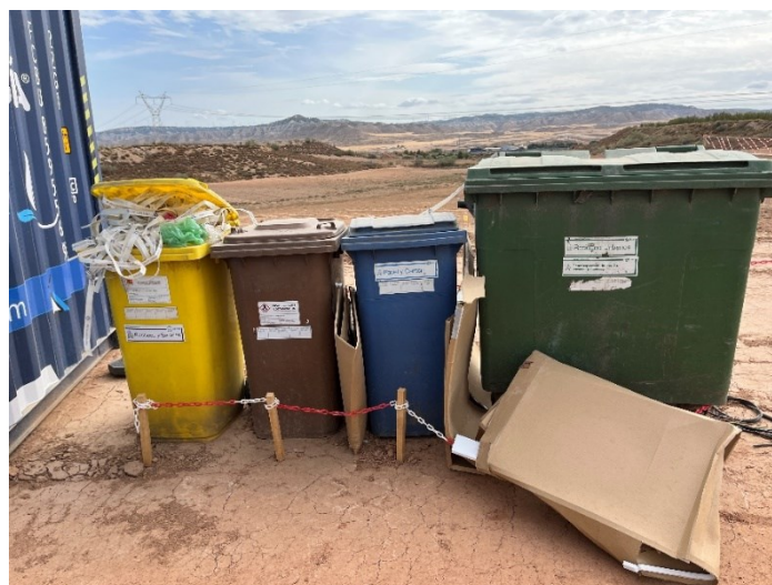
Figura 2 Punto limpio de residuos no peligrosos
