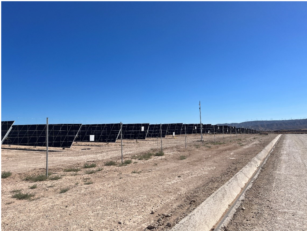
Figura 7 Colocación de las placas esteparias del vallado
