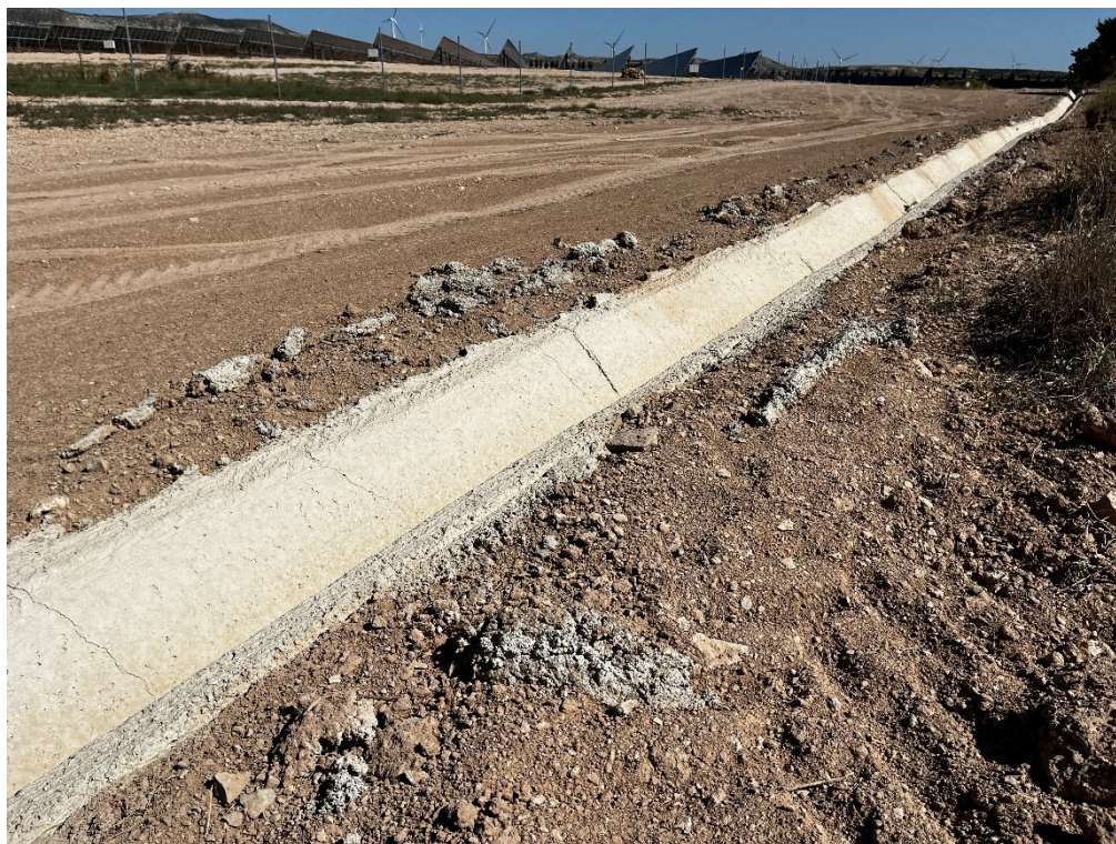
Figura 2 Apertura y cimentación de las cunetas
