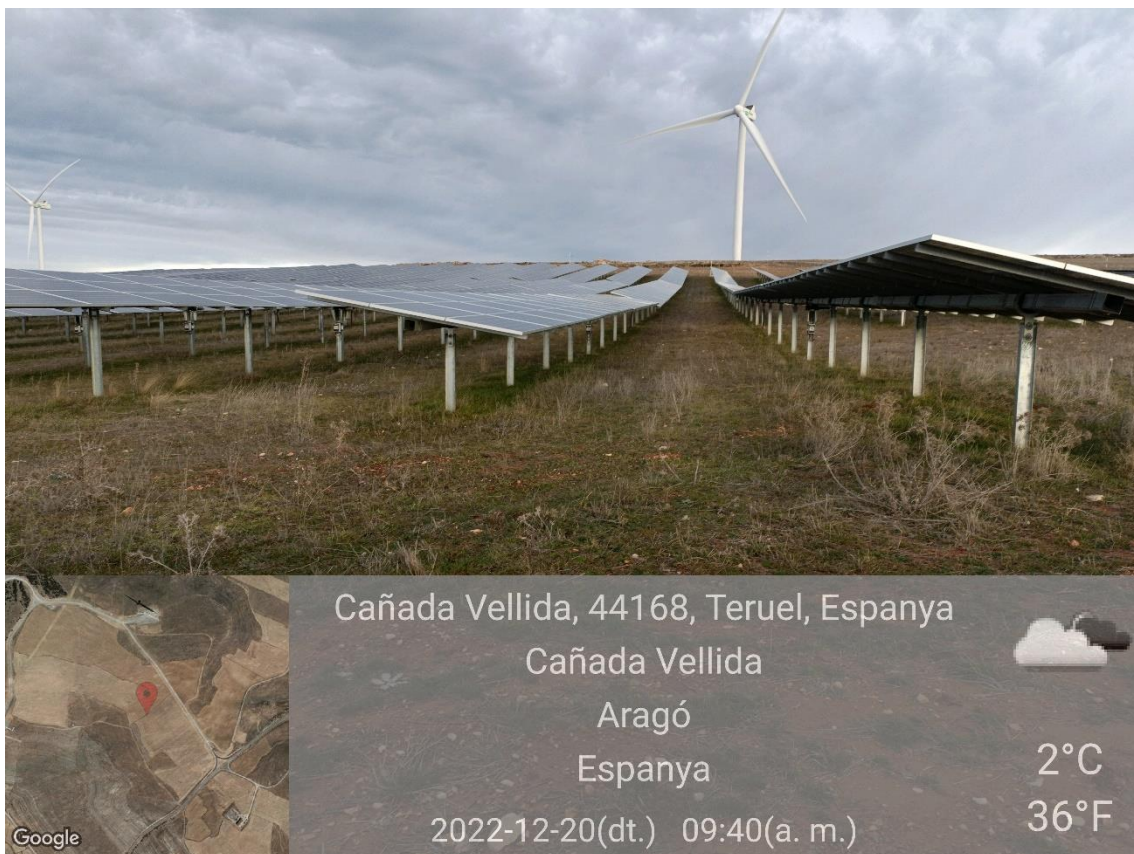
Ilustración 3. Zonas con vegetación natural entre placas
