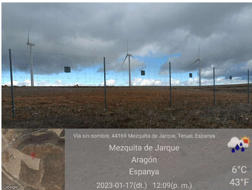
Ilustración 7. Placas anticollisión correctamente dispuestas en el vallado.
