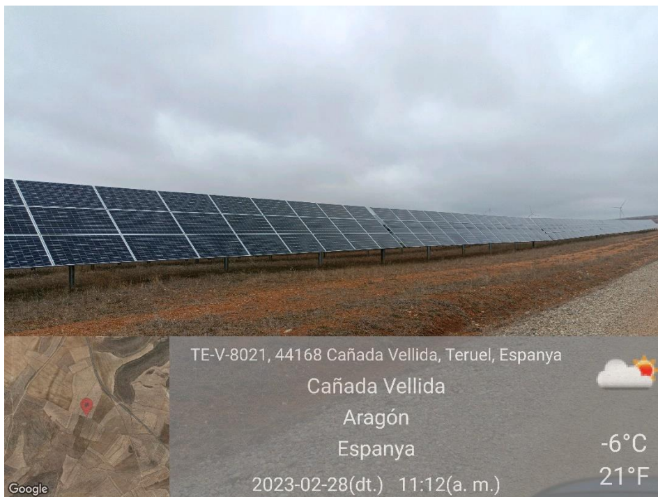
Ilustración 9. Viales en buen estado.
